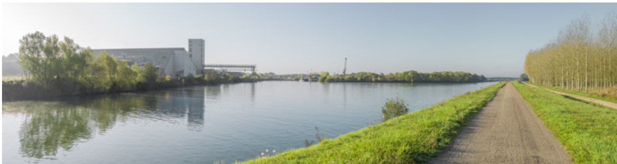
Vue d'ensemble du Technoport, rive droite, amont. L'entrée dans le port est en face et, à droite, la dérivation de Seurre. 21, Pagny-la-Ville, lieudit : PK 5.5D
