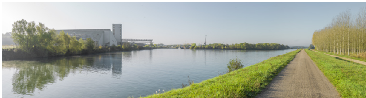
Vue d'ensemble du Technoport, rive droite, amont. L'entrée dans le port est en face et, à droite, la dérivation de Seurre. 21, Pagny-la-Ville, lieudit : PK 5.5D
