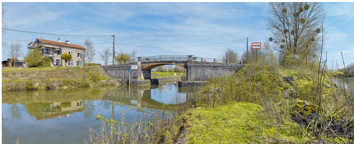
Vue d'ensemble depuis la sortie de la dérivation.
