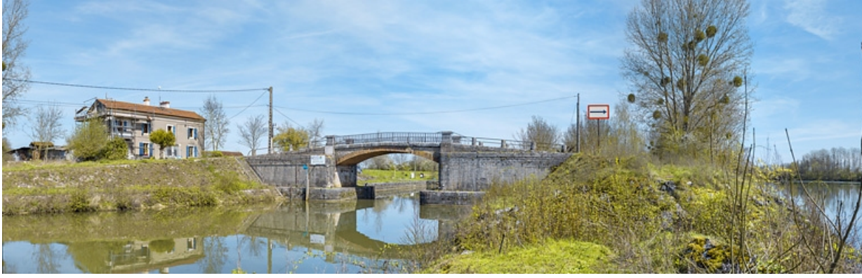
Vue d'ensemble d'aval : à gauche, la maison éclusière et à droite, la Saône. 21, Saint-Usage, lieudit : PK 211
