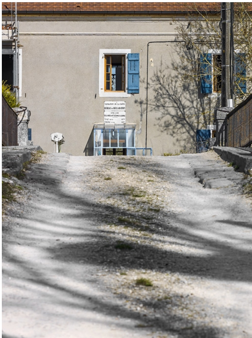
Maison éclusière : vue rapprochée sur la plaque.
