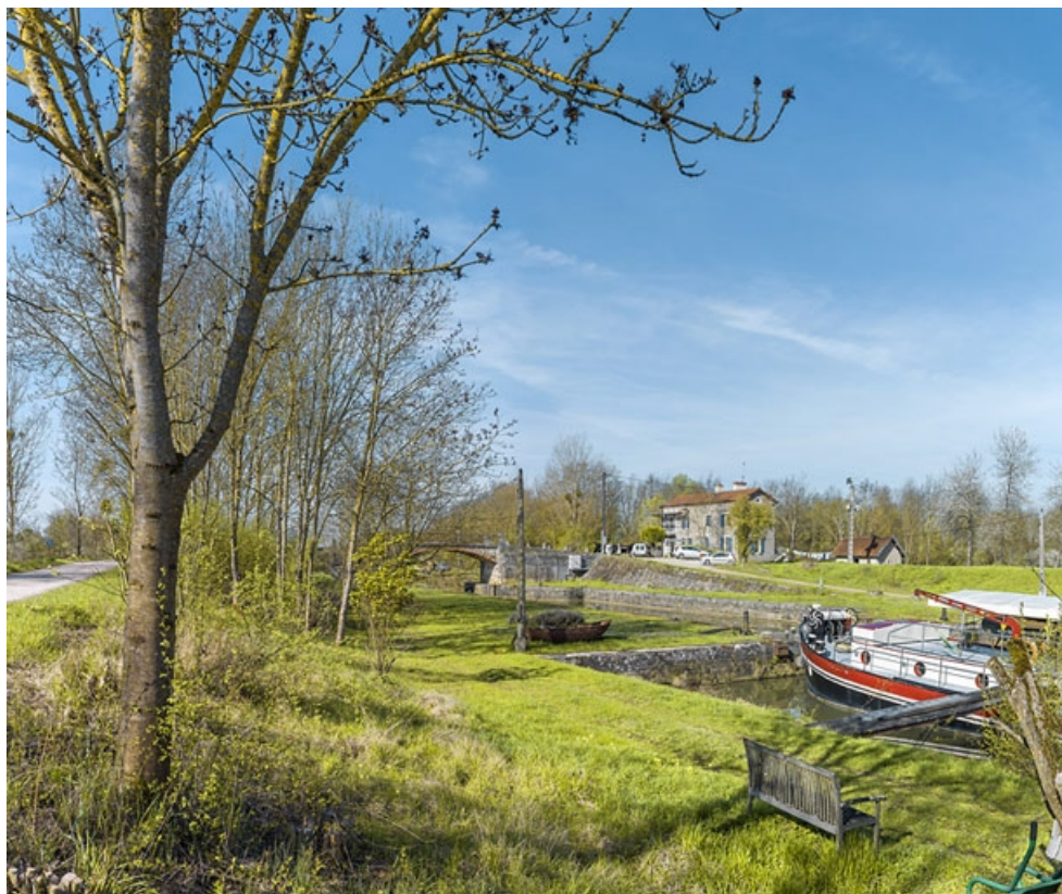
Le site d'écluse depuis le port.
