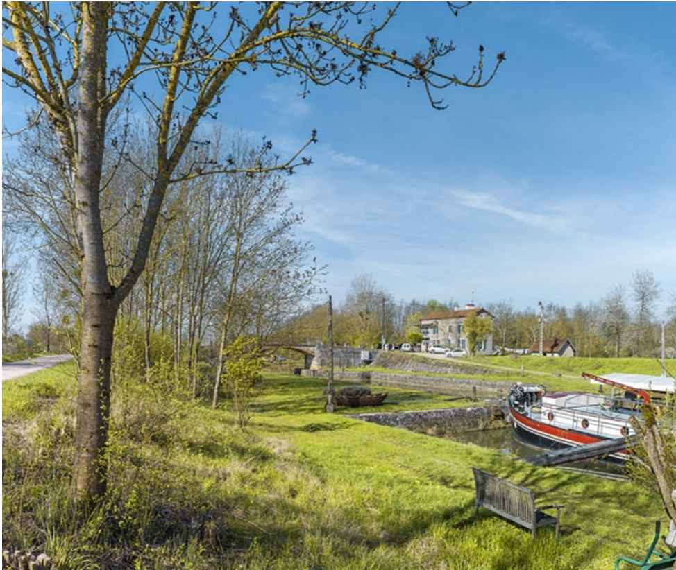
Le site d'écluse depuis le port.
