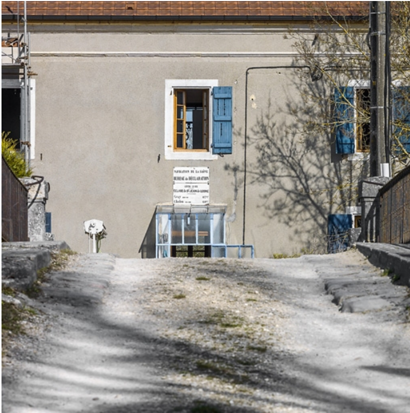
Maison éclusière : vue rapprochée sur la plaque.
