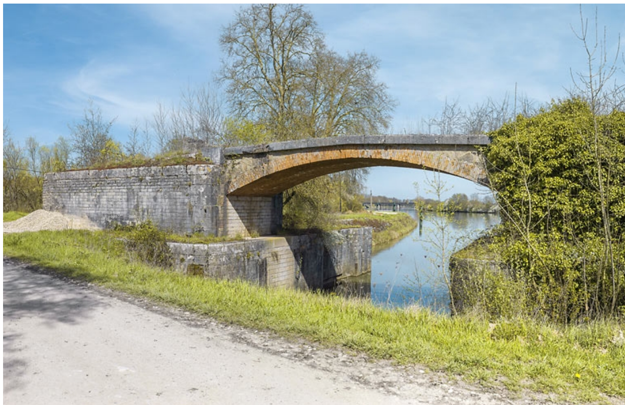
Vue d'ensemble. En arrière-plan le pont ferroviaire (IA21005578). 21, Saint-Usage, lieudit : PK 212
