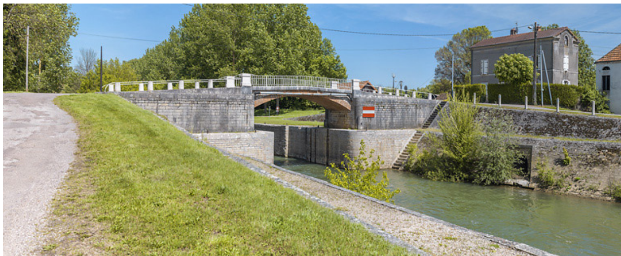
Vue d'ensemble du pont sur écluse, d'aval. A droite, la maison éclésièrè.
