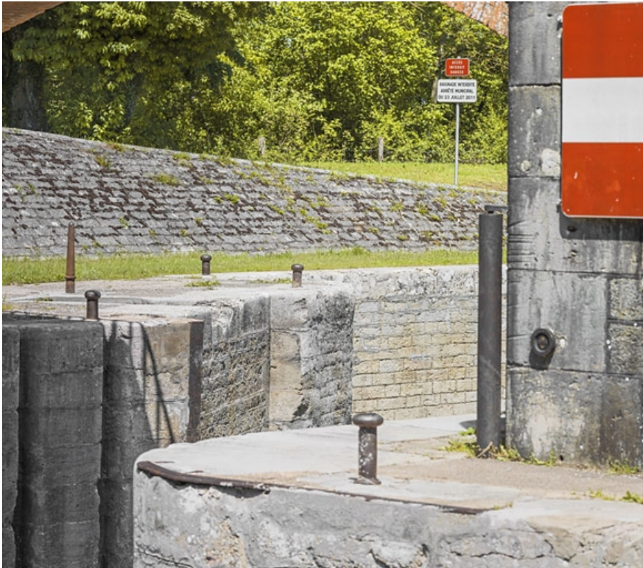
Détail des traces de halage et de la maçonnerie du sas.
