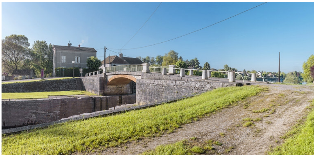
Vue d'ensemble du pont sur écluse. Au fond, la maison éclusière.
