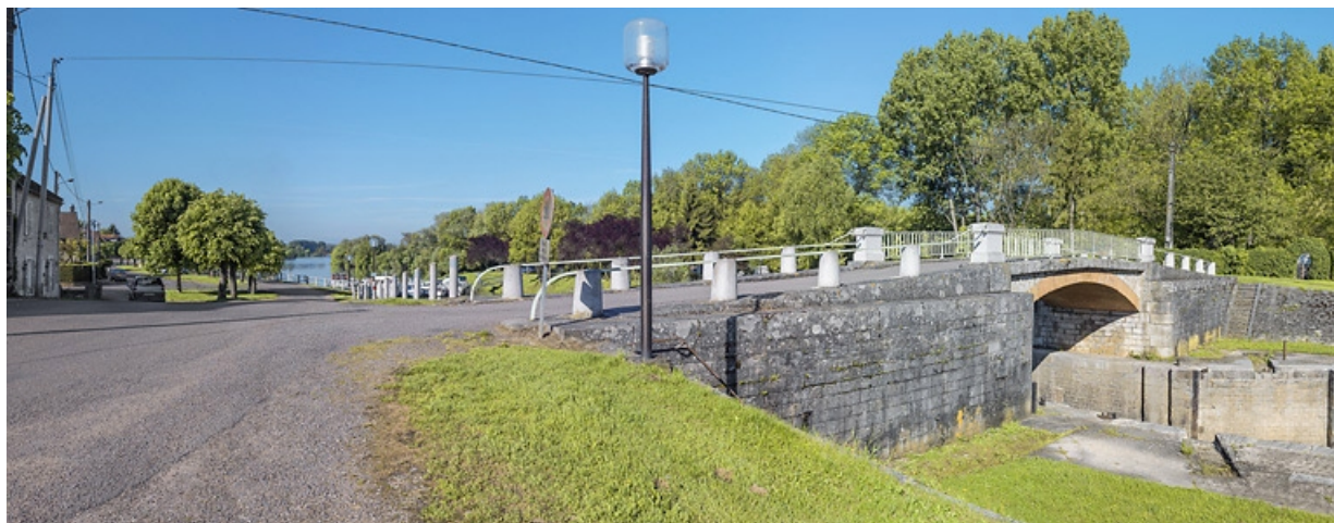
Vue d'ensemble du pont sur écluse. En arrière-plan, la halte nautique.
