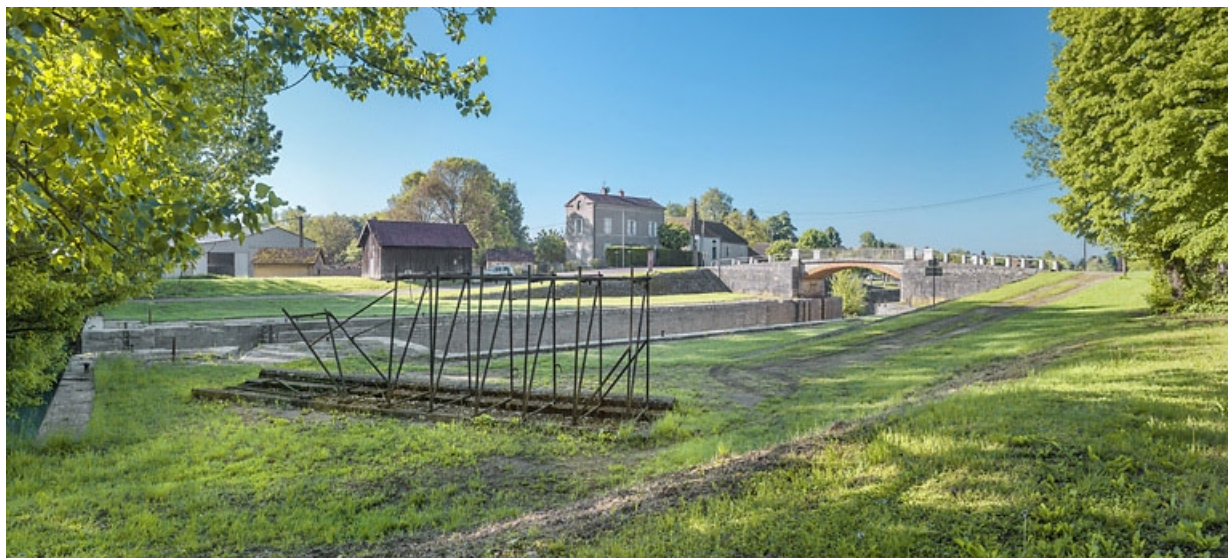
Vue d'ensemble du site. Au premier plan, vestiges des fermettes métalliques de l'ancien barrage mobile du Châtelet. 21, Lechâtelet, lieudit : PK 199
