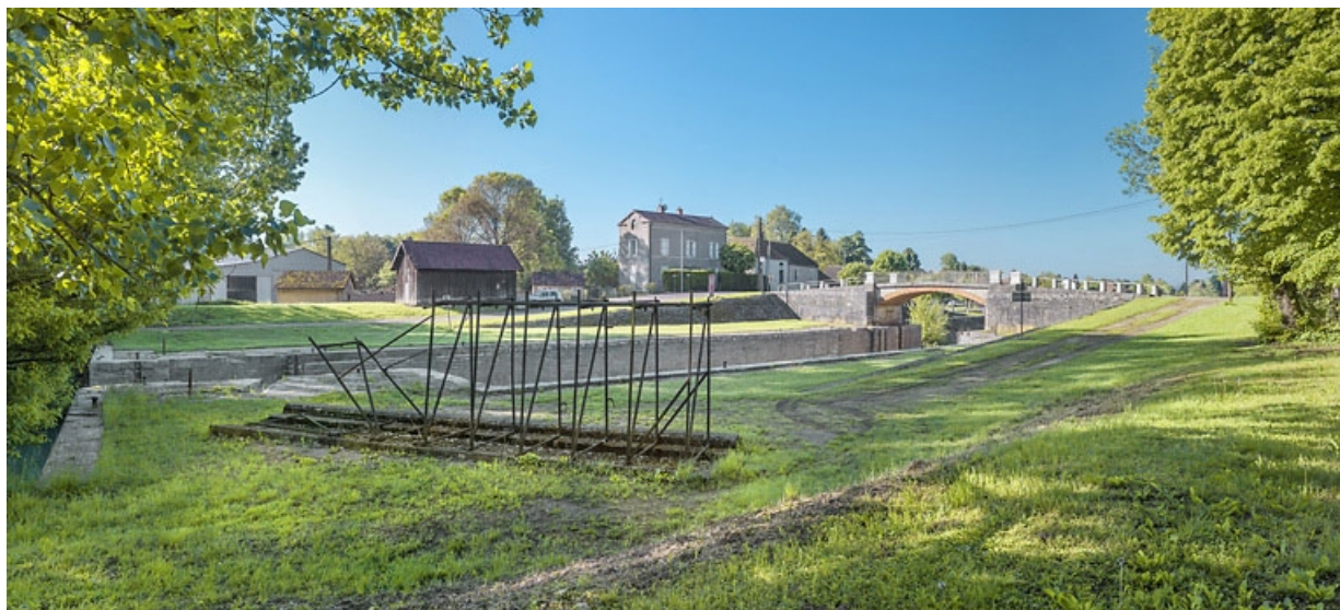
Vue d'ensemble du site. Au premier plan, vestiges des fermettes métalliques de l'ancien barrage mobile du Châtelet. 21, Lechâtelet, lieudit : PK 199
