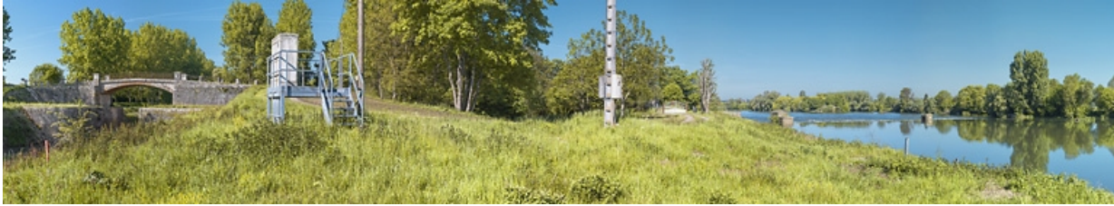
Vue panoramique avec à gauche, le pont et la porte de garde et à droite, l'ancien barrage du Châtelet.
