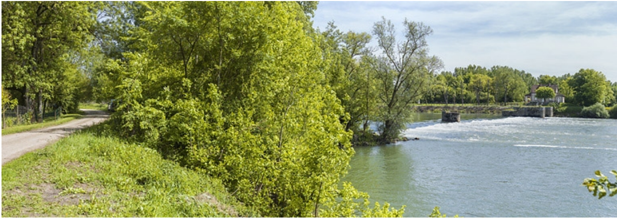
Vue d'ensemble de l'ancien barrage depuis la rive droite. A droite, la maison du barragiste. 21, Pagny-la-Ville, lieudit : PK 200
