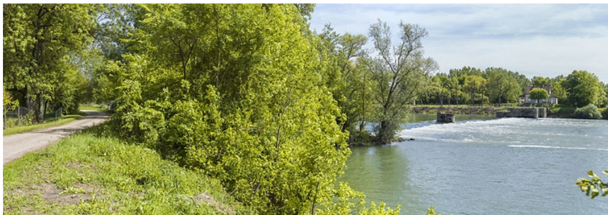
Vue d'ensemble de l'ancien barrage depuis la rive droite. A droite, la maison du barragiste.
