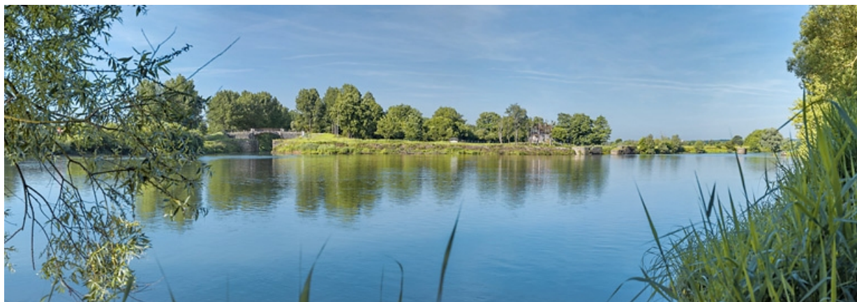
Vue d'ensemble de l'entrée de la dérivation, à hauteur du barrage. A gauche, la porte de garde et le pont l'enjambant. 21, Pagny-la-Ville, lieudit : PK 199
