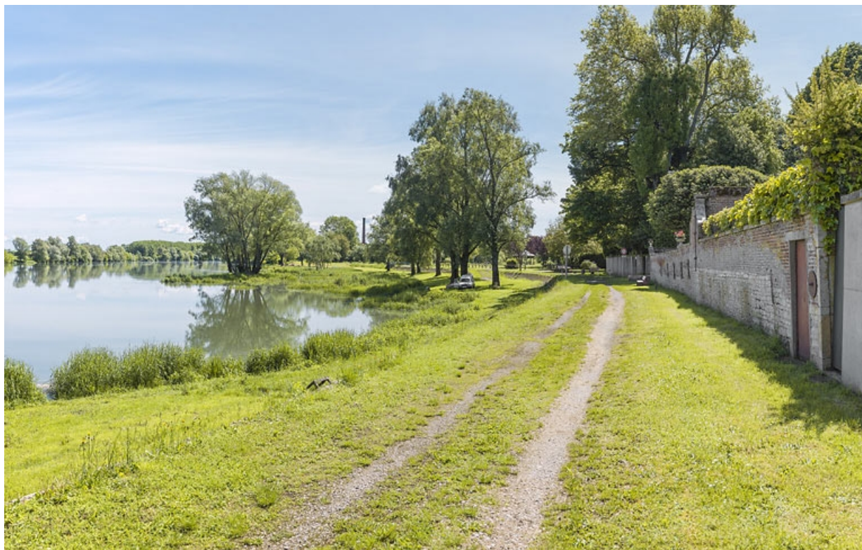
Chemin de halage sur la digue et murs de limite des propriétés longeant la Saône. 21, Pagny-la-Ville
