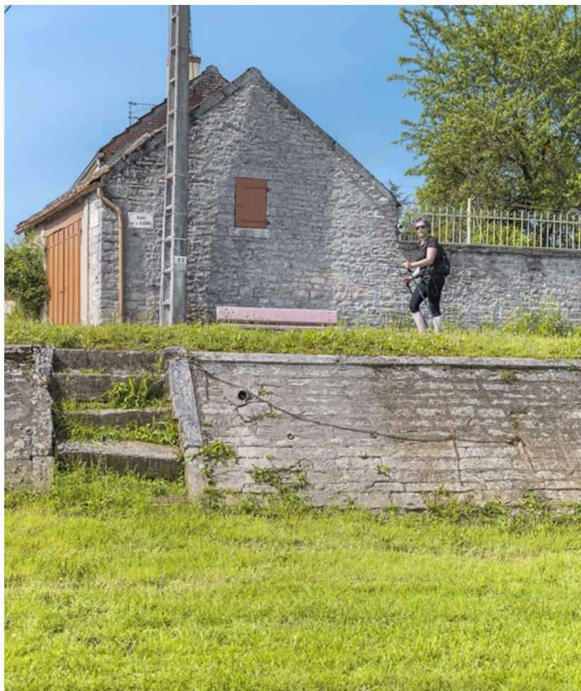
Escalier de sauvetage. 21, Pagny-la-Ville
