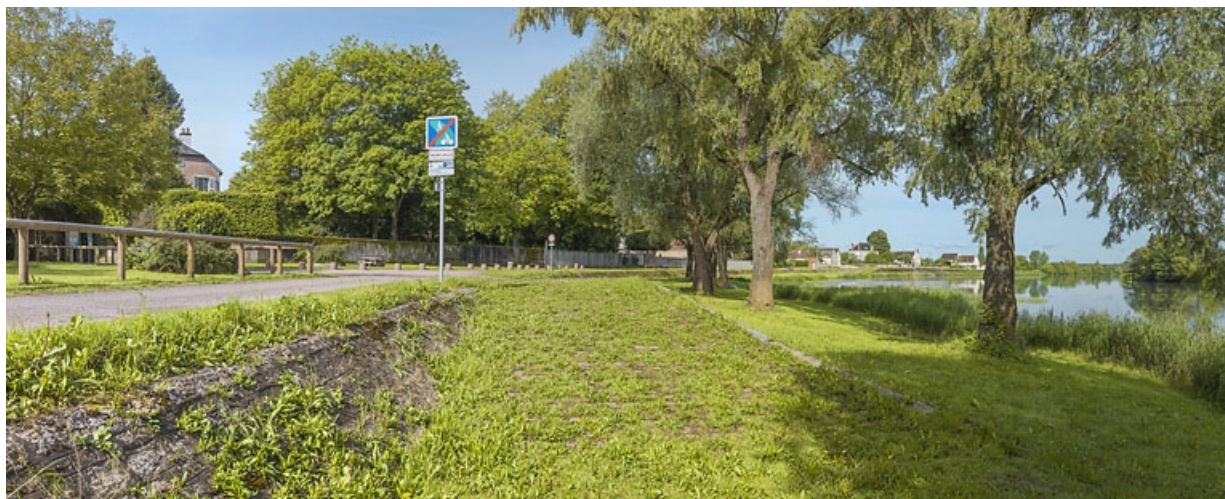
Rampe d'abreuvoir en partie recouverte par la végétation, en amont de la digue.
