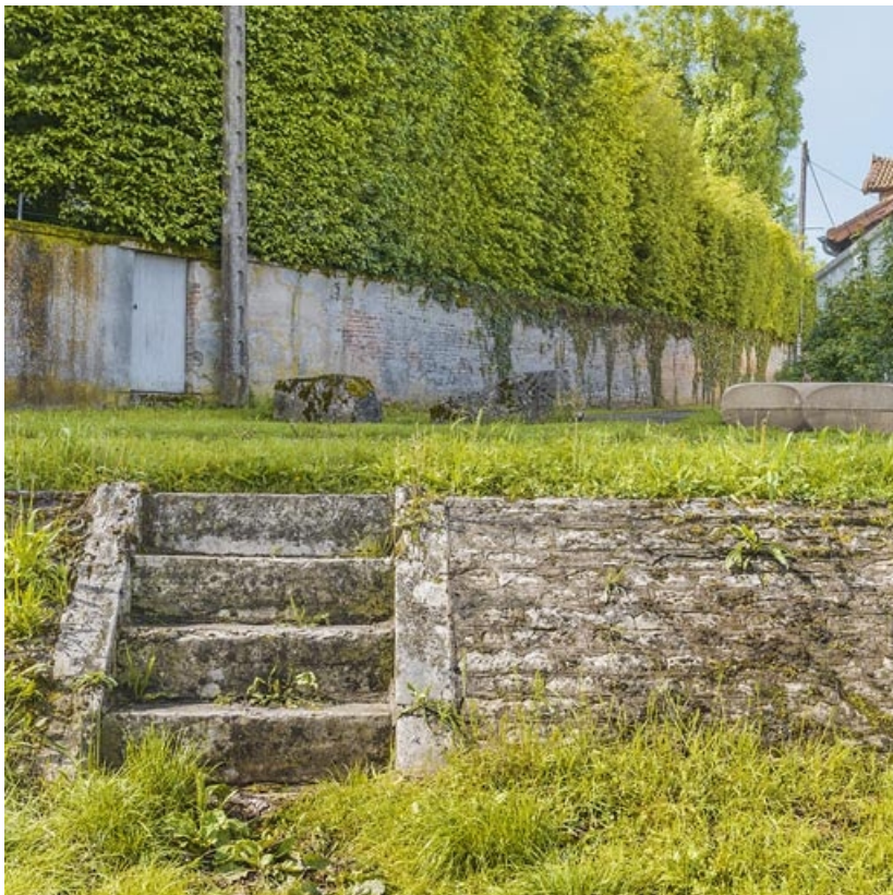
Deuxième escalier de la digue.
