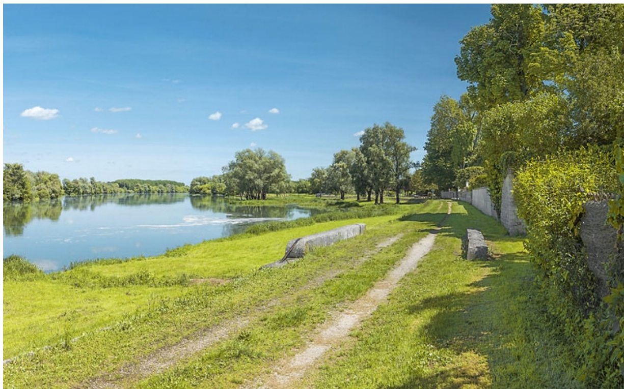
Le deuxième ponceau, vu d'aval.
