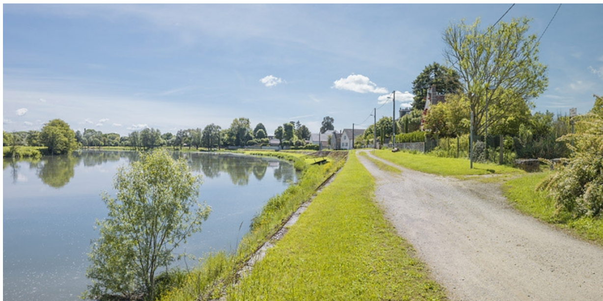
Vue d'ensemble de la digue, prise d'aval.
