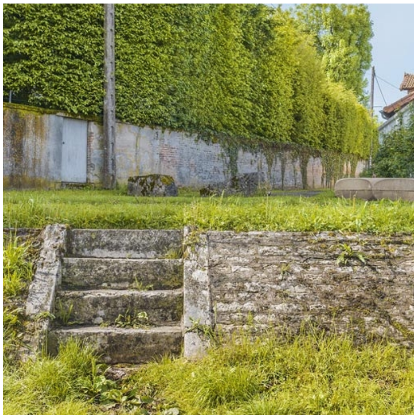
Deuxième escalier de la digue.
