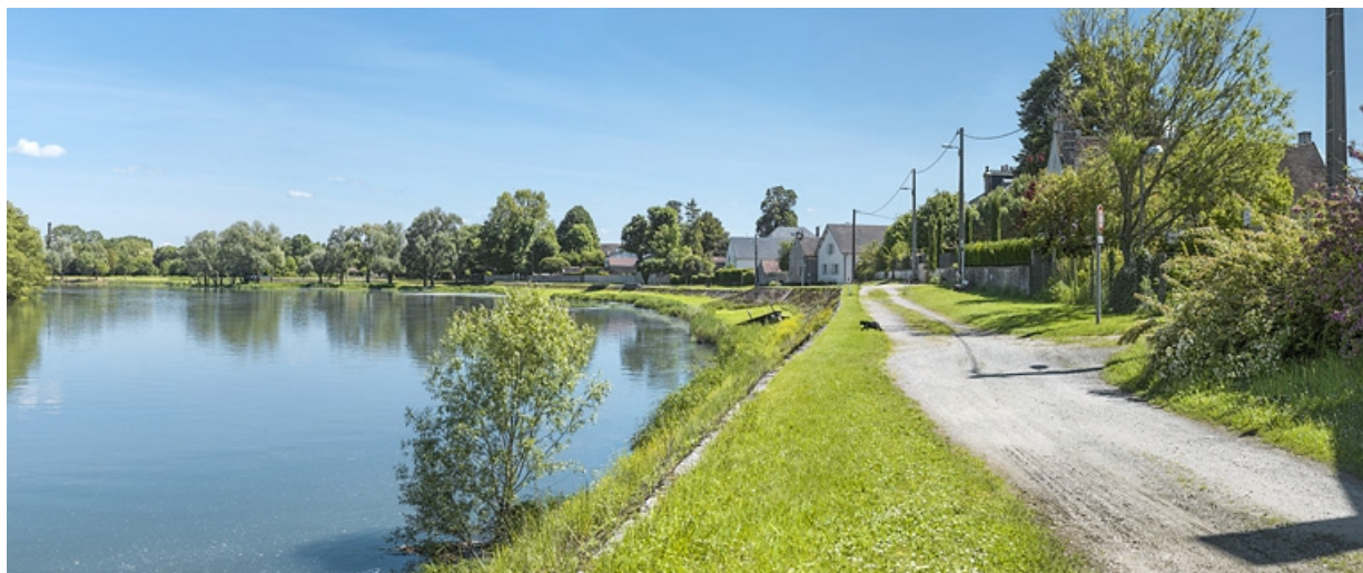
Vue d'ensemble de la digue, prise d'aval.
