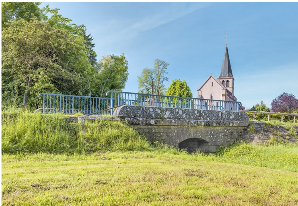
Ponceau et escalier en amont de la digue.
