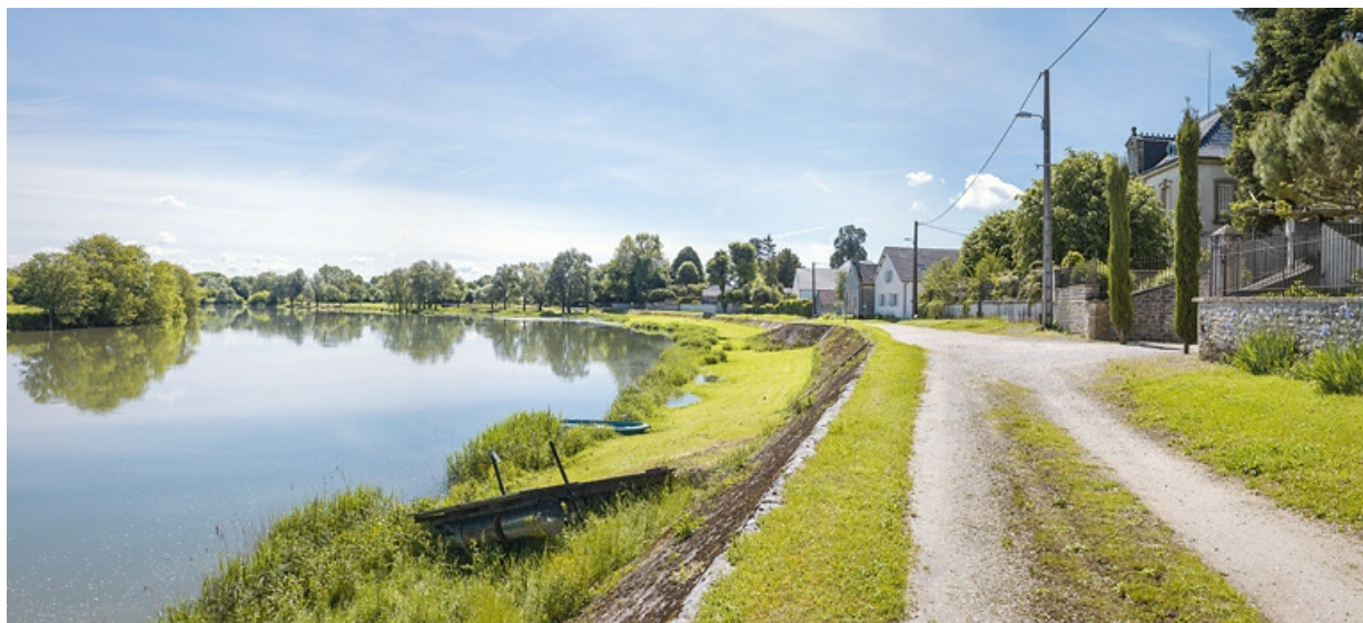
Vue d'ensemble de la digue, prise d'aval.
