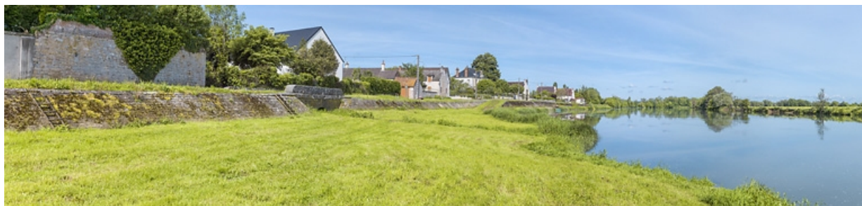
Vue d'ensemble de toute la longueur de la digue.
