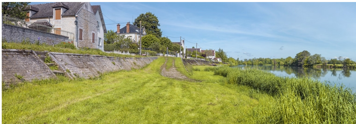
Escalier et digue en aval du ponceau.
