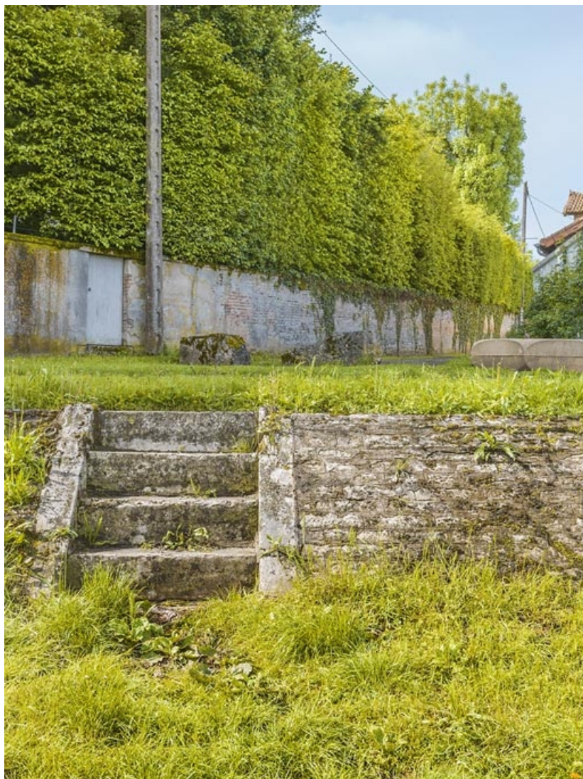
Deuxième escalier de la digue.
