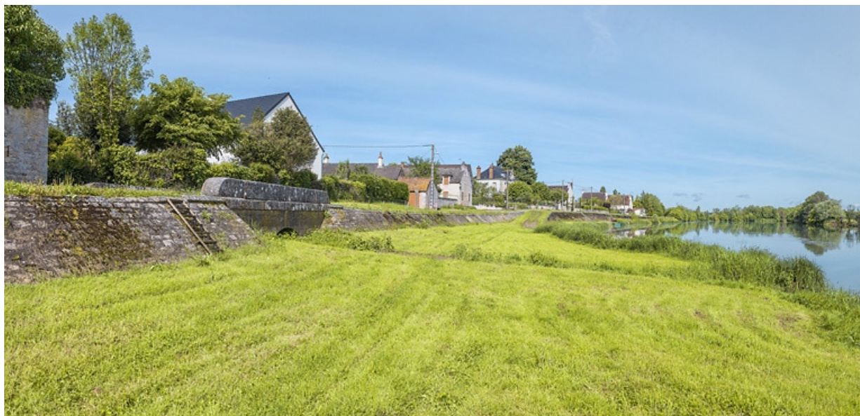
Ponceau au milieu de la digue.
