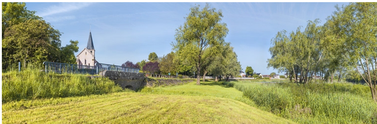
Ponceau supportant le chemin de halage au début de la digue. Le village en arrière-plan avec l'église Saint-Léger. 21, Pagny-la-Ville
