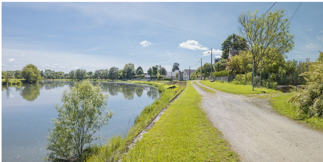
Vue d'ensemble de la digue, prise d'aval.
