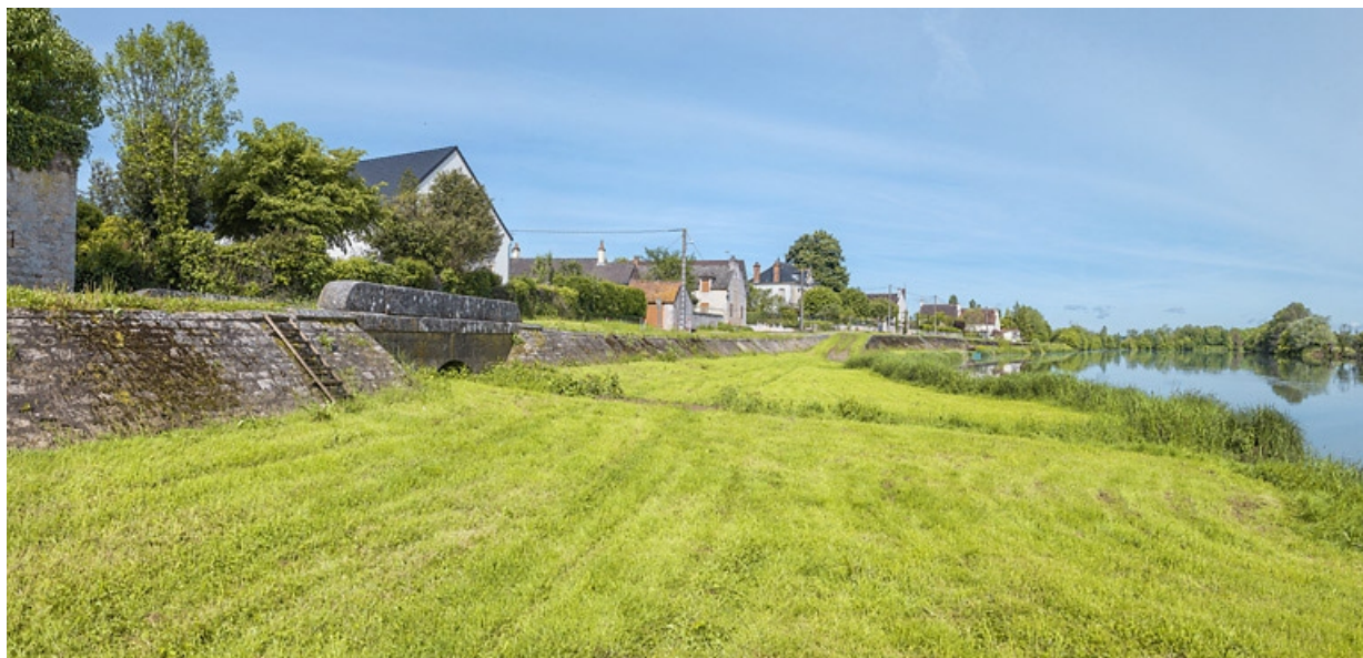
Ponceau au milieu de la digue.
