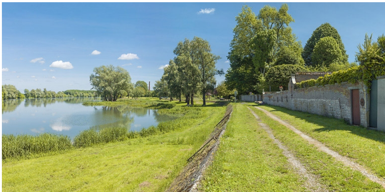
Chemin de halage, digue et murs de limite des propriétés longeant la Saône.
