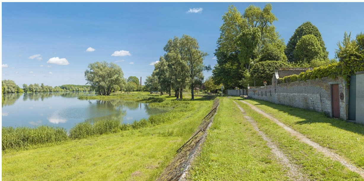
Chemin de halage, digue et murs de limite des propriétés longeant la Saône. 21, Pagny-la-Ville
