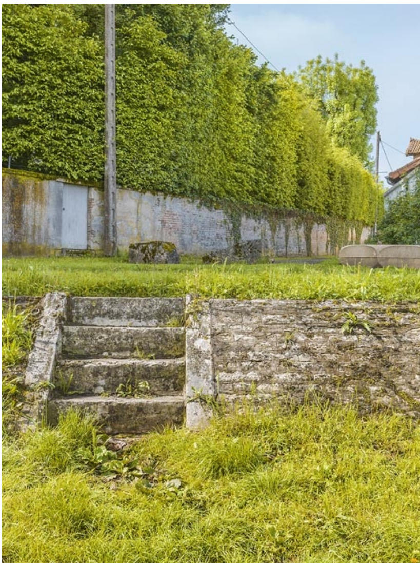
Deuxième escalier de la digue.
