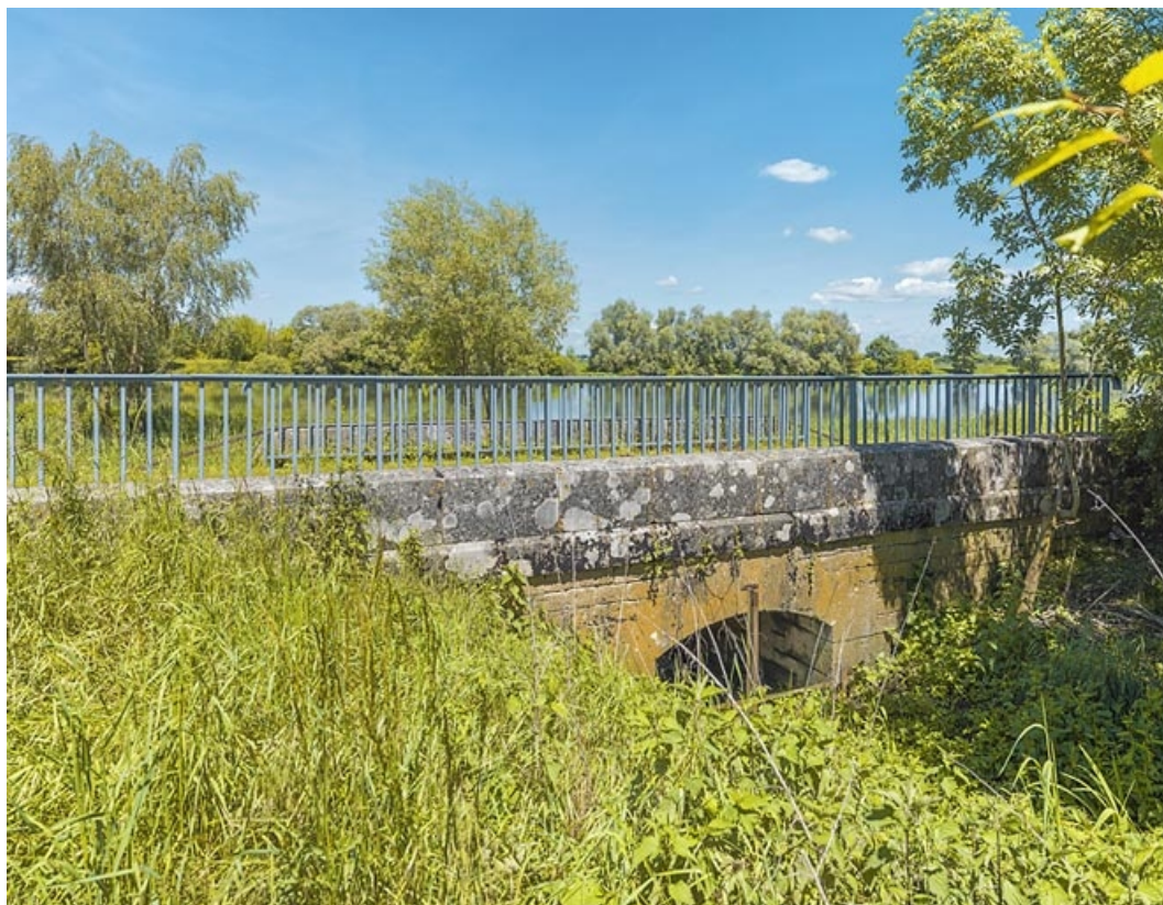
Ponceau en amont de la digue, vu depuis le côté opposé à la rivière. 21, Pagny-la-Ville
