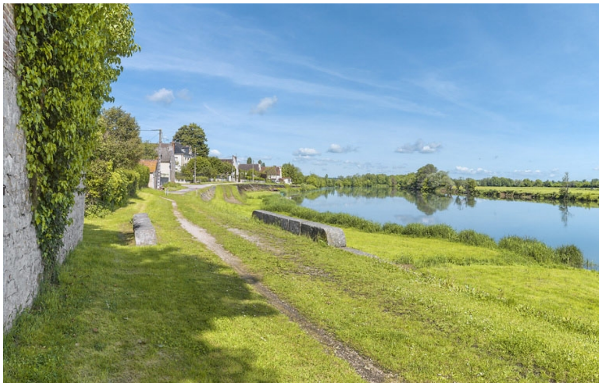
La digue et la Saône vus depuis le ponceau, au niveau du village.
