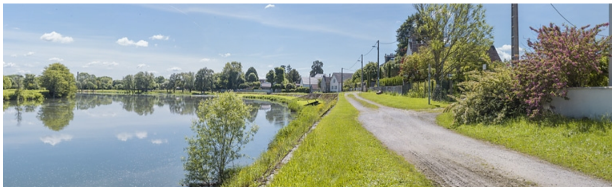
Vue d'ensemble de la digue, prise d'aval.
