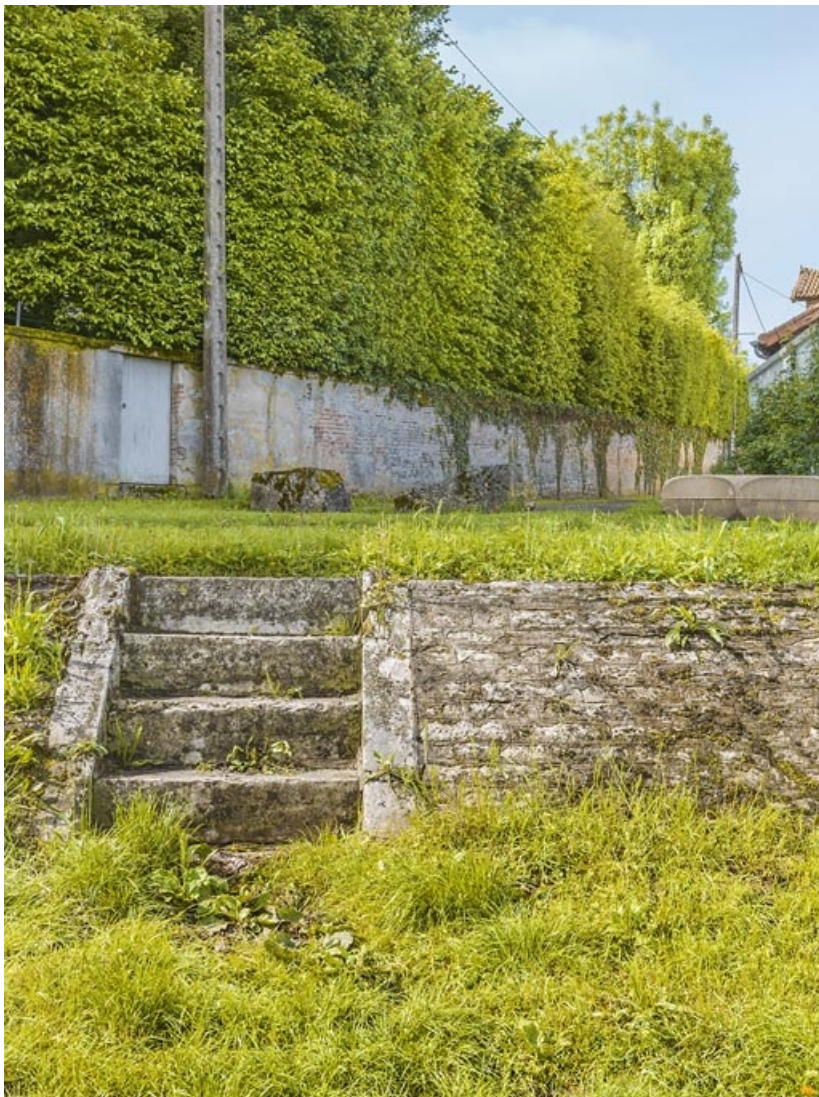
Deuxième escalier de la digue.
