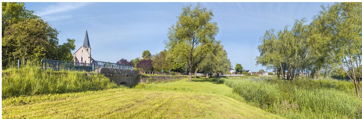
Ponceau supportant le chemin de halage au début de la digue. Le village en arrière-plan avec l'église Saint-Léger. 21, Pagny-la-Ville
