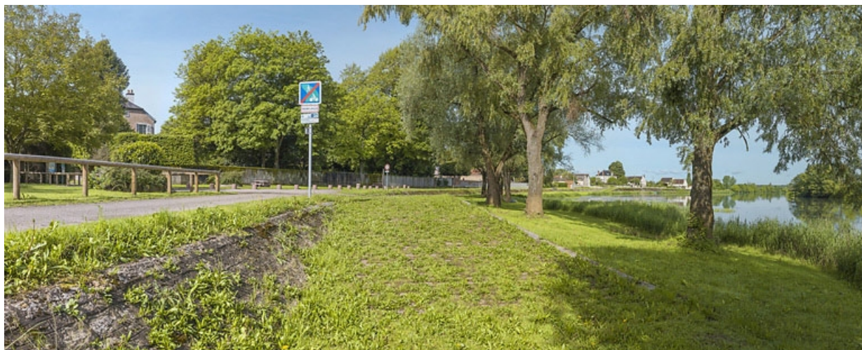
Rampe d'abreuvoir en partie recouverte par la végétation, en amont de la digue.
