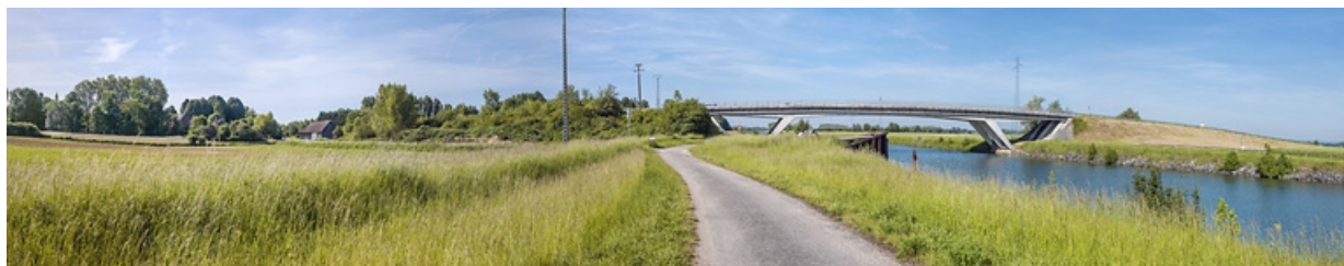
Vue d'ensemble d'amont, rive gauche. A gauche, on distingue la chapelle de Pagny-le-Château. 21, Pagny-le-Château, lieudit : PK 7.5D
