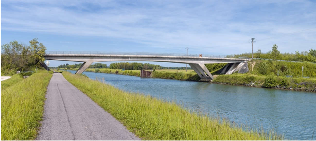
Vue d'ensemble d'amont, rive gauche. 21, Pagny-le-Château, lieudit : PK 7.5D
