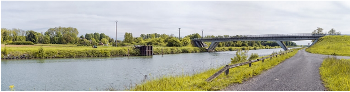
Vue d'ensemble d'aval, rive droite. A gauche, on distingue la chapelle de Pagny-le-Château. 21, Pagny-le-Château, lieudit : PK 7.5D
