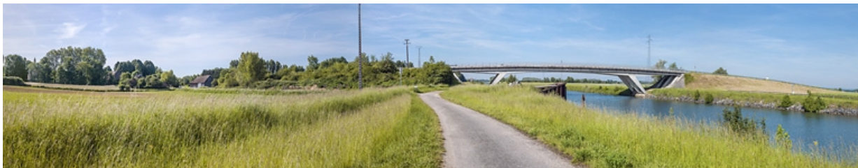
Vue d'ensemble d'amont, rive gauche. A gauche, on distingue la chapelle de Pagny-le-Château. 21, Pagny-le-Château, lieudit : PK 7.5D
