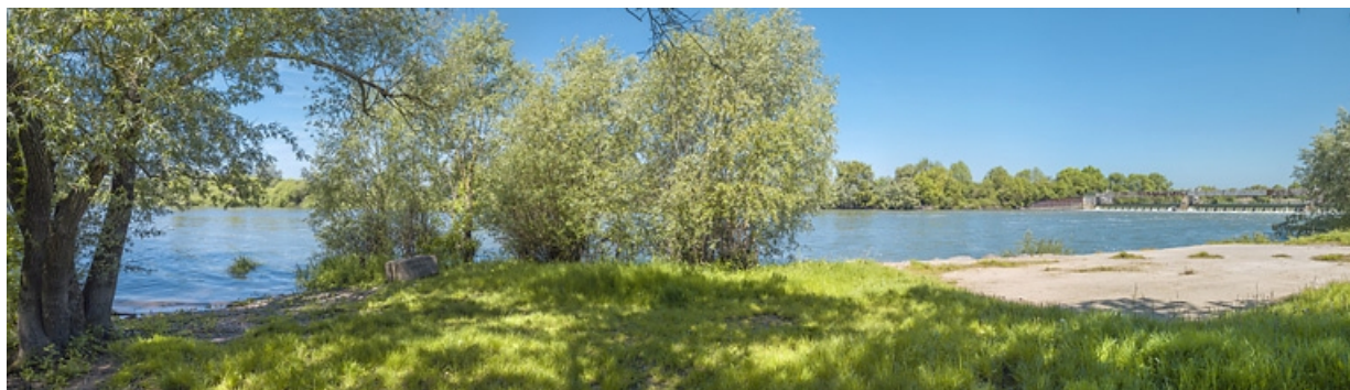
Vue d'ensemble du barrage dans son environnement, vu d'aval.
