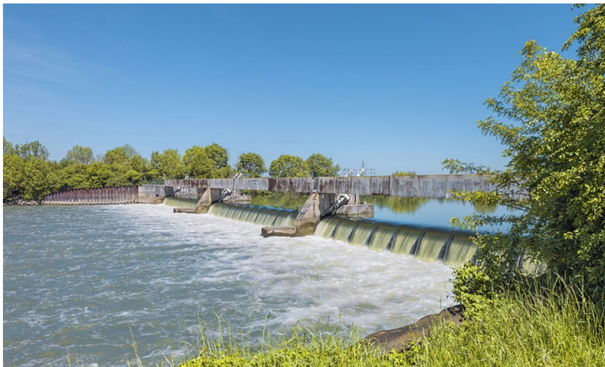
Vue d'ensemble du barrage, vu depuis la dérivation de Seurre.
