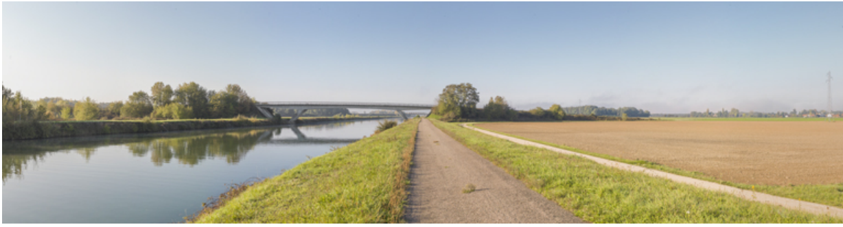
Vue d'ensemble de la dérivation au niveau du pont d'accès au Technoport. 21, Seurre
