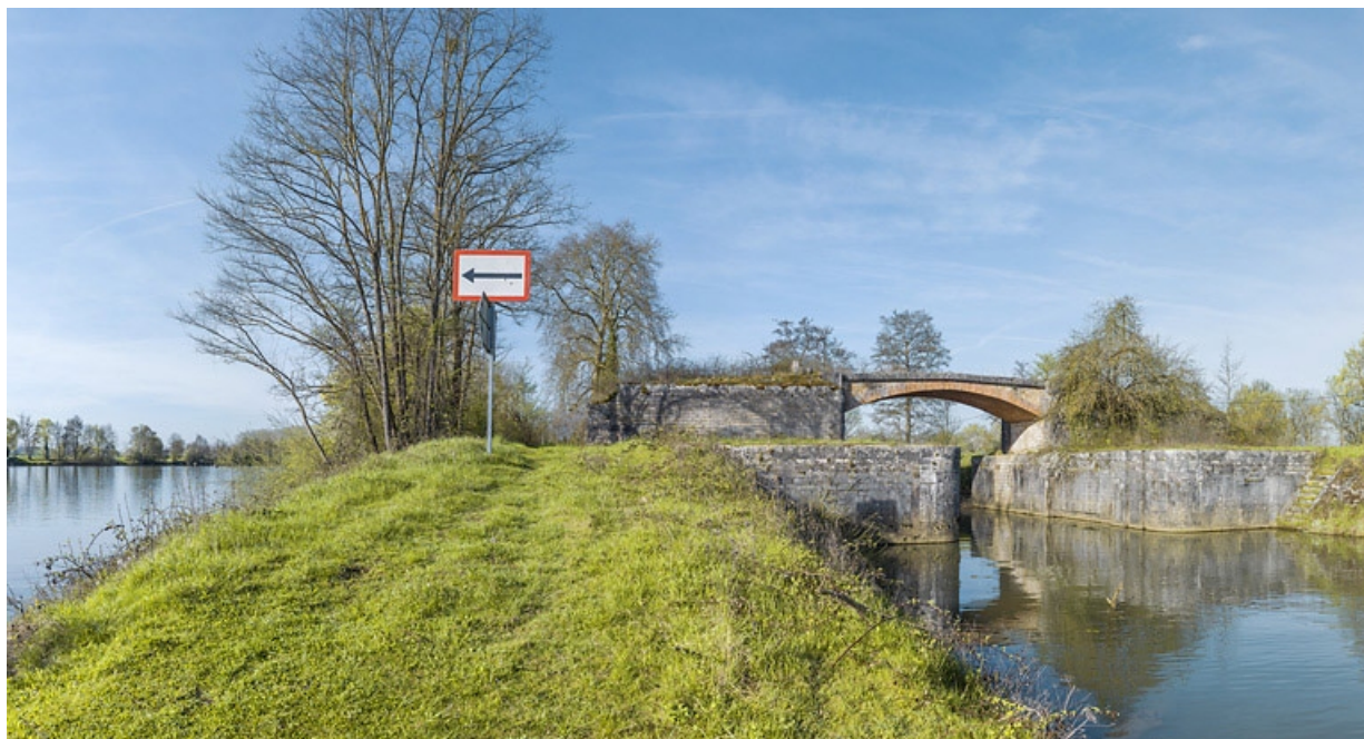
L'entrée de l'ancienne dérivation, rive droite.
