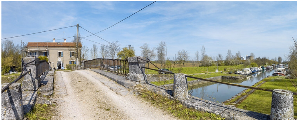
La sortie de la dérivation depuis le pont sur l'écluse. A droite, le port.
