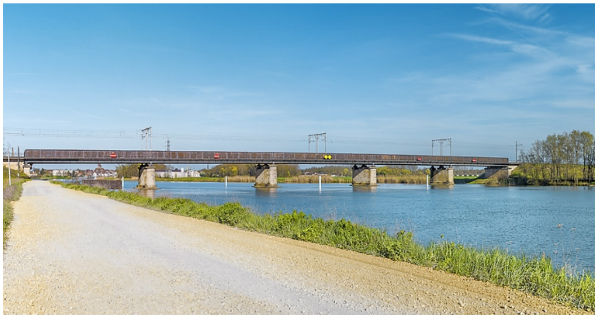
Vue d'ensemble d'aval, depuis la rive droite. Au fond, le village de Losne. 21, Saint-Usage, lieudit : PK 213,6
