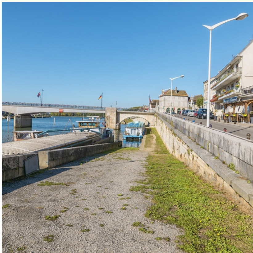
Arche maçonnée du pont, rive droite.
