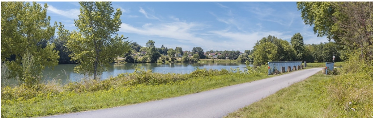
Vue d'ensemble du pont biais. A gauche, la Saône.
