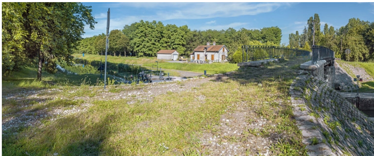
Vue d'ensemble. La maison éclusière en arrière-plan.
