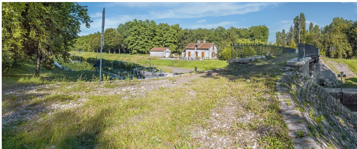
Vue d'ensemble. La maison éclusière en arrière-plan.
