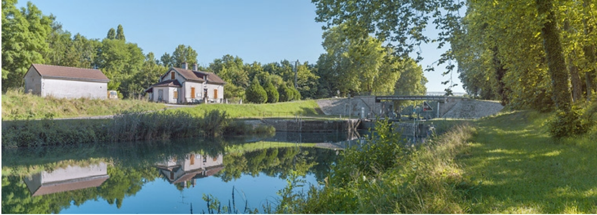
Vue d'ensemble : à gauche, la maison éclésièrre et au centre, le sas et le pont sur écluse. 21, Auxonne, lieudit : PK 229,8
