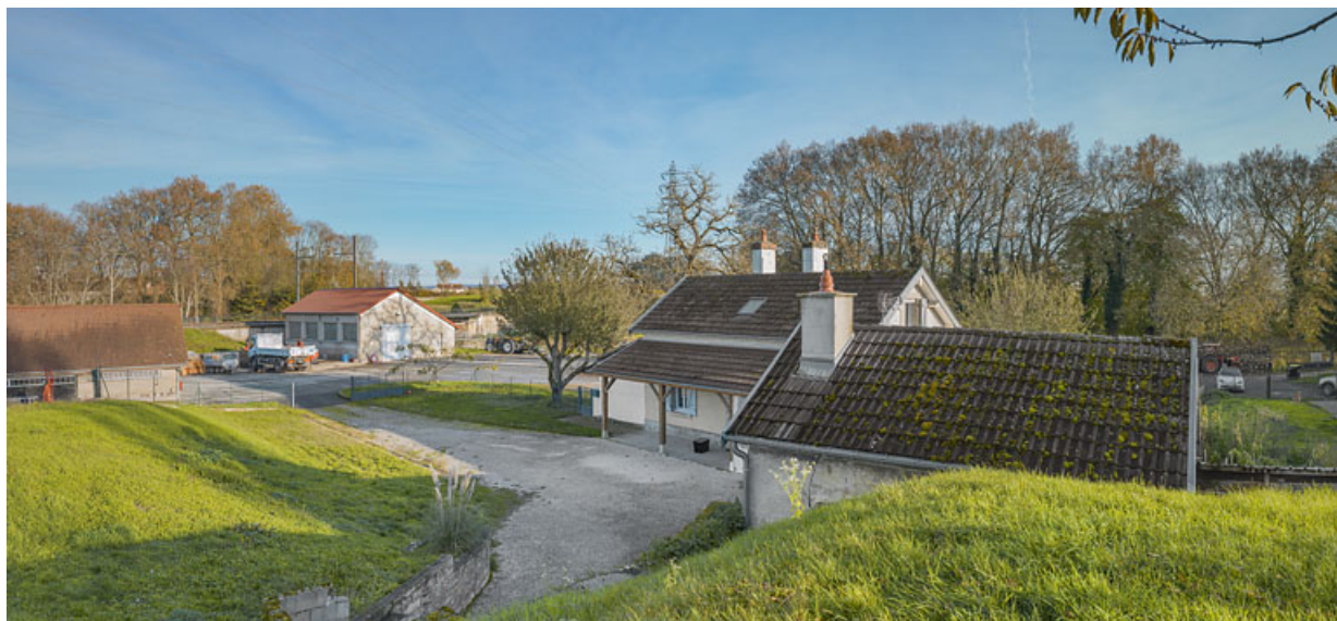
Vue d'ensemble de la maison et des hangars de l'atelier de VNF.
