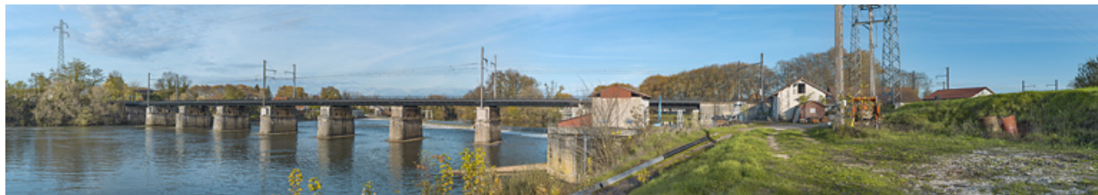
Le pont ferroviaire d'Auxonne (21).
