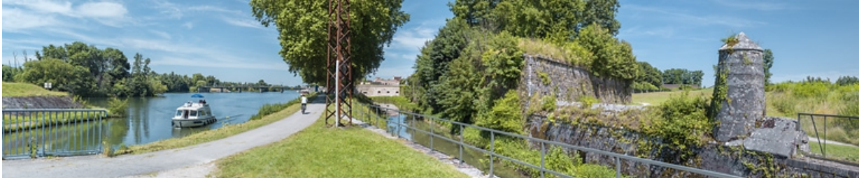
Vue d'ensemble avec de gauche à droite : l'entrée de la dérivation, le pont, les fortifications et le fossé qui longe la dérivation. 21, Auxonne route de Dijon, lieudit : PK 233,2
