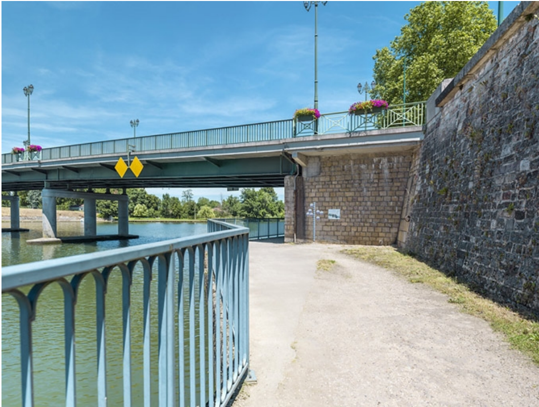
Pile, arche marinière et culée du pont avec repères de crues.
