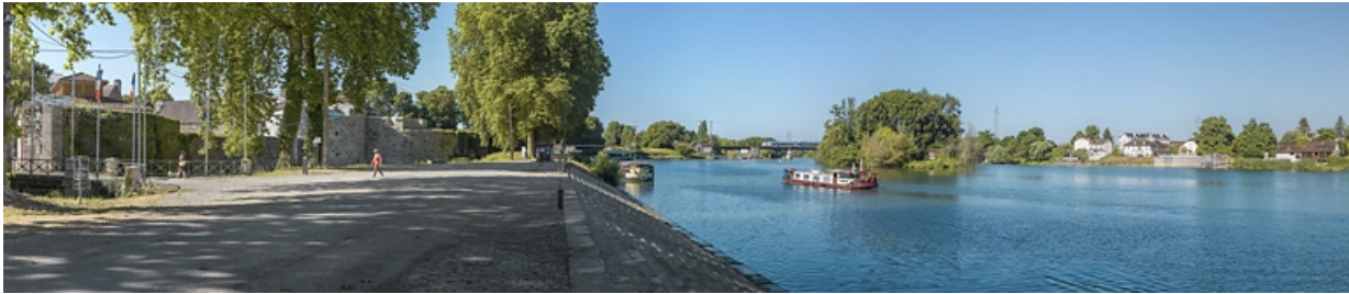
Le château, l'entrée de la dérivation, le pont ferroviaire et la gare d'Auxonne vus depuis les quais. 21, Auxonne quai de Saône
