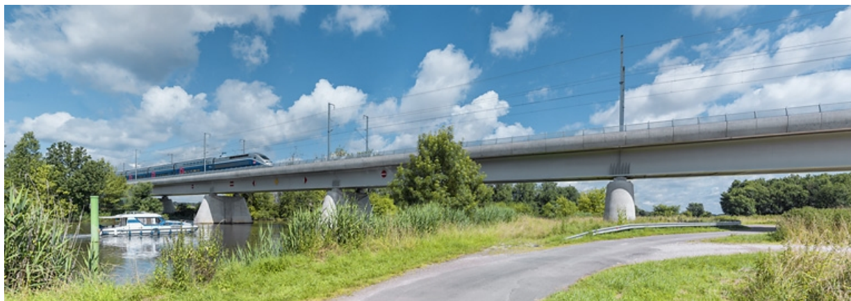
Vue d'ensemble avec TGV franchissant la Saône.
