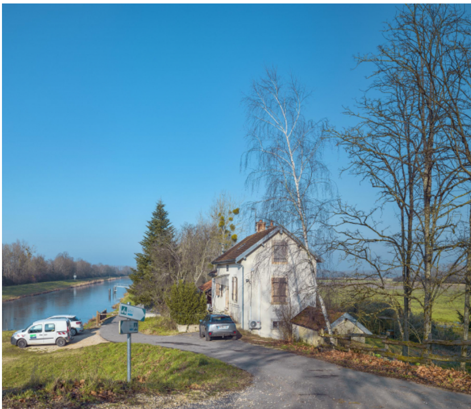
Pignon de la maison éclésièrre de Poncey.
