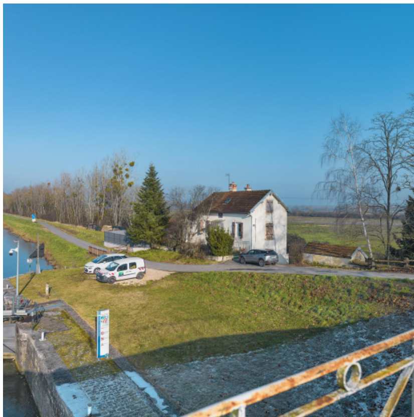
Maison éclusière de Poncey, vue depuis le pont sur écluse.
