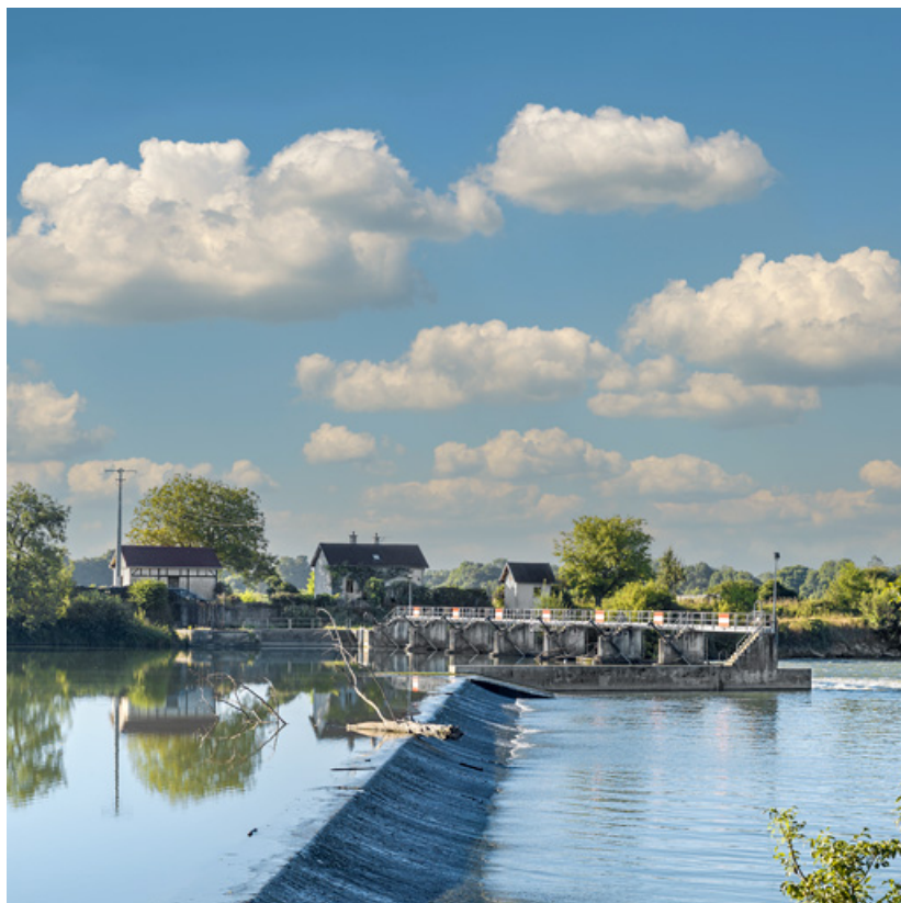
Au centre, la maison du barragiste et à gauche, le magasin à aiguilles.
