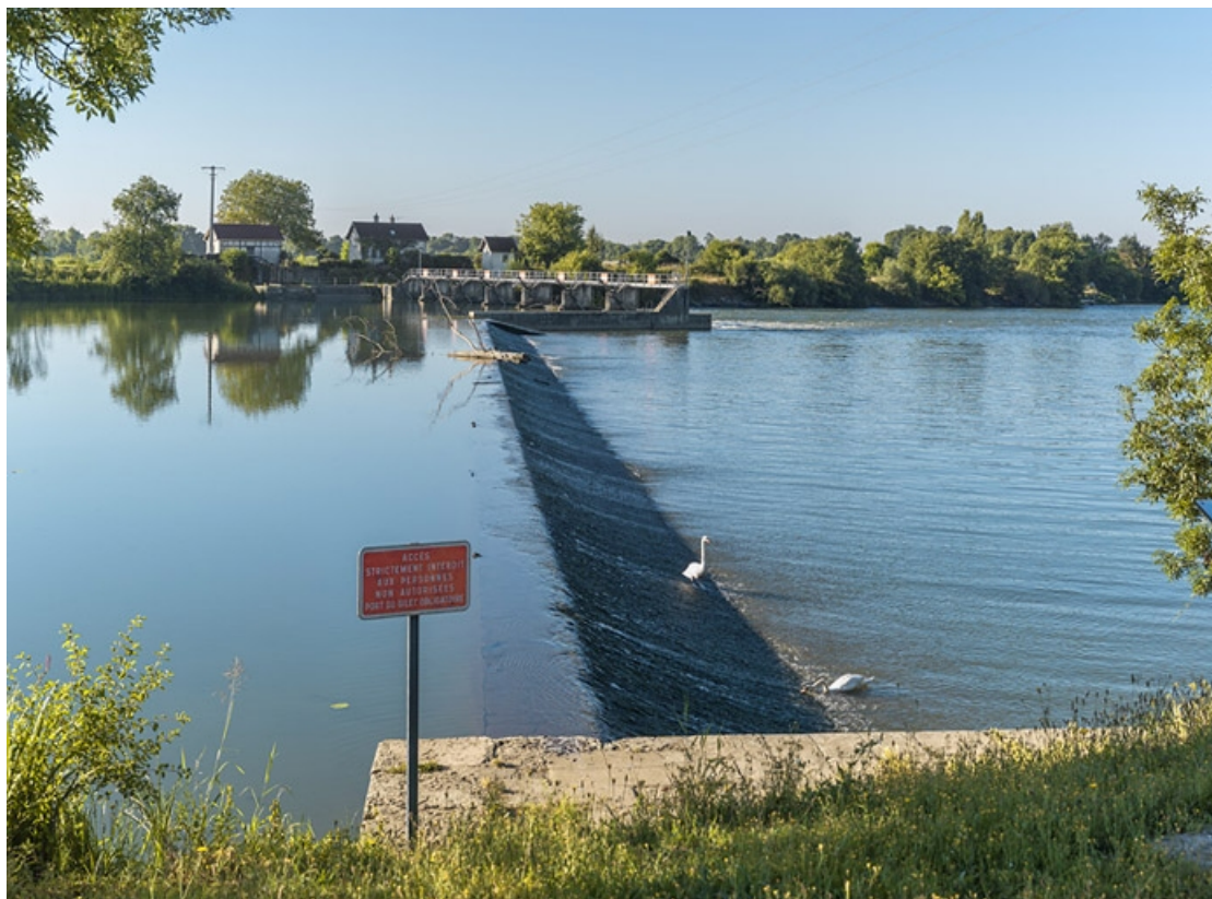
Au centre, la maison. A gauche, le magasin à aiguilles. A droite, l'édicule lié au fonctionnement du barrage actuel.
