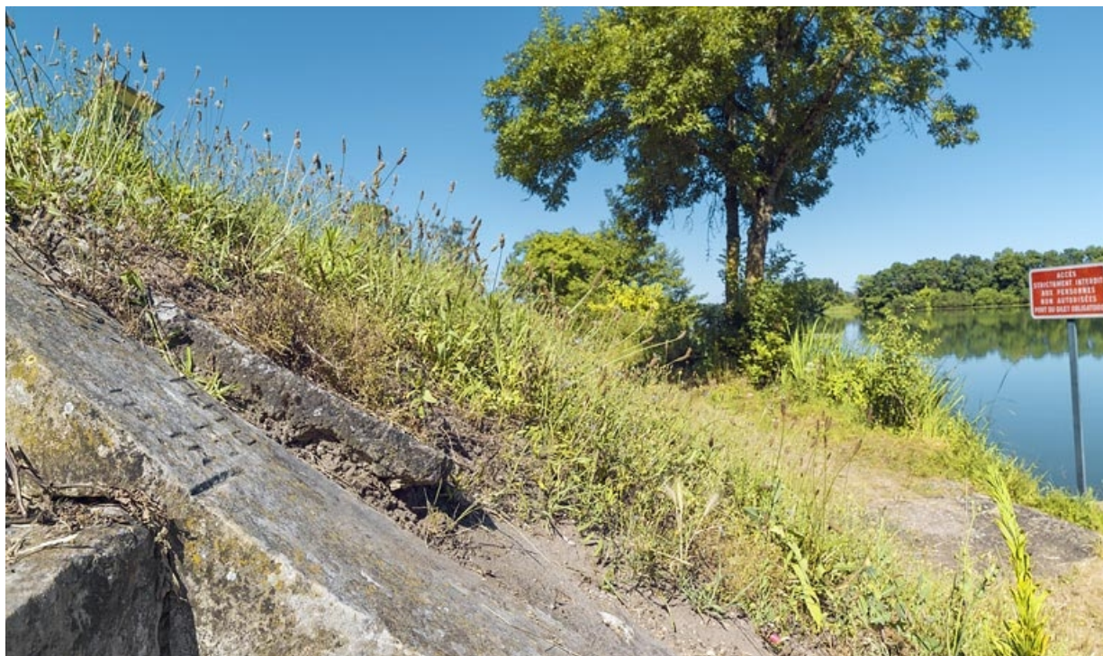
Escaliers du barrage : détail de la date de la crue.
