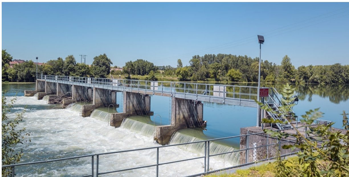
Barrage et ses vérens hydrauliques depuis la rive gauche.
