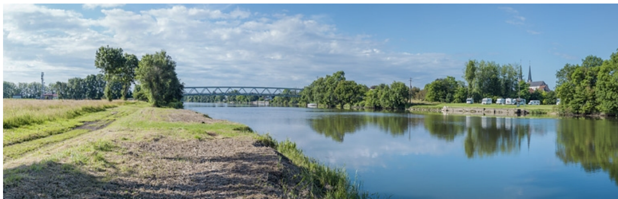
Vue d'ensemble depuis la rive gauche.
