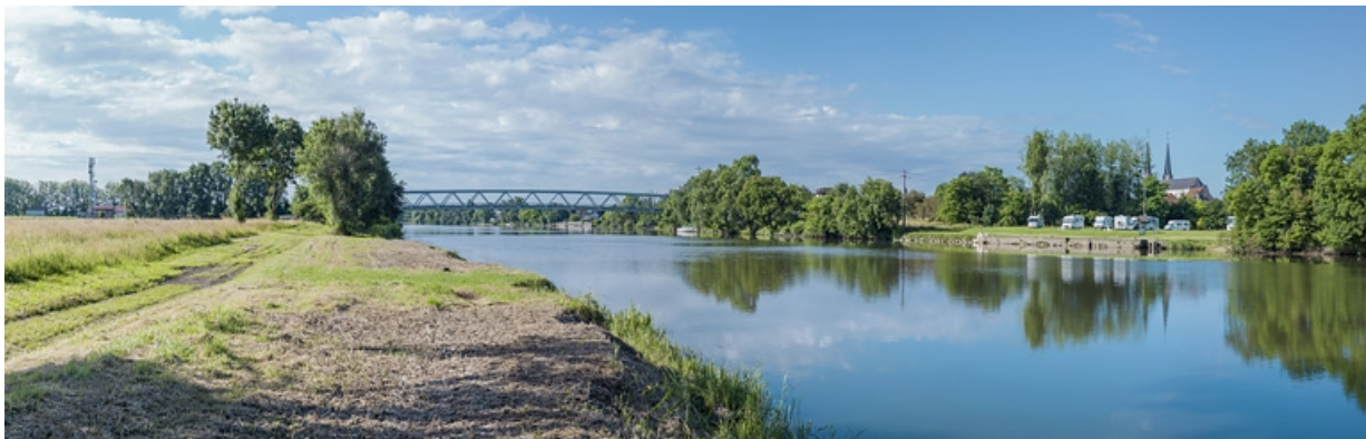
Vue d'ensemble depuis la rive gauche.
