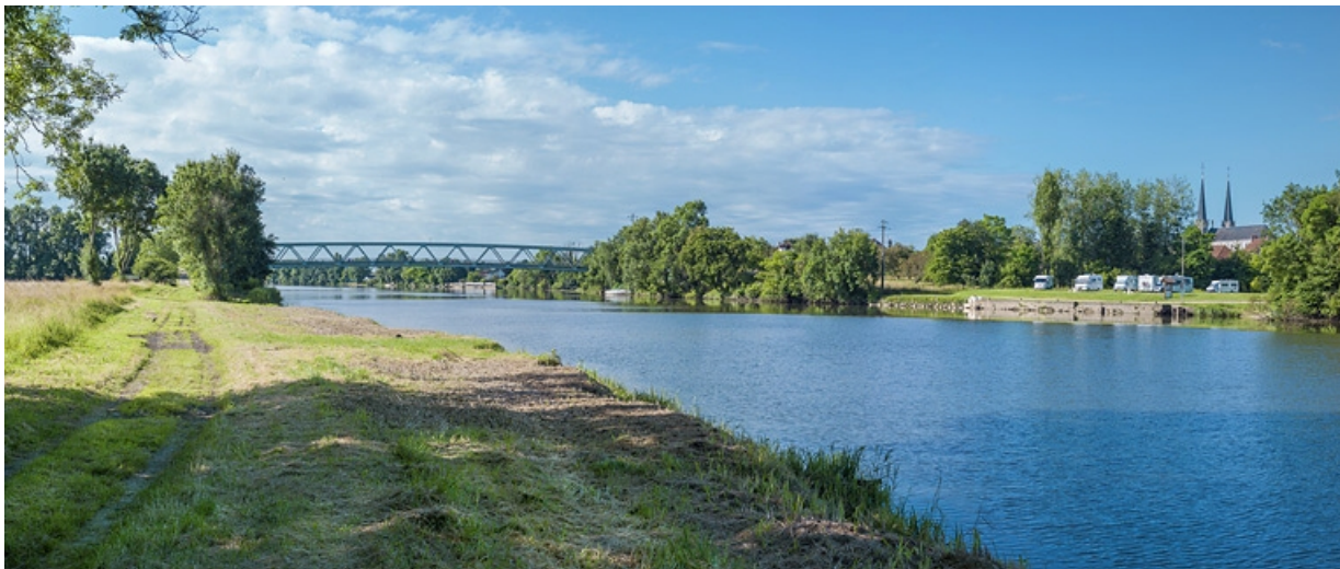
Vue d'ensemble depuis la rive gauche.
