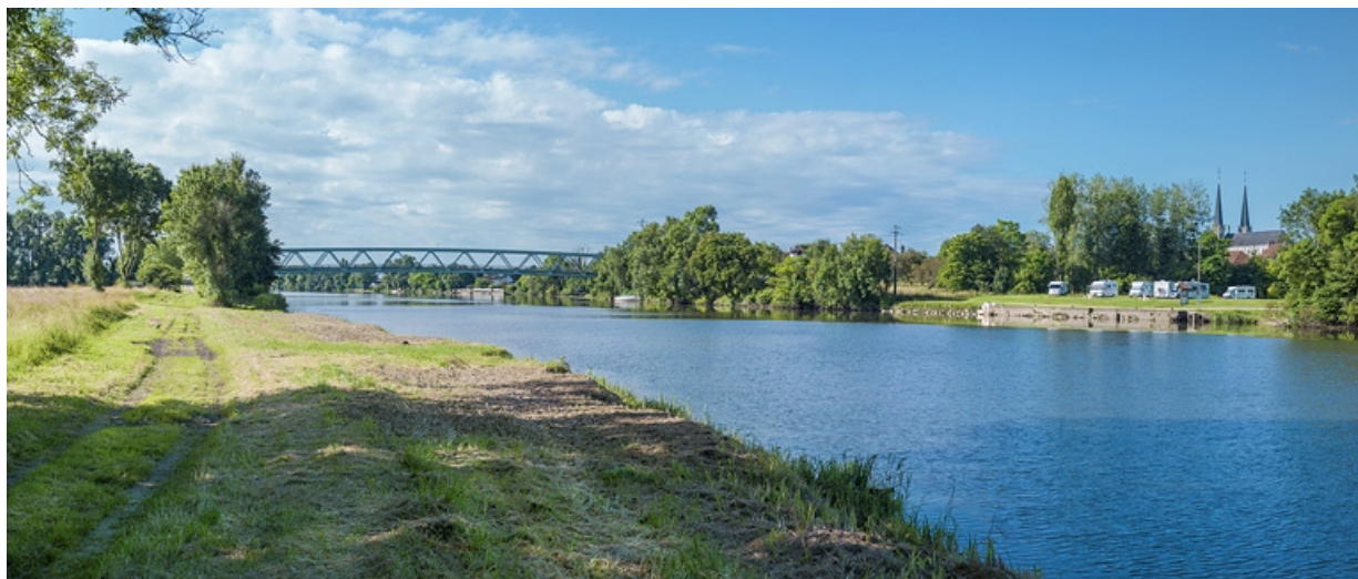
Vue d'ensemble depuis la rive gauche.
