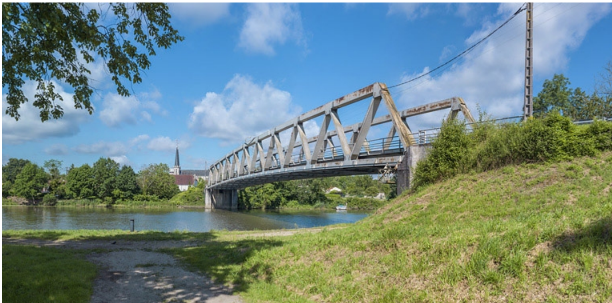
Pont routier de Lamarche-sur-Saône (21).
