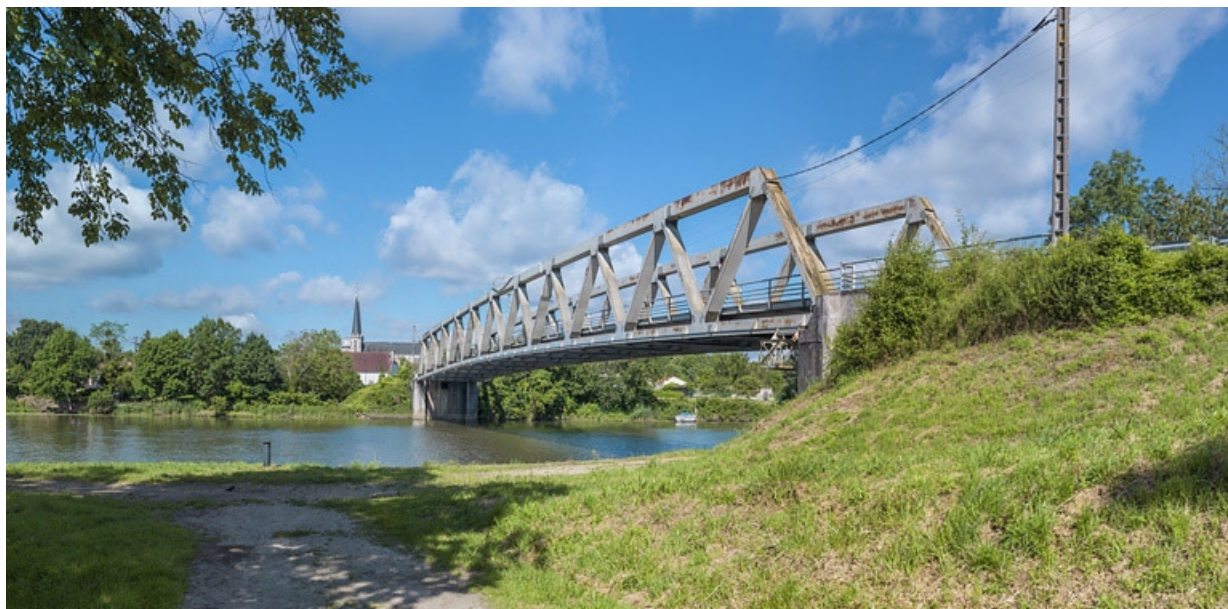
Pont routier de Lamarche-sur-Saône (21).
