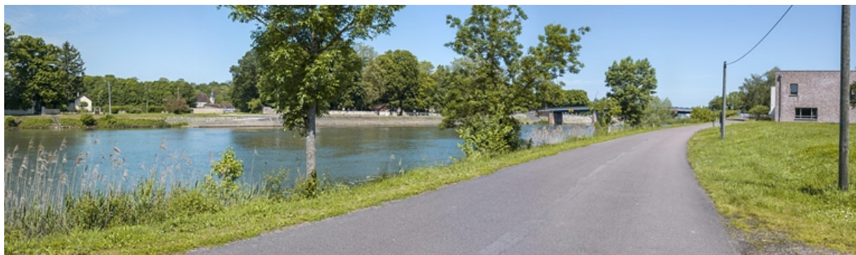
Vue d'ensemble depuis la rive gauche.
