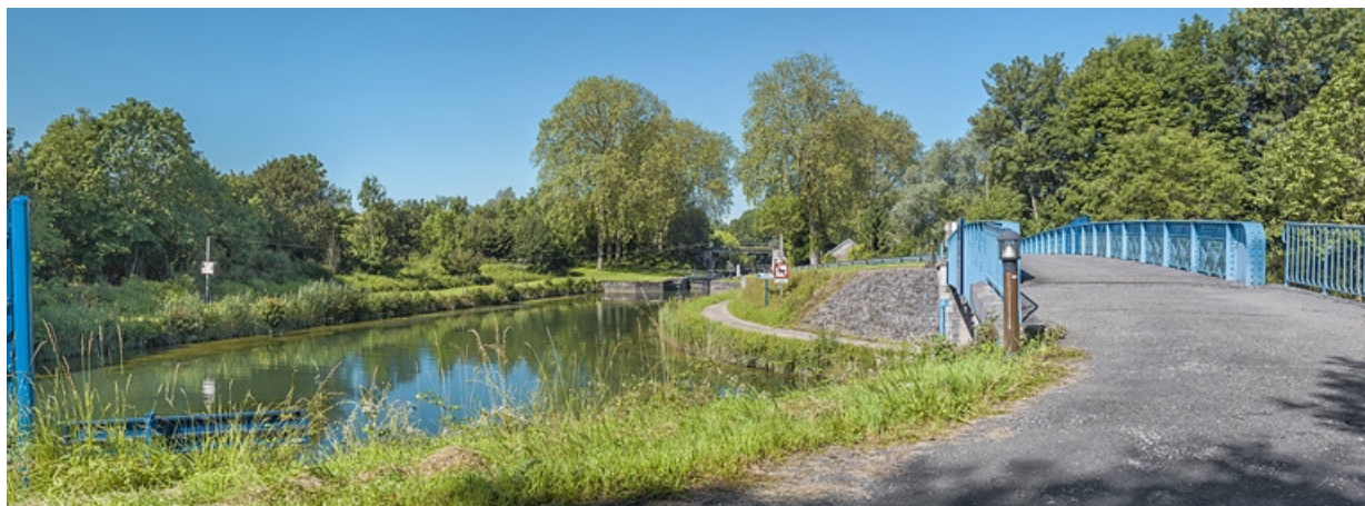
Vue du dessus, avec à gauche le site d'écluse 18.
