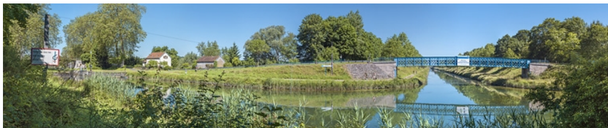
Vue d'ensemble de la passerelle avec l'embouchure du canal dans la dérivation. A gauche, le site d'écluse 18. 21, Maxilly-sur-Saône, lieudit : PK 255
