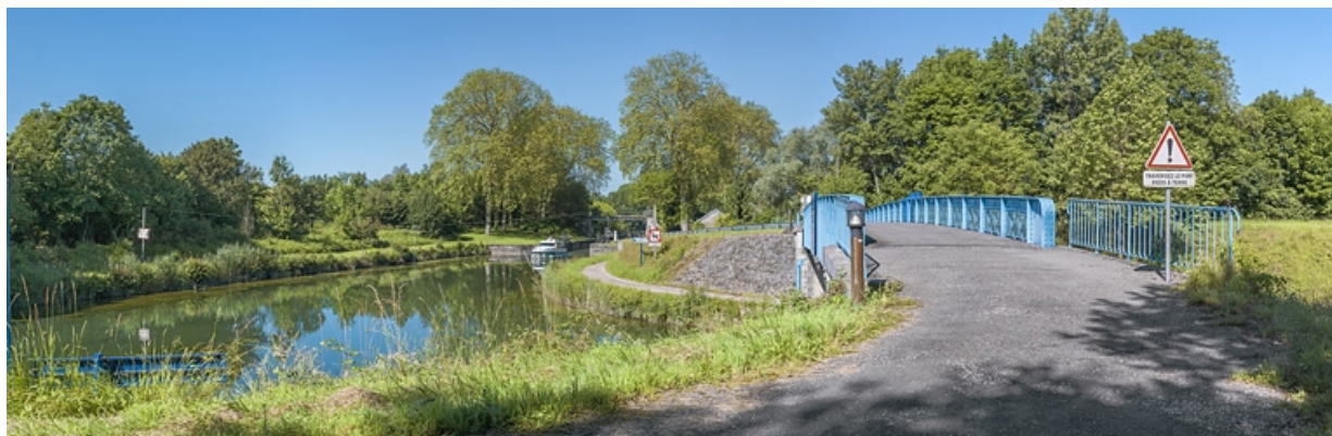
Vue du dessus, avec à gauche le site d'écluse 18.
