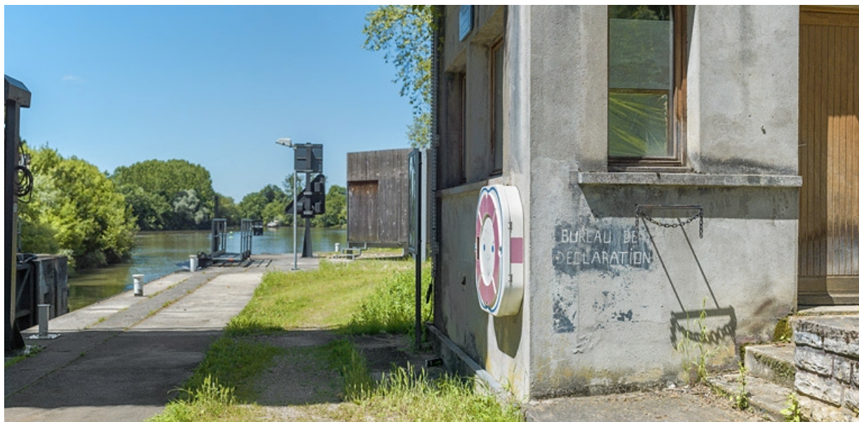
Bureau de la déclaration dans la culée du pont.
