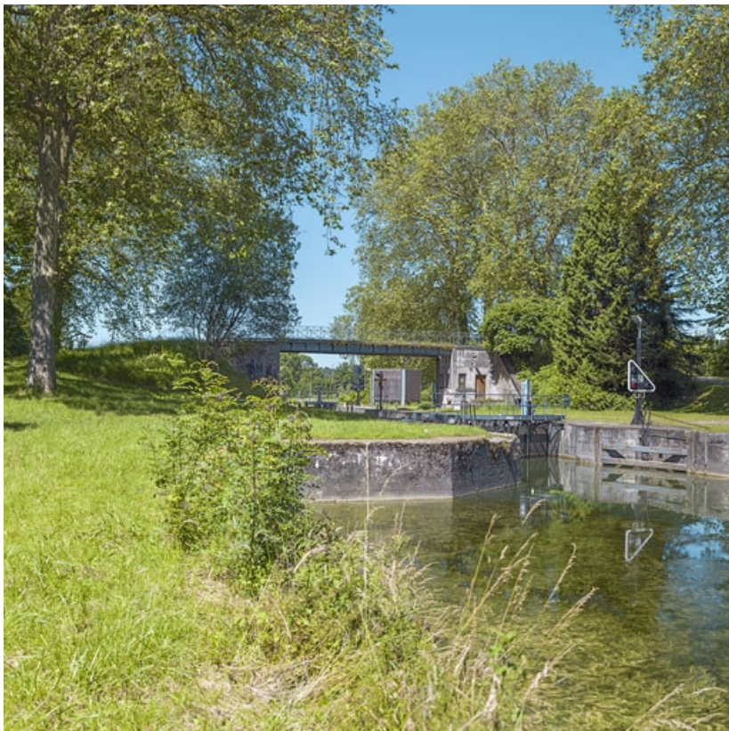
Vue d'ensemble du pont, depuis l'aval.
