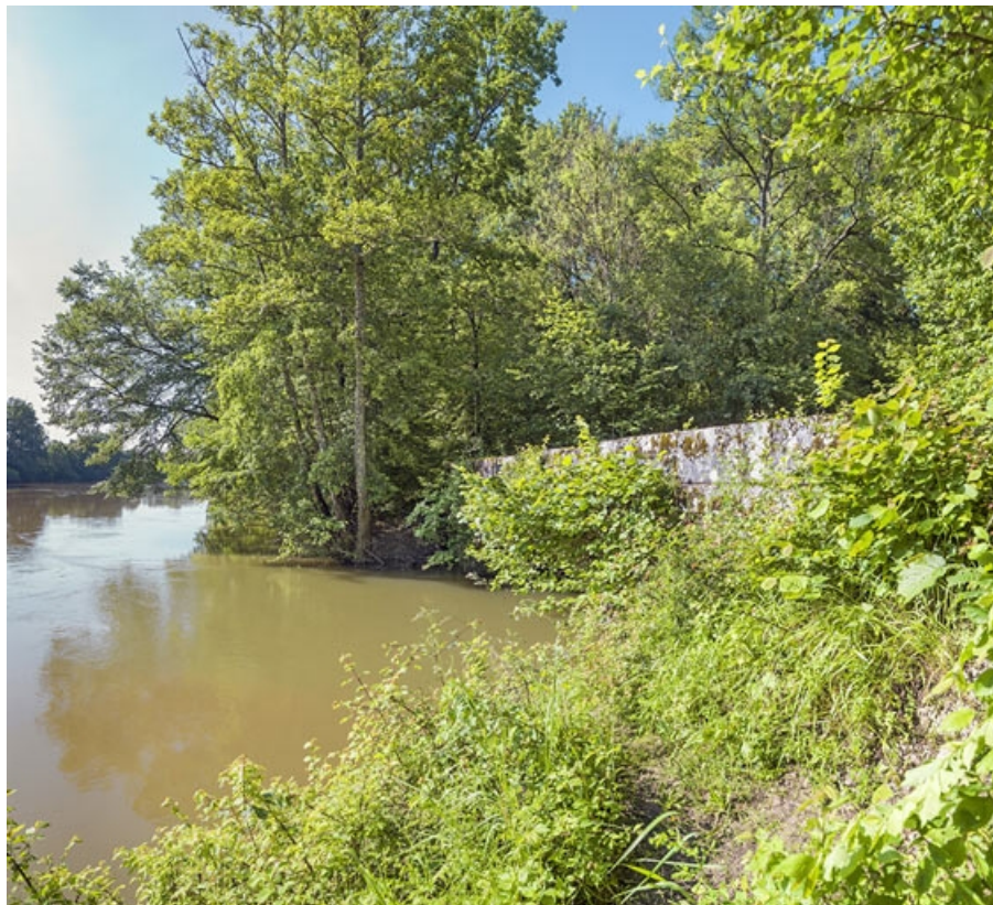
Le pont, vu depuis la Saône.
