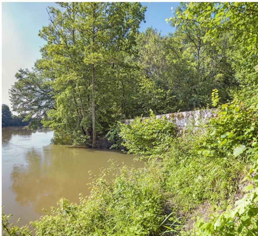
Le pont, vu depuis la Saône.
