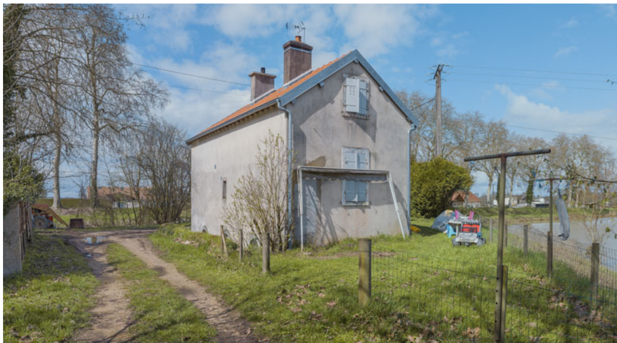
Vue d'ensemble de trois-quarts : pignon et façade arrière.
