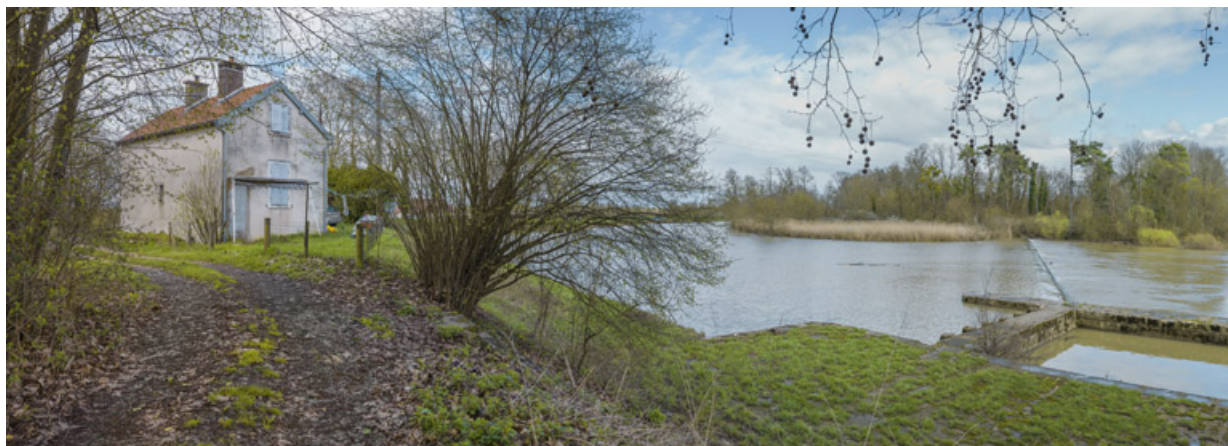
De gauche à droite : la maison du barragiste, le pertuis et le barrage fixe d'Heuilley. 21, Heuilley-sur-Saône
