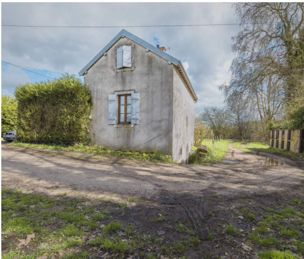
Vue d'ensemble de trois-quarts : pignon et façade arrière. On peut également voir, à droite, le tect à porc. 21, Heuilley-sur-Saône
