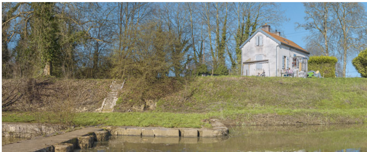
Vue d'ensemble du site. Au premier plan, le pertuis du barrage et au dessus, la maison du barragiste.
