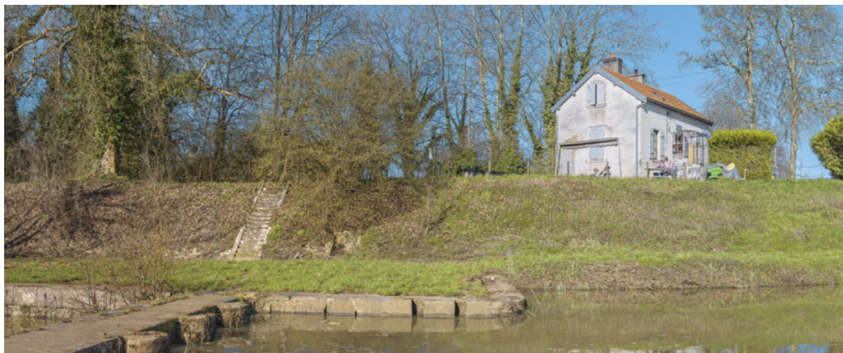
Vue d'ensemble du site. Au premier plan, le pertuis du barrage et au dessus, la maison du barragiste.
