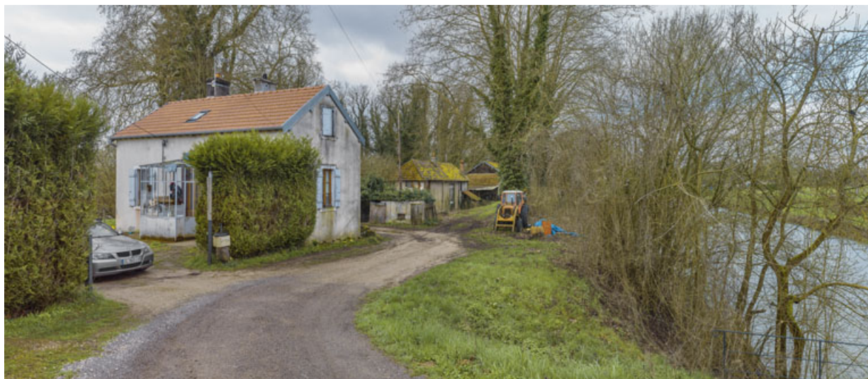
Vue d'ensemble de la maison : façade principale et pignon droit.
