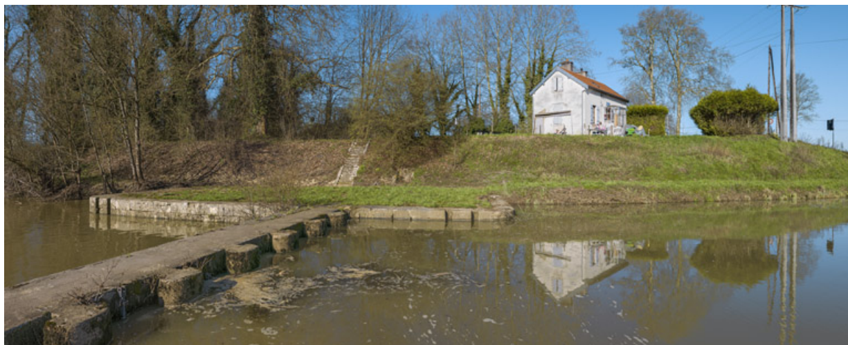
La maison surplombant le barrage fixe, au premier plan.
