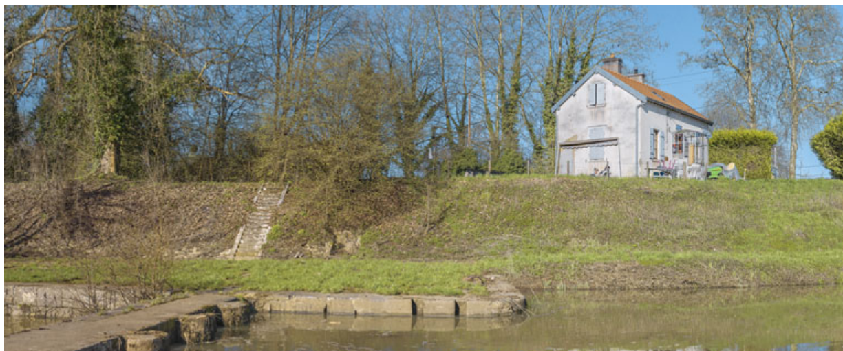
Vue d'ensemble du site. Au premier plan, le pertuis du barrage et au dessus, la maison du barragiste.
