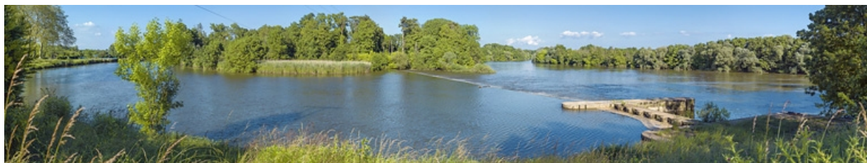
Vue d'ensemble du barrage avec le pertuis à droite et l'île de Fley en face.
