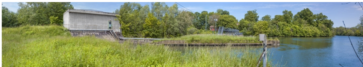
Vue d'ensemble du barrage avec la centrale hydroélectrique à gauche.
