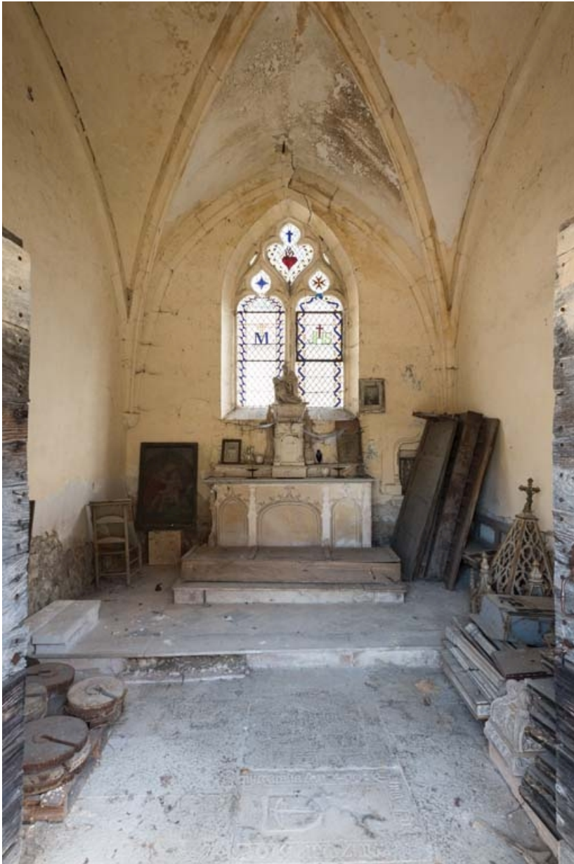
Intérieur : vue d'ensemble depuis l'entrée.
