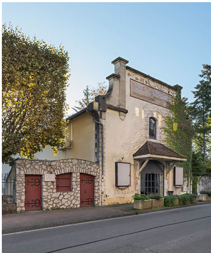
Vue d'ensemble, depuis le nord. A gauche, l'entrée du Caveau Nuiton. 21, Nuits-Saint-Georges, 5 rue Thurot
