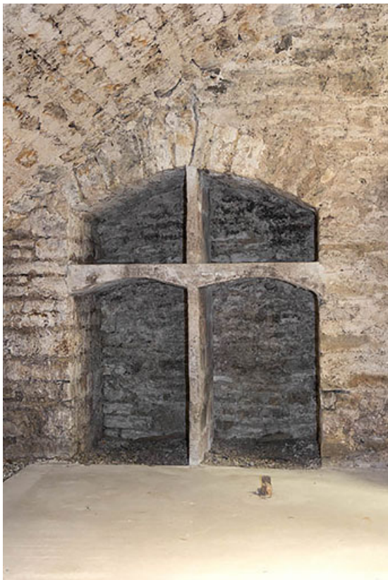
Cave : placard ménagé dans le mur.
