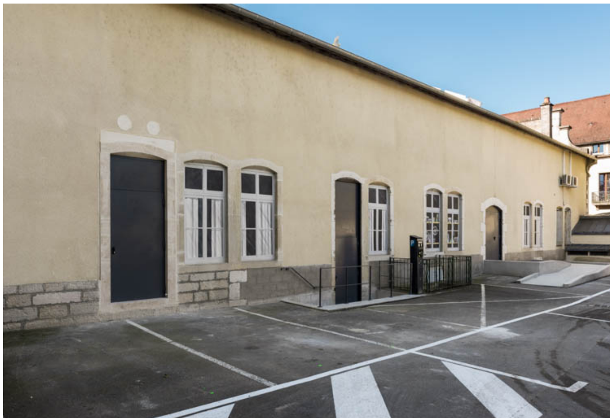
Façade latérale gauche, de trois quarts.
