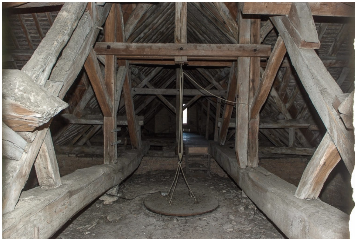
Combles, vue prise au-dessus de la croisée.
