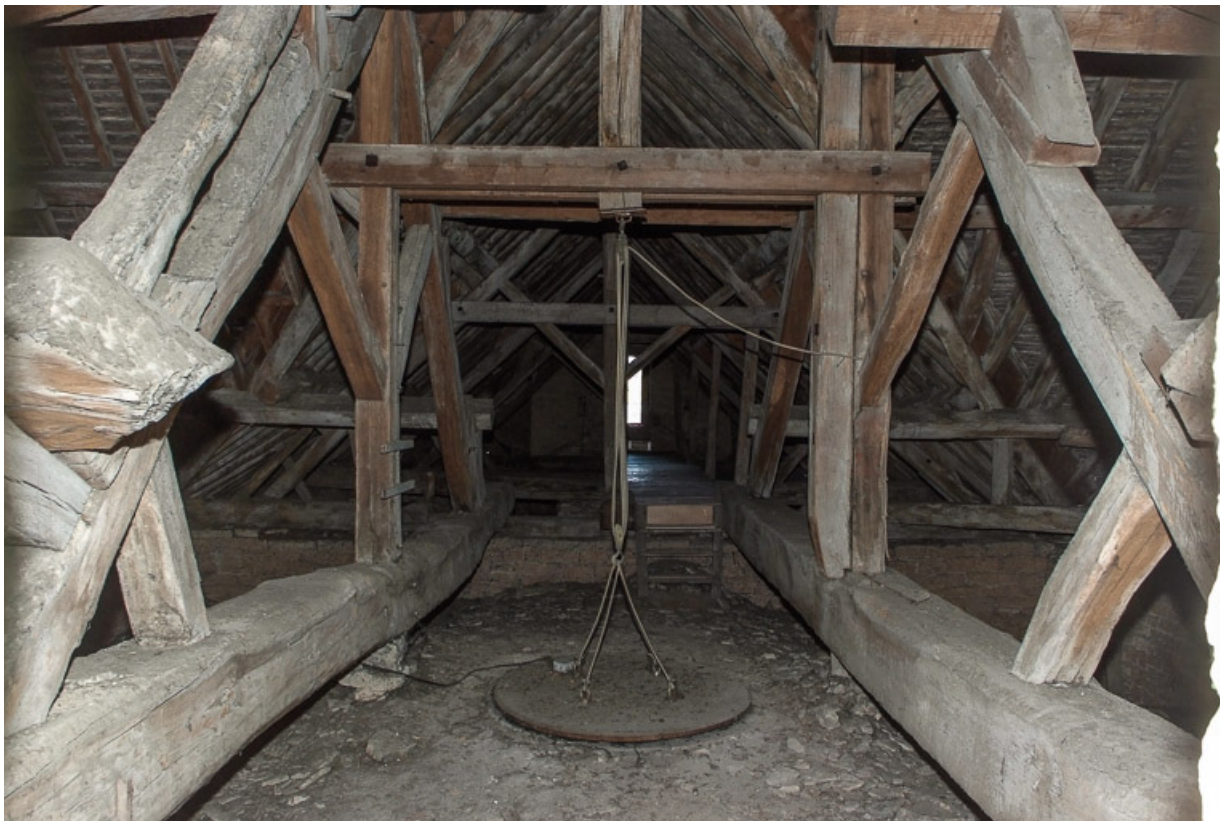
Combles, vue prise au-dessus de la croisée.
