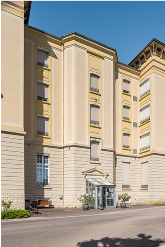
Façade nord-est avec l'entrée de l'escalier.
