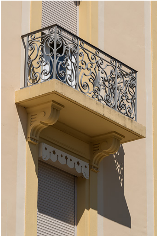
Balcon à l'extrémité est de l'aile nord.
