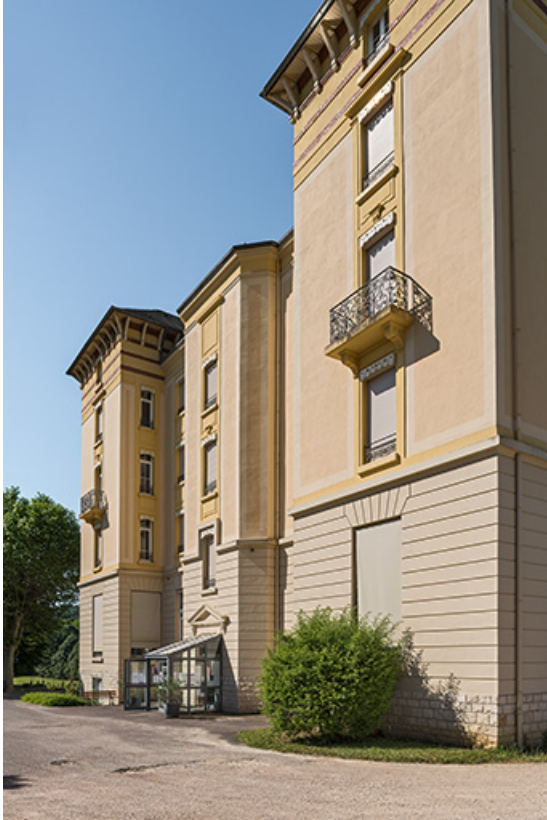
Façade nord-est avec l'entrée de l'escalier.
