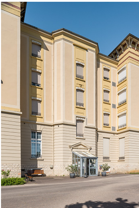
Façade nord-est avec l'entrée de l'escalier.
