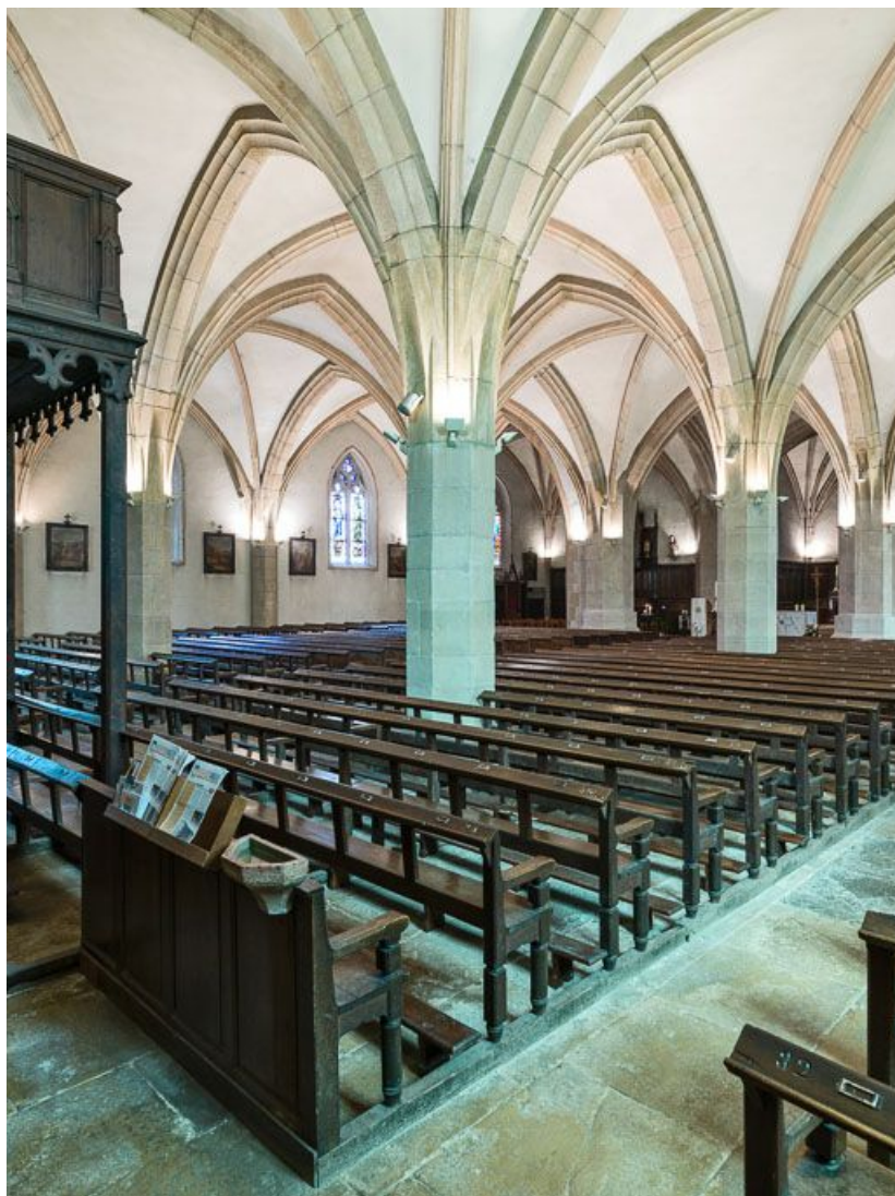
Vue d'ensemble depuis le bas côté droit.
