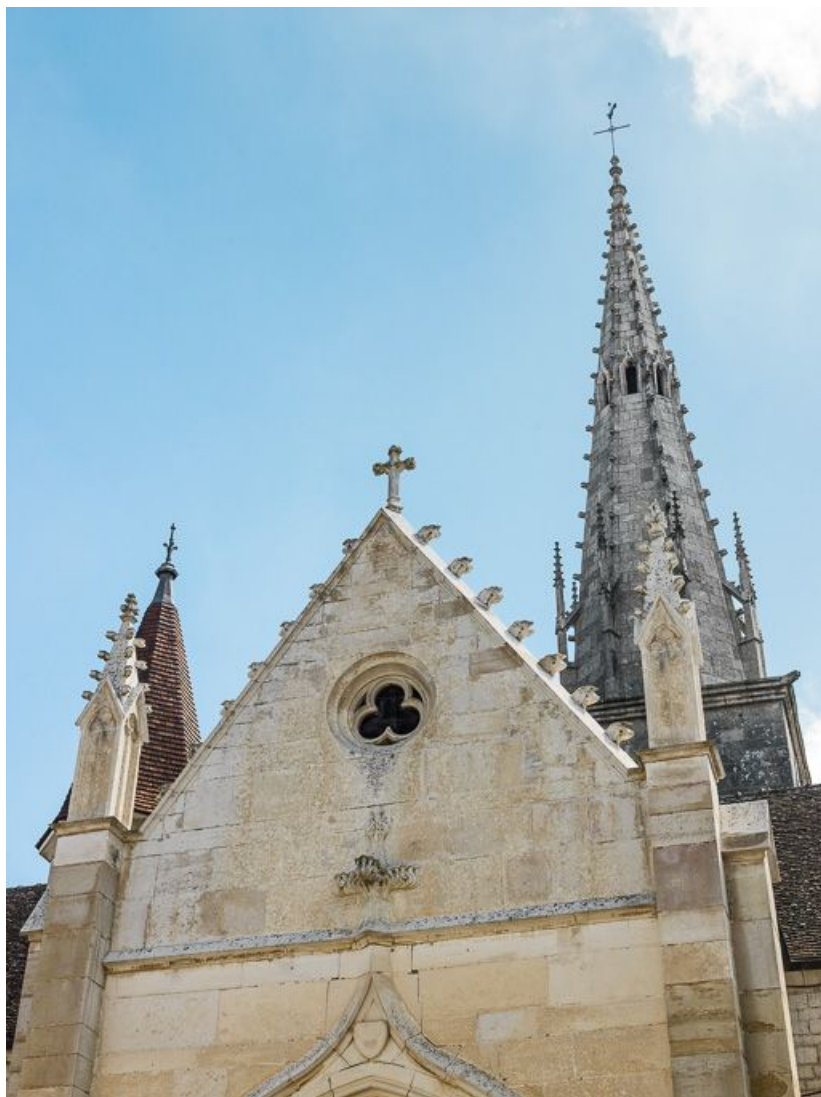
Façade ouest et flèche du clocher.
