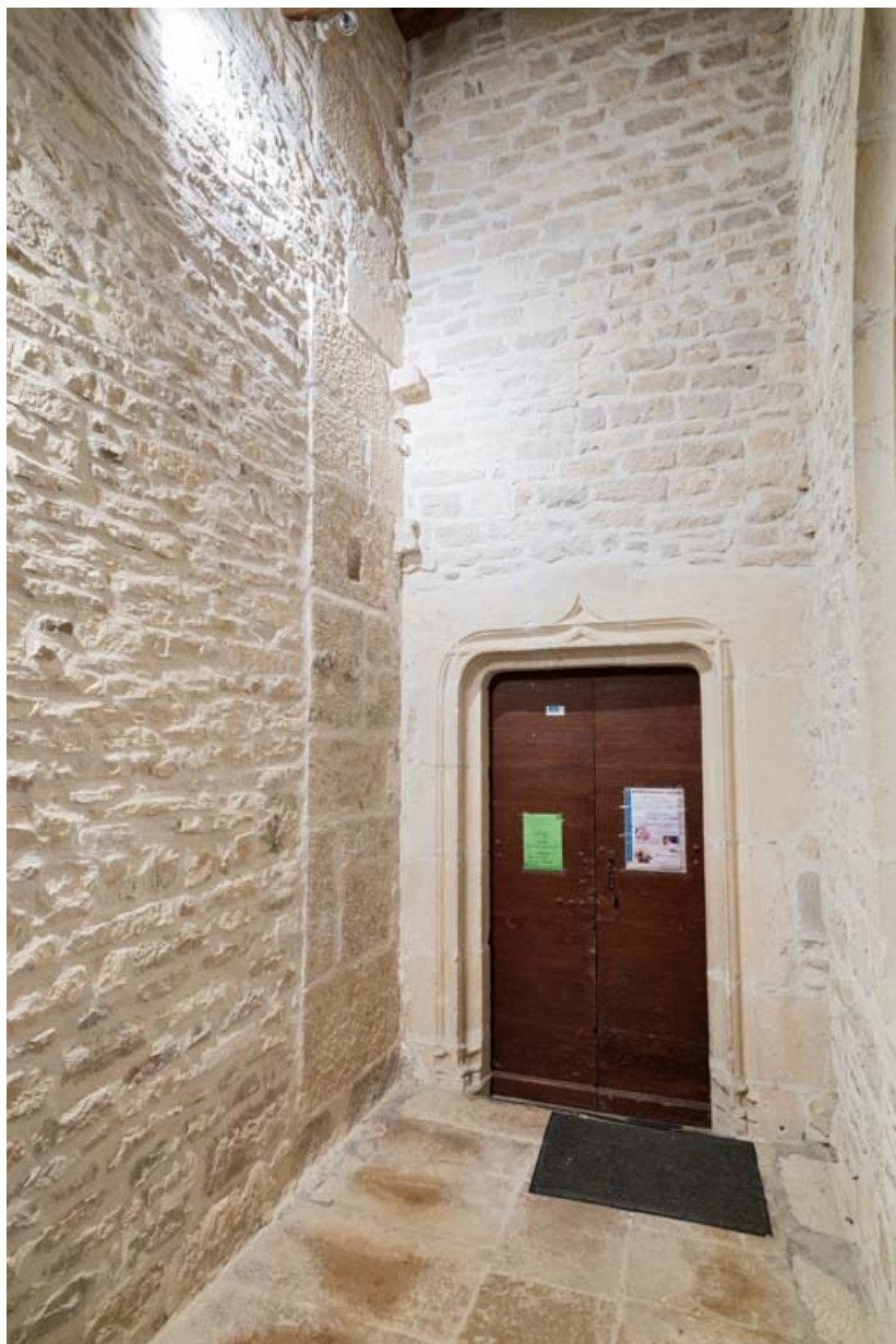
Porte d'entrée donnant dans la nef.
