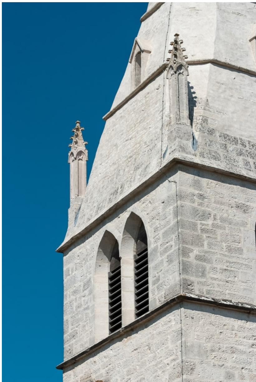
Clocher, détail des baies et des pinacles.
