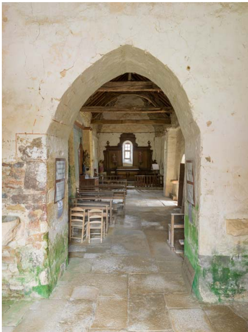
La nef, vue depuis le clocher-porche.
