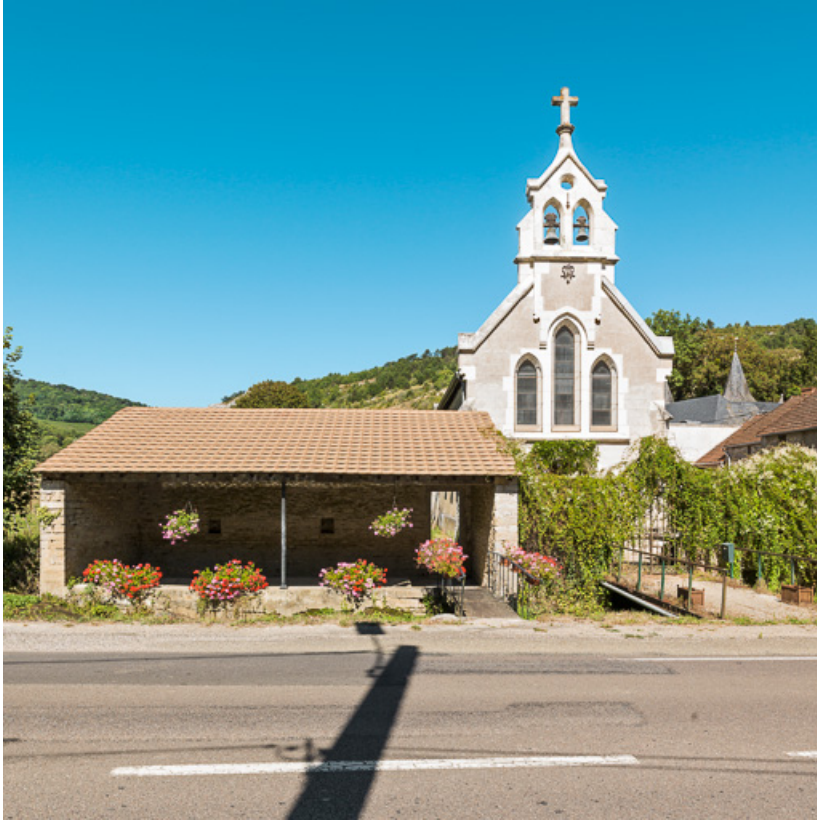
Façade principale de la chapelle et lavoir au premier plan.
