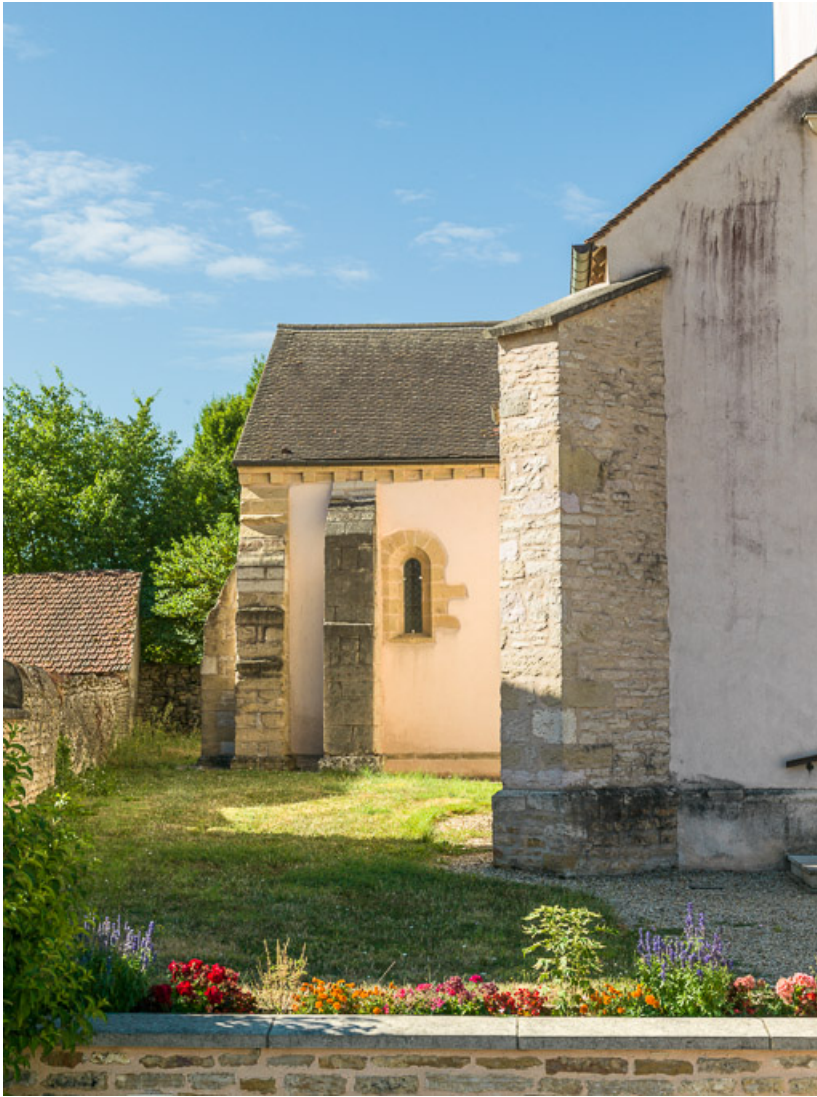
Vue d'un contrefort du massif occidental et d'un bras du transept. 21, Chorey-les-Beaune rue de l'église
