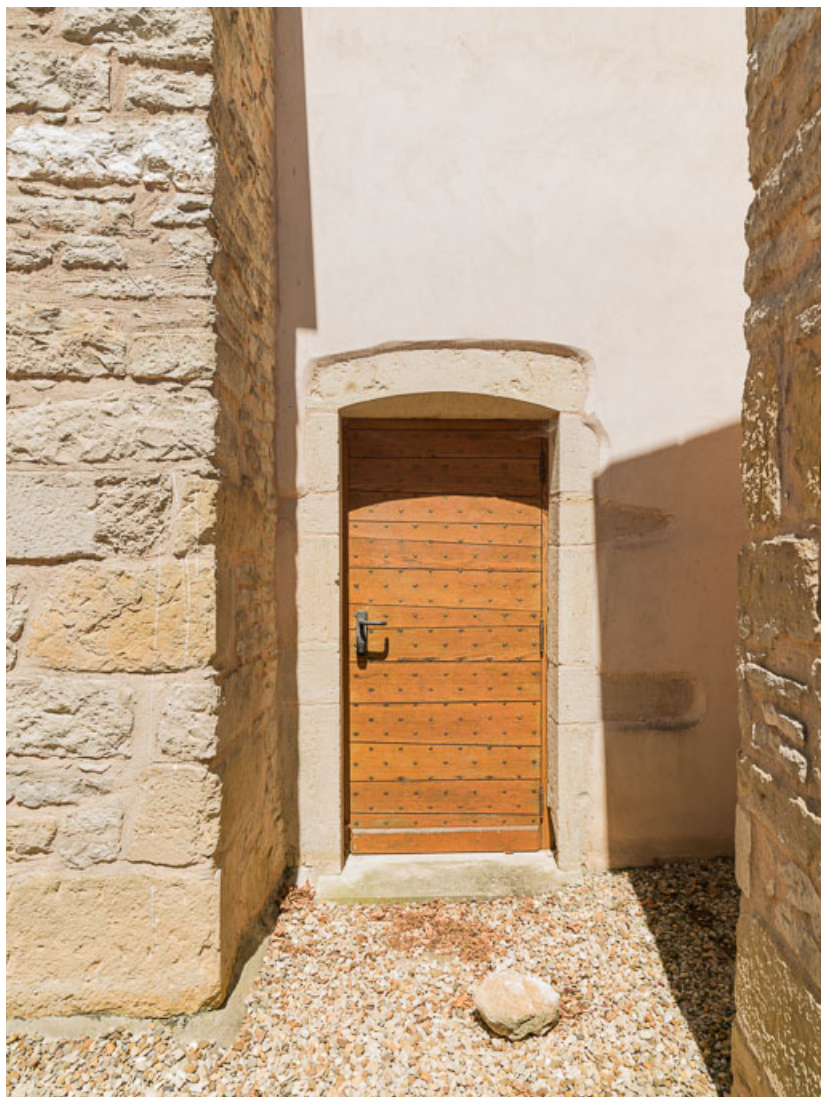
Vue de la porte donnant sur le transept.
