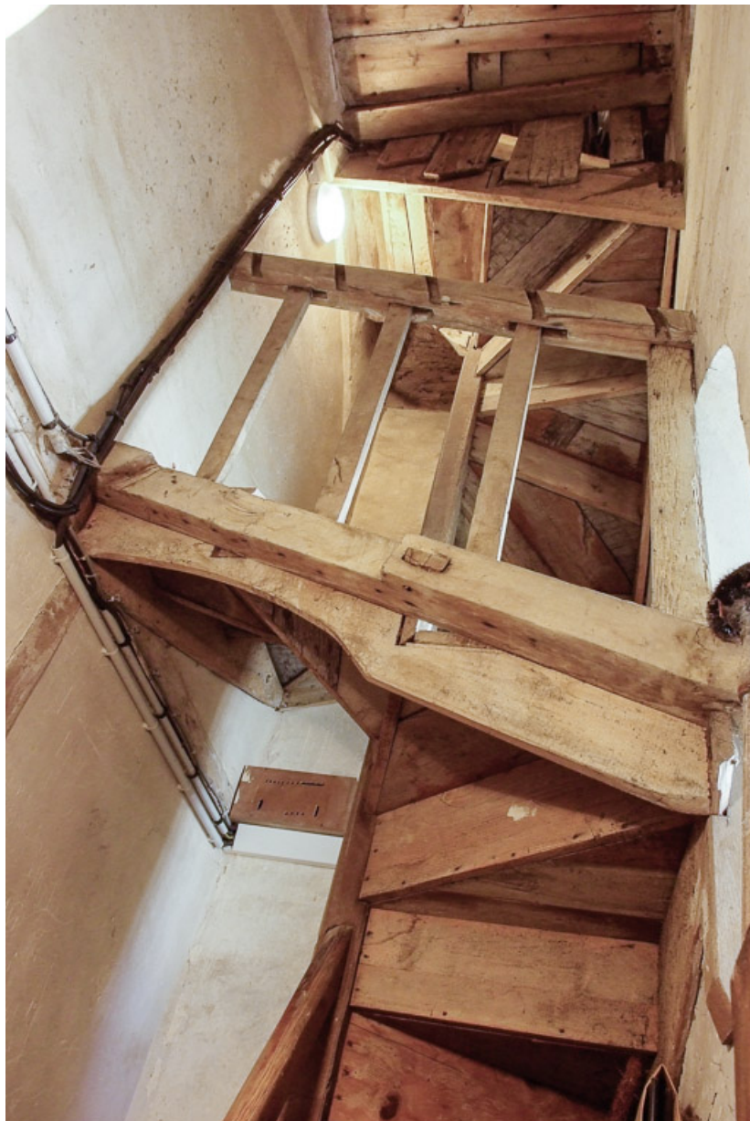
Cage d'escalier menant aux combles.
