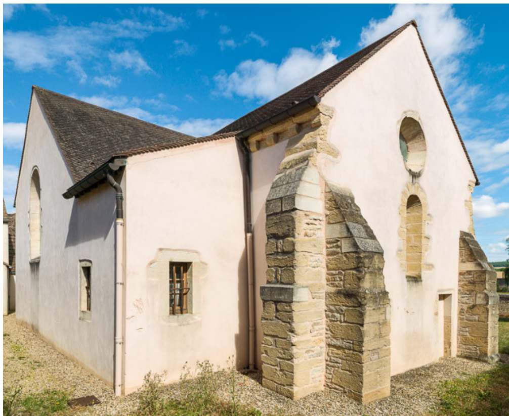
Vue du chevet et du bras du transept.
