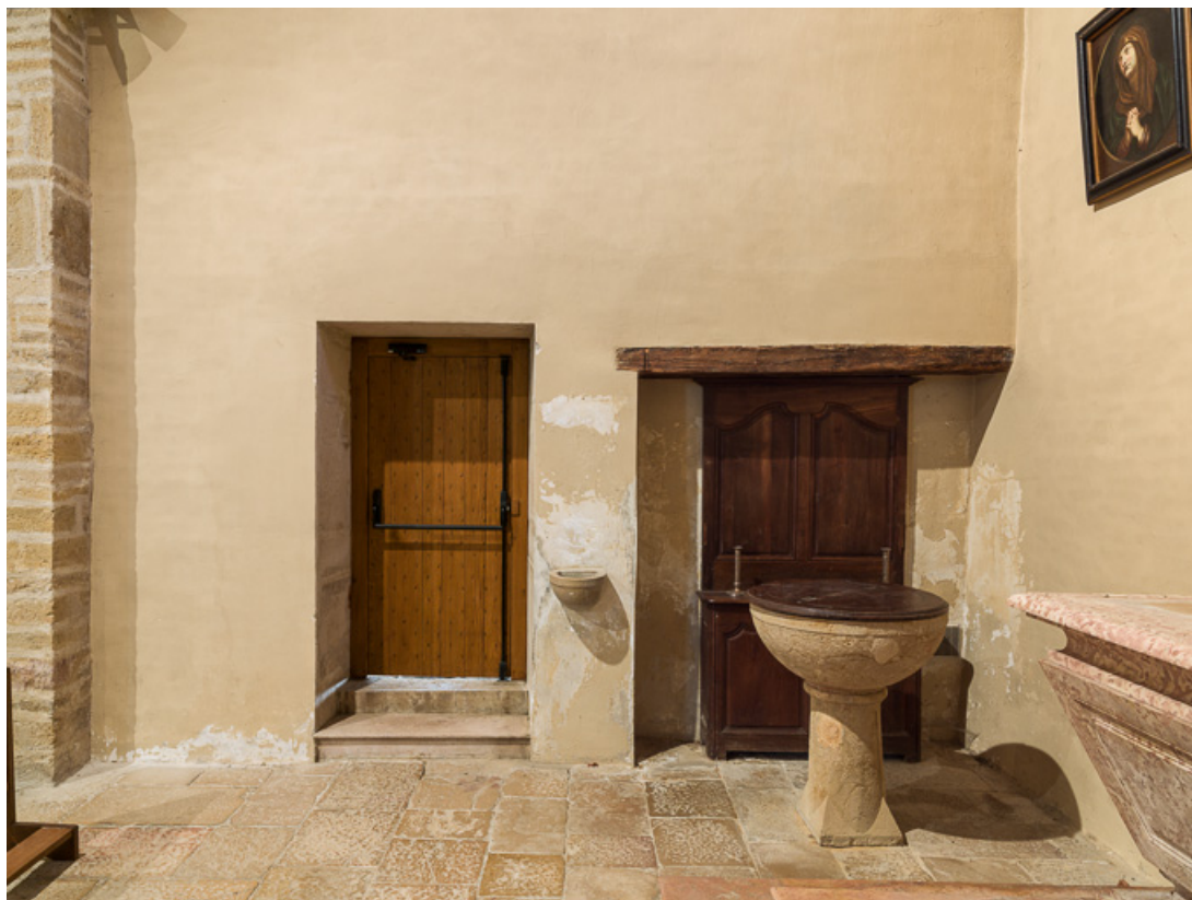
Vue du mur est du bras sud.
