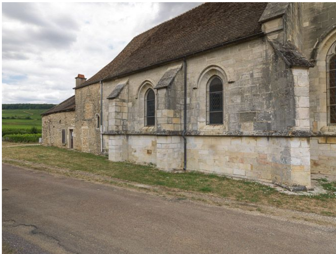
Vue du pignon sud de la chapelle.
