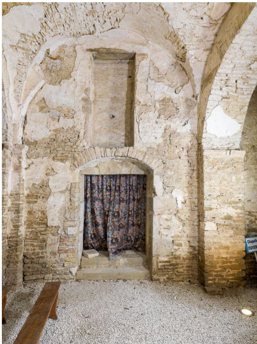
Ancienne chapelle : vue de la porte menant à la ferme (mur est).
