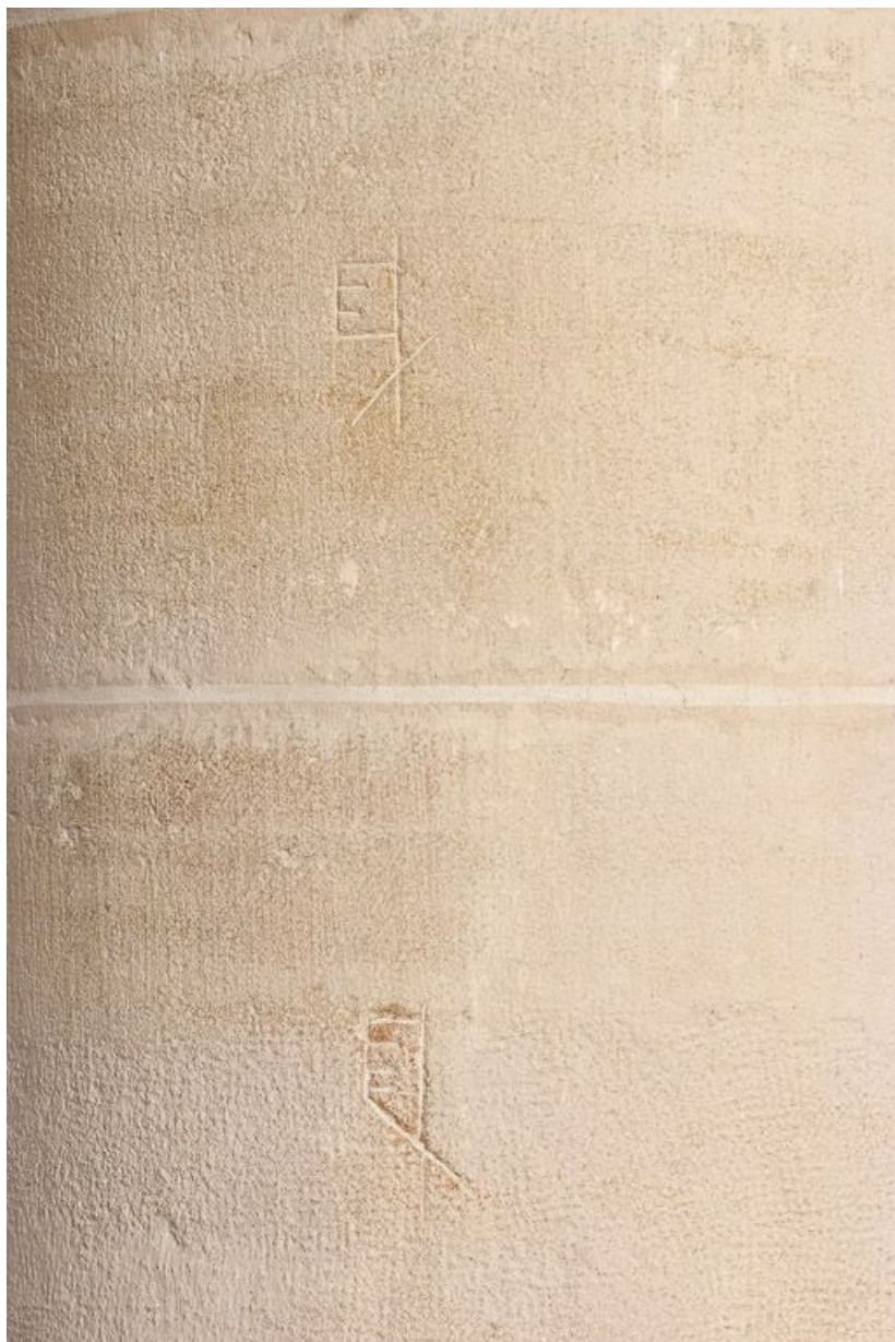
Marques de tâcheron ou d'assemblage sur un pilier de la nef.
