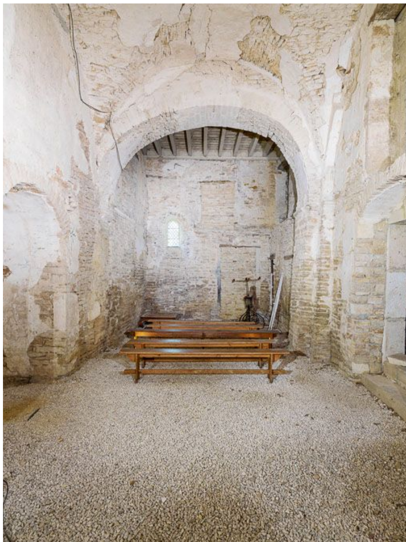
Ancienne chapelle : vue vers le Sud.
