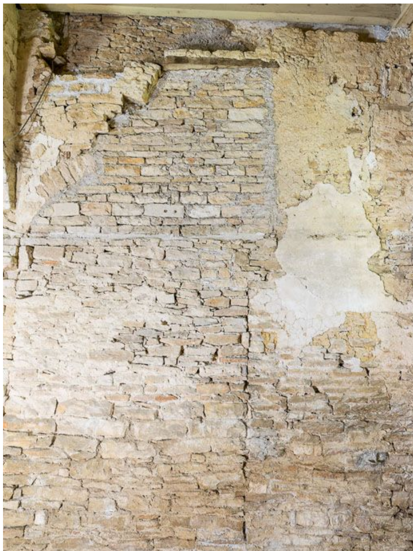
Ancienne chapelle : vue du mur à l'angle sud- ouest.
