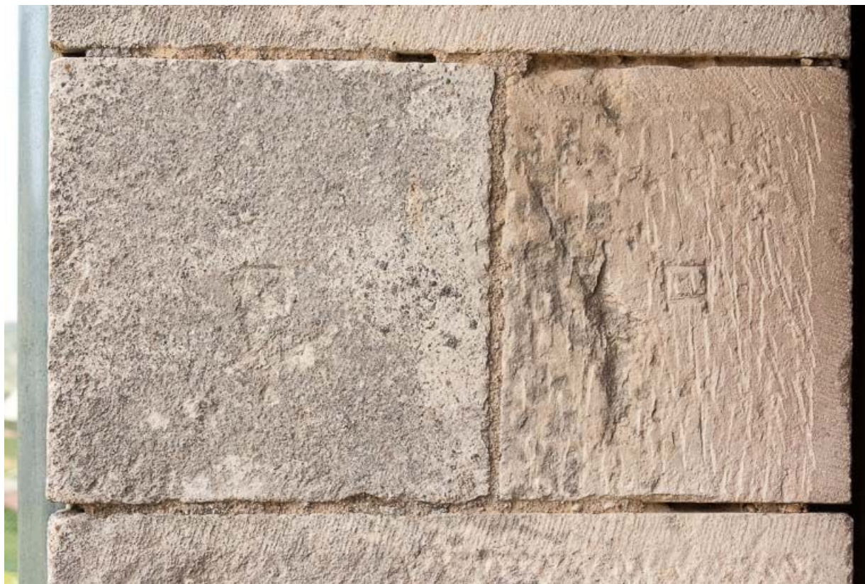
Marque de tâcheron sur la porte charretière à l'ouest de l'édifice.
