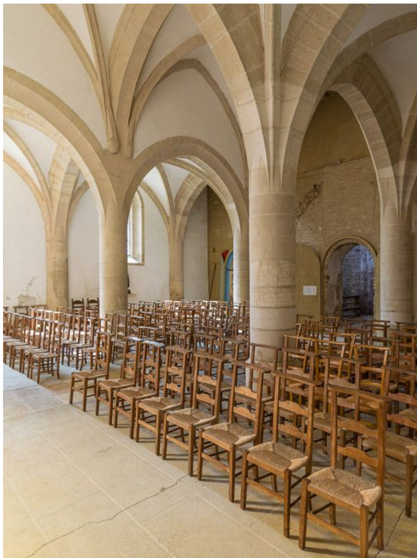
Vue d'ensemble de la nef, vers le sud-ouest.
