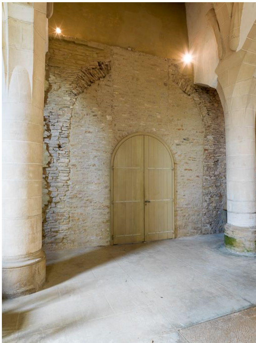
Vue du mur du fond de la nef (ouest). 21, Ladoix-Serrigny, 1 rue de la Chapelle
