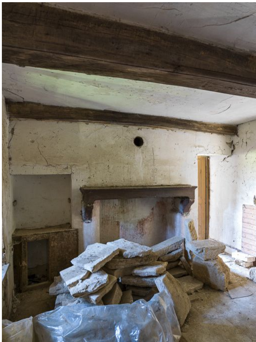
Vue d'un ancien logement (rez-de-chaussée). 21, Ladoix-Serrigny, 1 rue de la Chapelle
