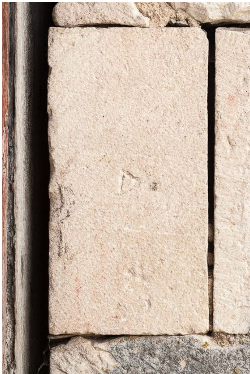
Marque de tâcheron sur la porte charretière à l'ouest de l'édifice.
