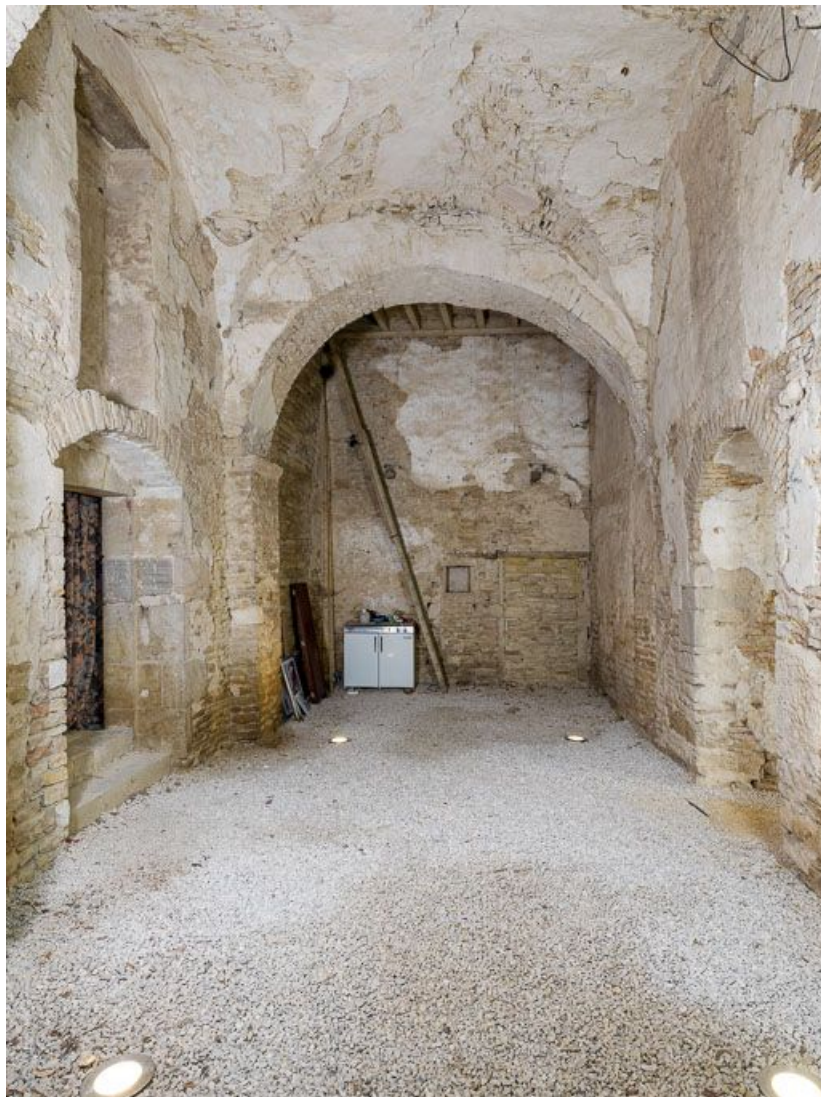
Ancienne chapelle : vue vers le Nord. 21, Ladoix-Serrigny, 1 rue de la Chapelle
