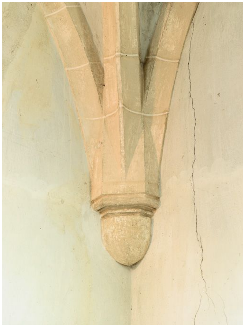
Vue d'un culot et du départ des ogives de la voûte de la sacristie.
