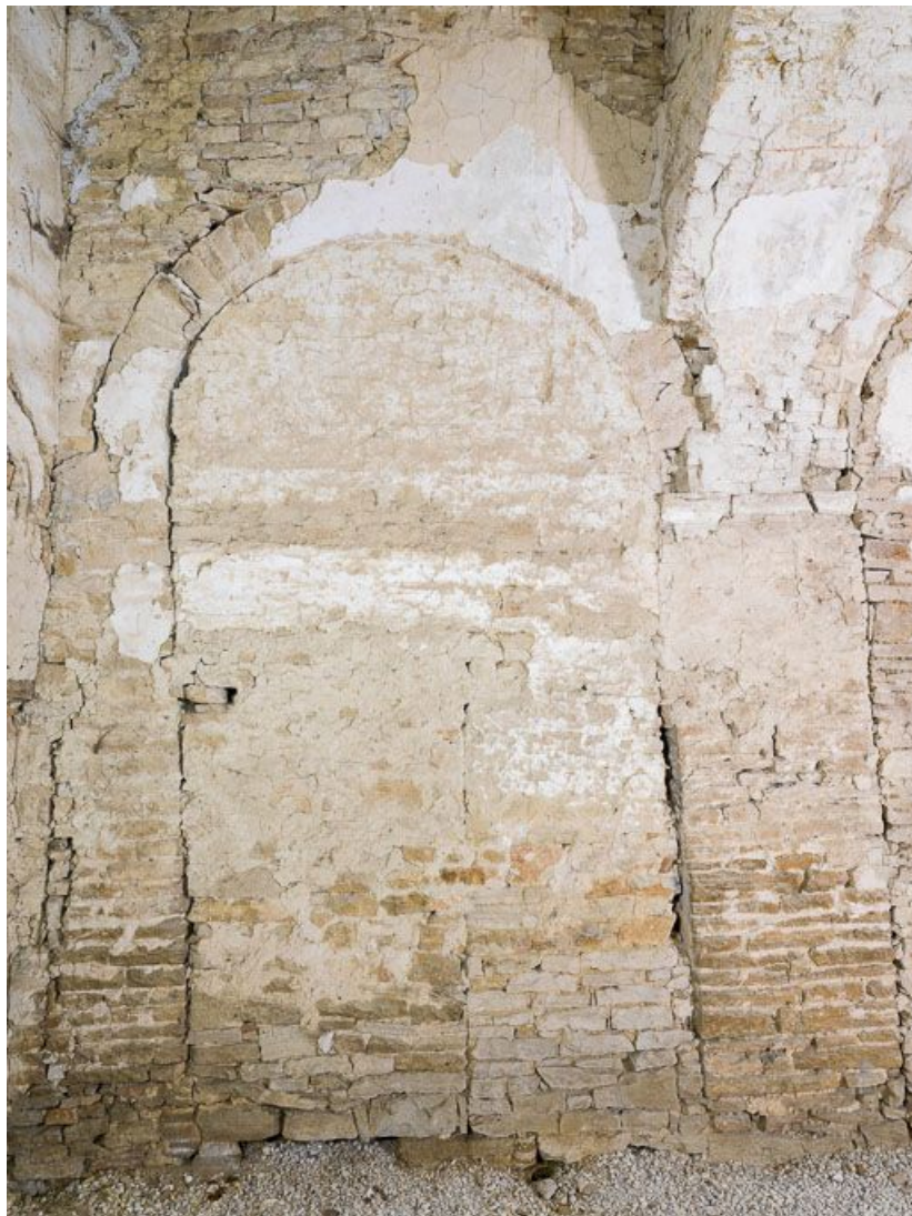
Ancienne chapelle : vue du mur est.
