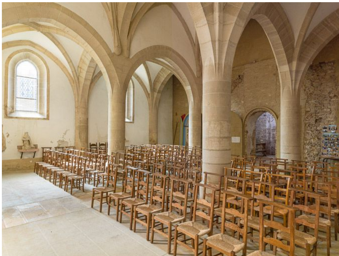
Vue d'ensemble de la nef, vers le sud-ouest.
