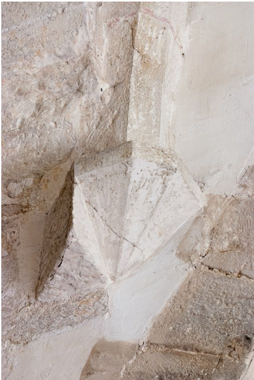
Détail d'un culot de la voûte de la travée sous clocher.
