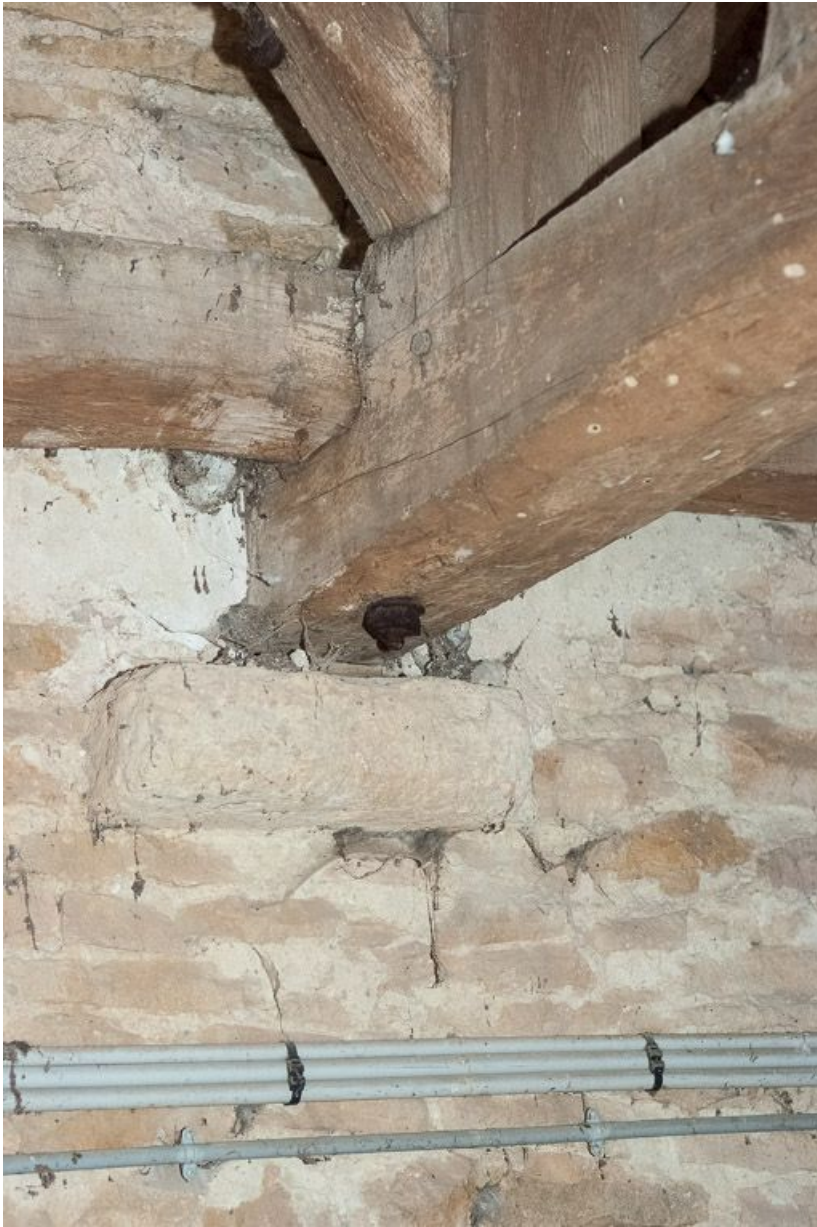
Détail d'un support en pierre du beffroi.
