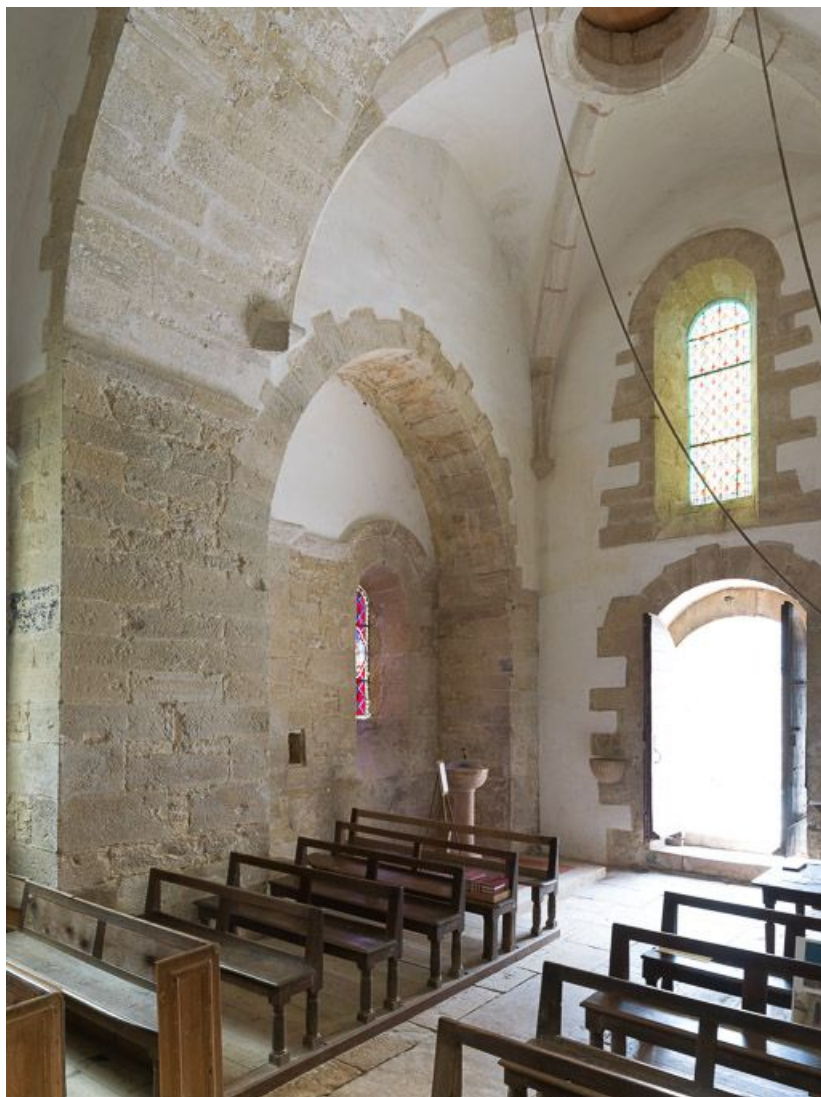
La travée sous clocher : vue de trois quarts. 21, Pernand-Vergelesses rue Jacques-Copeau
