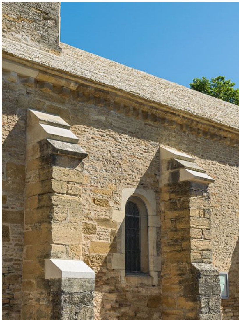
Élévation sud-ouest, détail de la travée.
