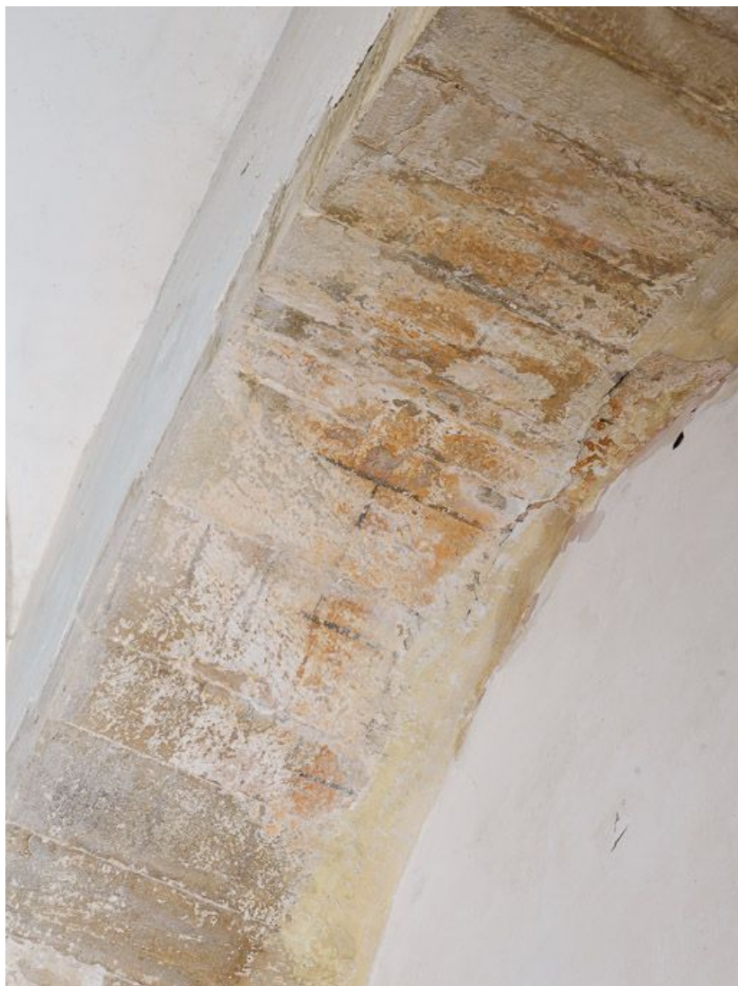
Détail des traces de peintures murales dessinant un faux appareillage, au niveau de la 1ère travée. 21, Pernand-Vergelesses rue Jacques-Copeau
