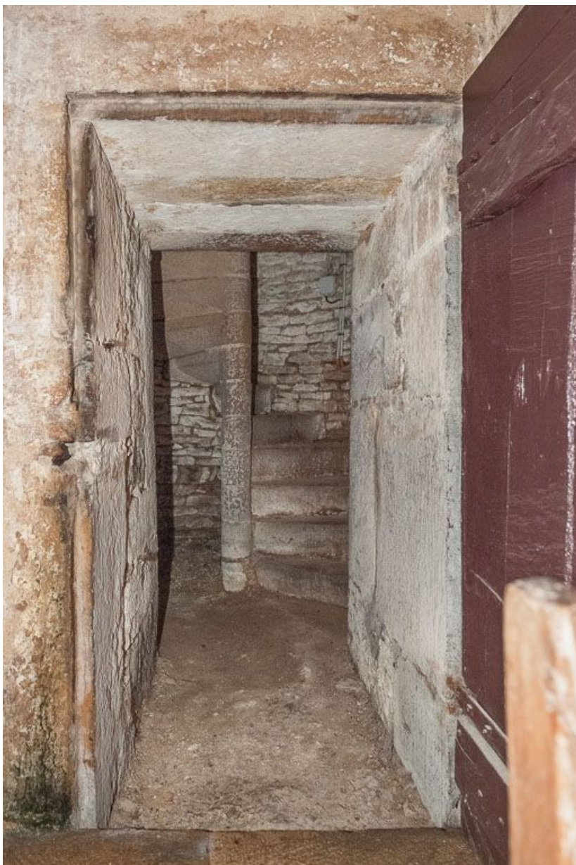
Départ d'escalier de la tourelle du clocher. 21, Pernand-Vergelesses rue Jacques-Copeau
