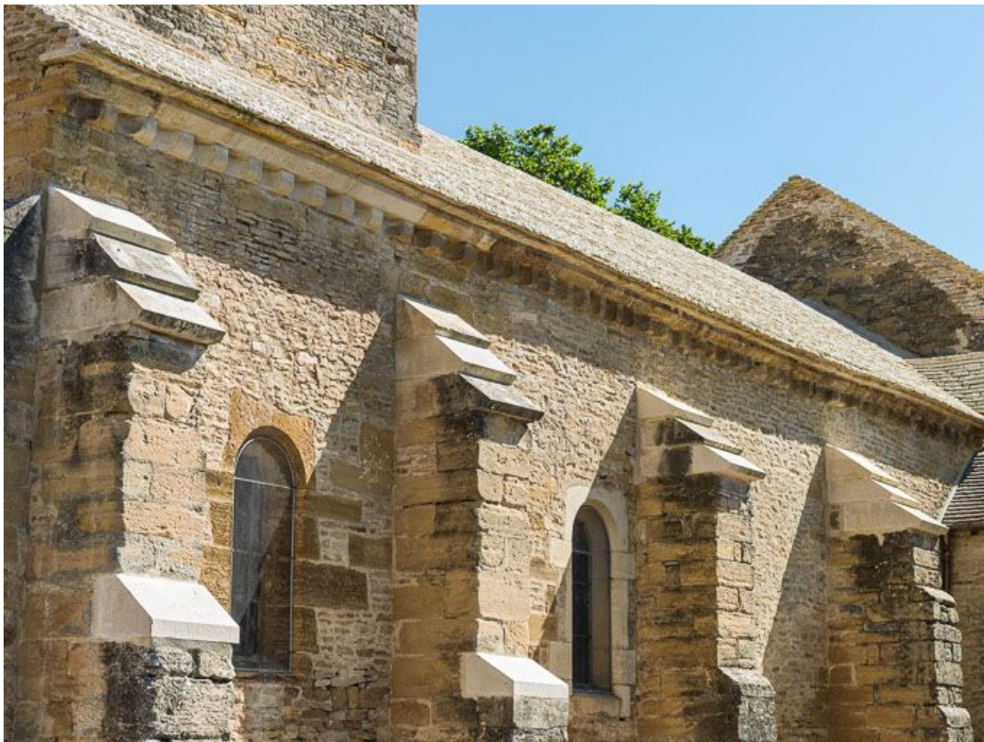
Élévation sud-ouest, détail des contreforts et de la corniche.
