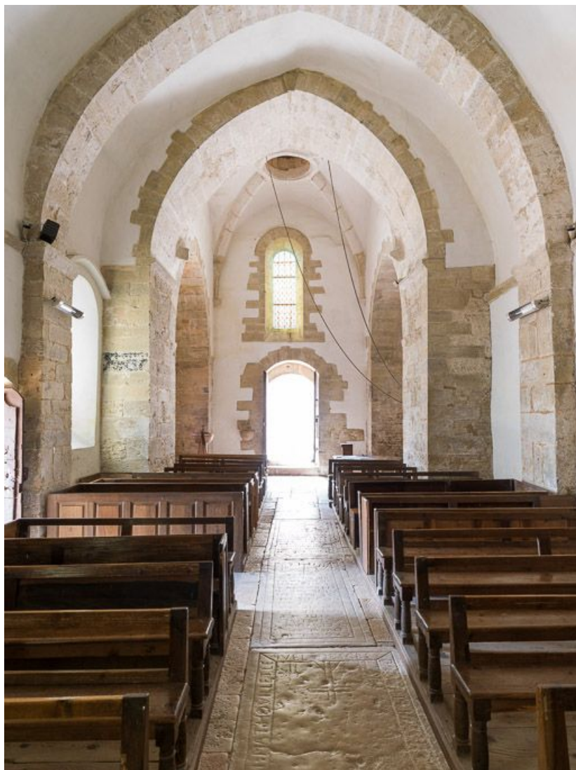
Vue des premières travées de la nef.
