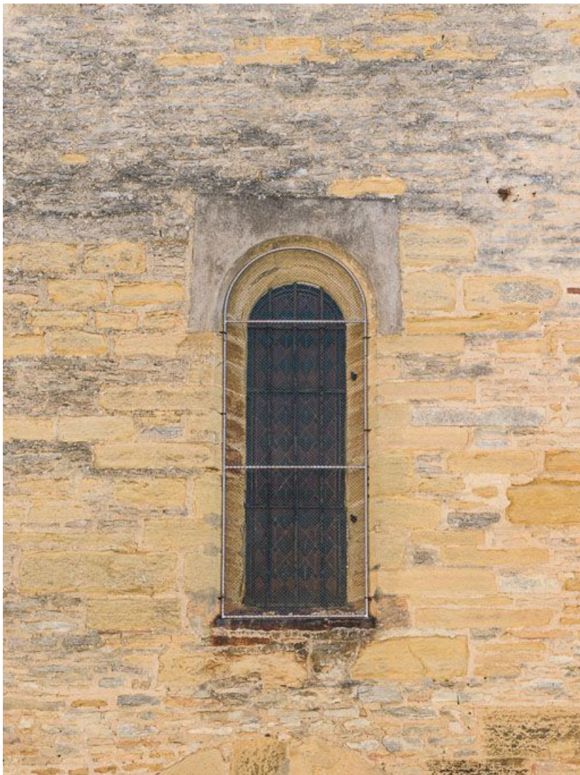
Façade : baie au dessus de la porte.
