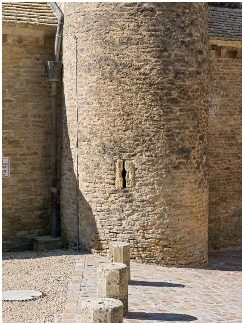
Tourelle d'escalier : détail du jour en archère.
