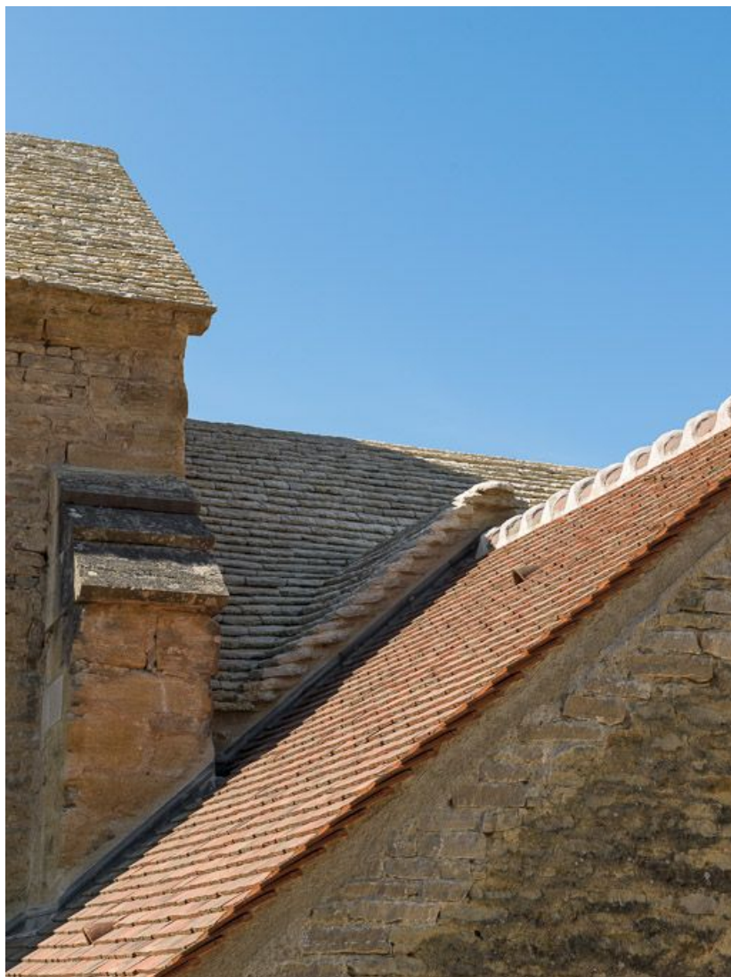
Détail des toitures du chœur, de la chapelle nord-est et de la nef.
