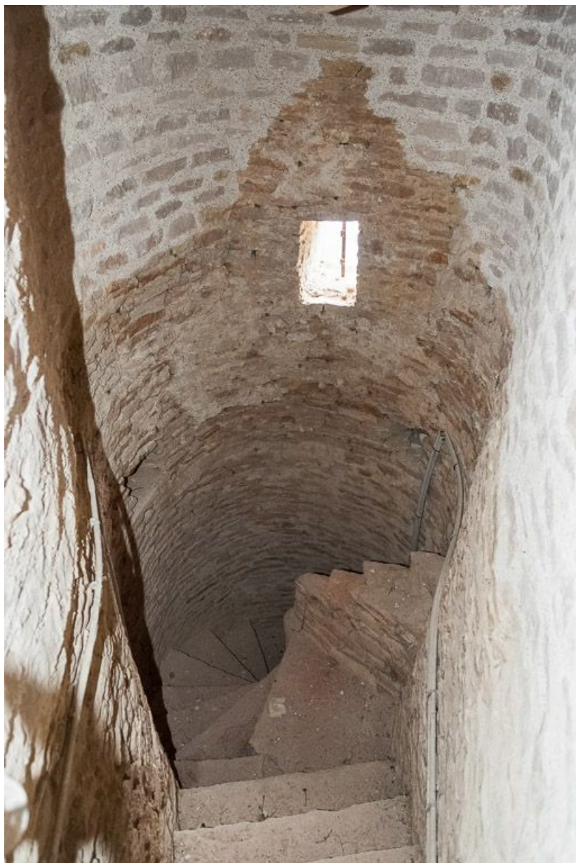
Partie supérieure de la tourelle d'escalier. 21, Pernand-Vergelesses rue Jacques-Copeau
