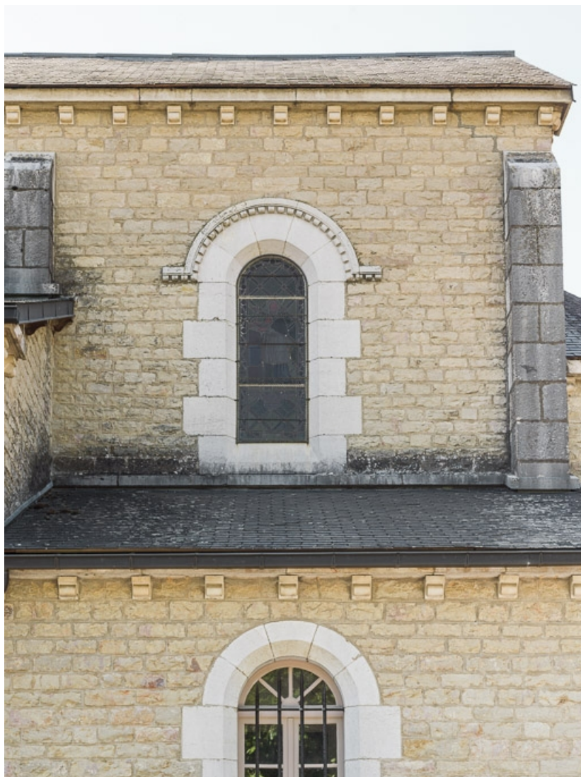
Baie est du chœur, au-dessus de la sacristie. 21, Aloxe-Corton allée Jules-Senard-Louis-Latour
