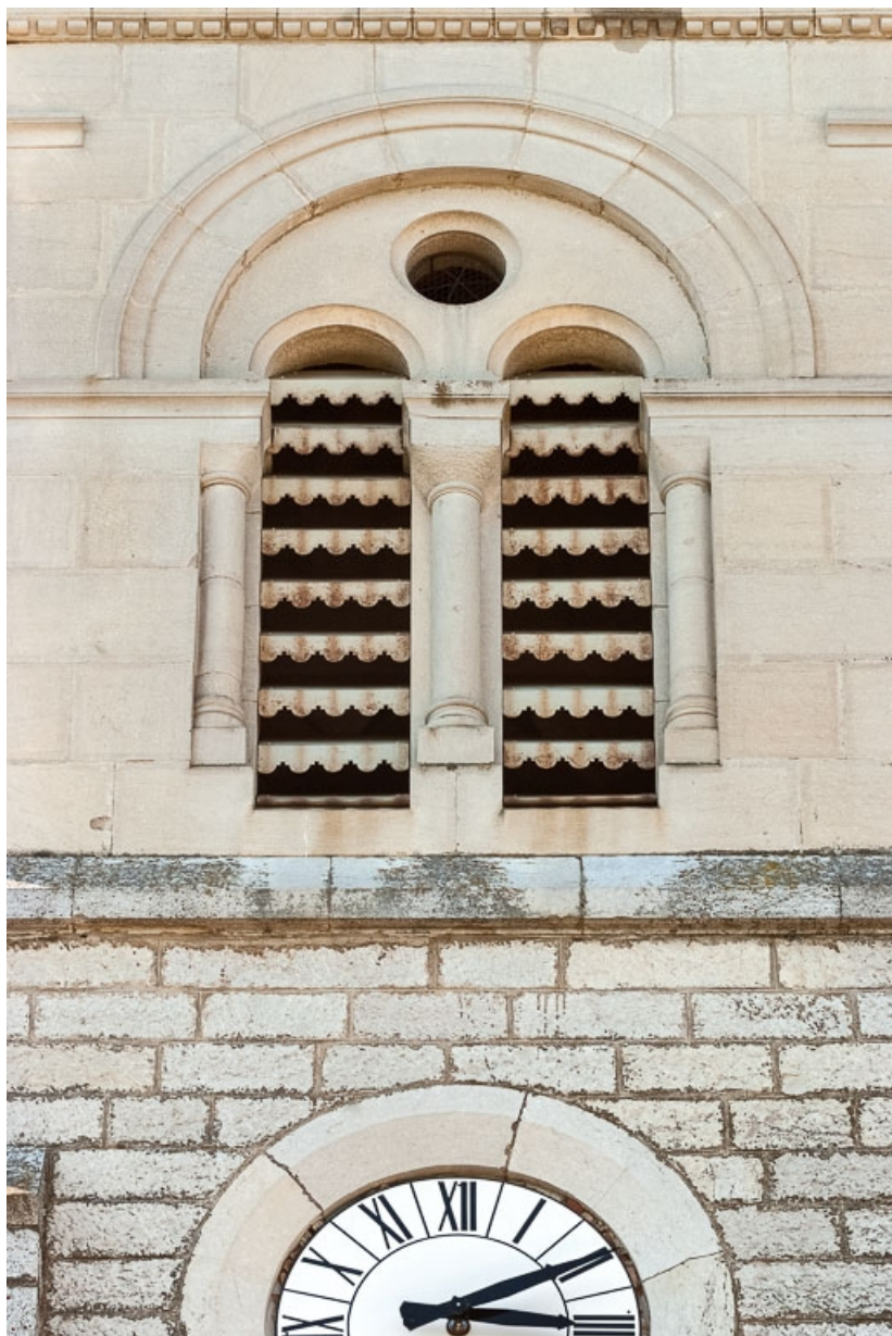
Clocher, détail des baies de l'élévation est.
