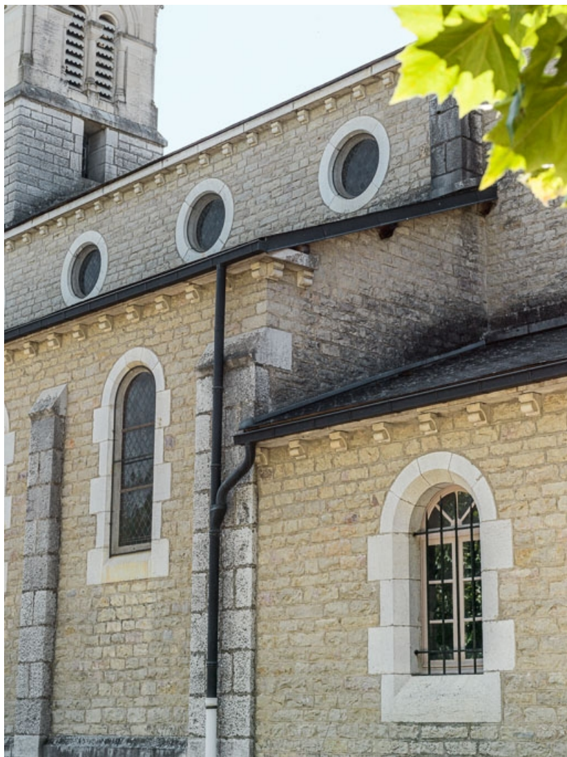
Détail élévation est, côté chevet.
