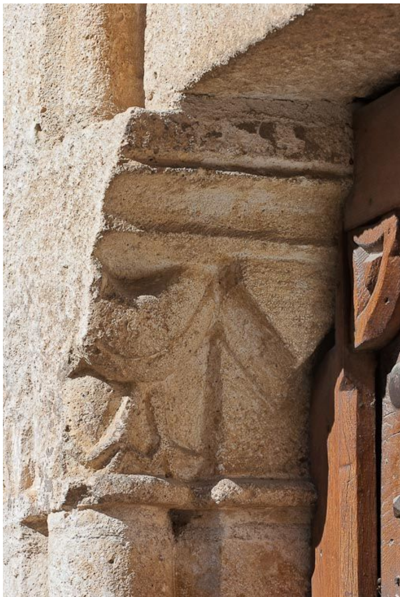
Porte latérale, détail des chapiteaux gauches. 21, Volnay Eglise
