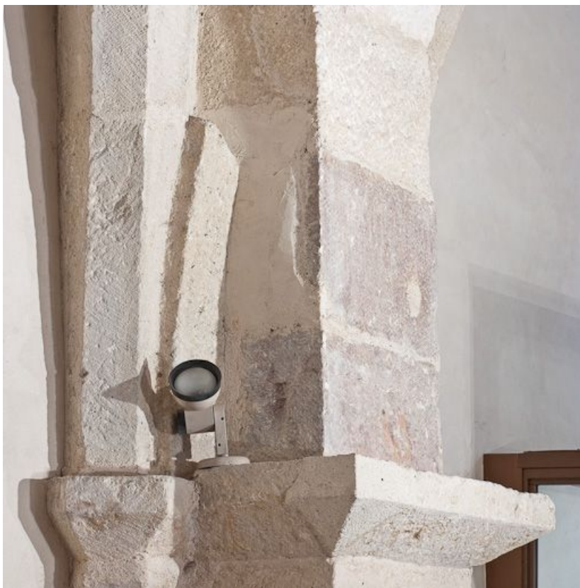
Départ des nervures de l'angle antérieur gauche de la troisième travée du bas-côté droit. 21, Volnay Eglise
