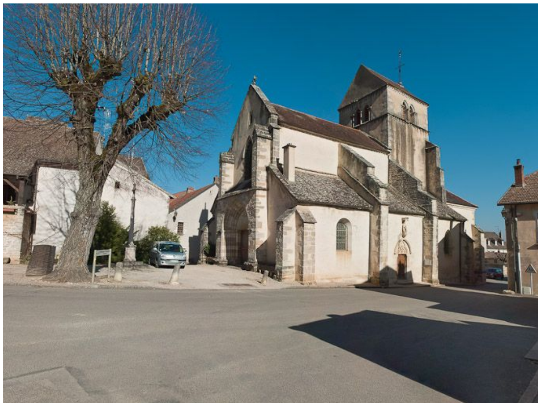
Vue d'ensemble de trois-quarts droit. 21, Volnay Eglise
