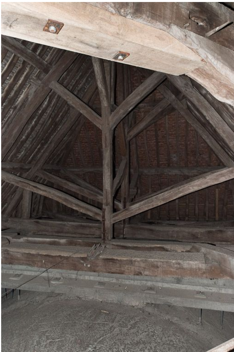
Charpente de la croisée du transept.
