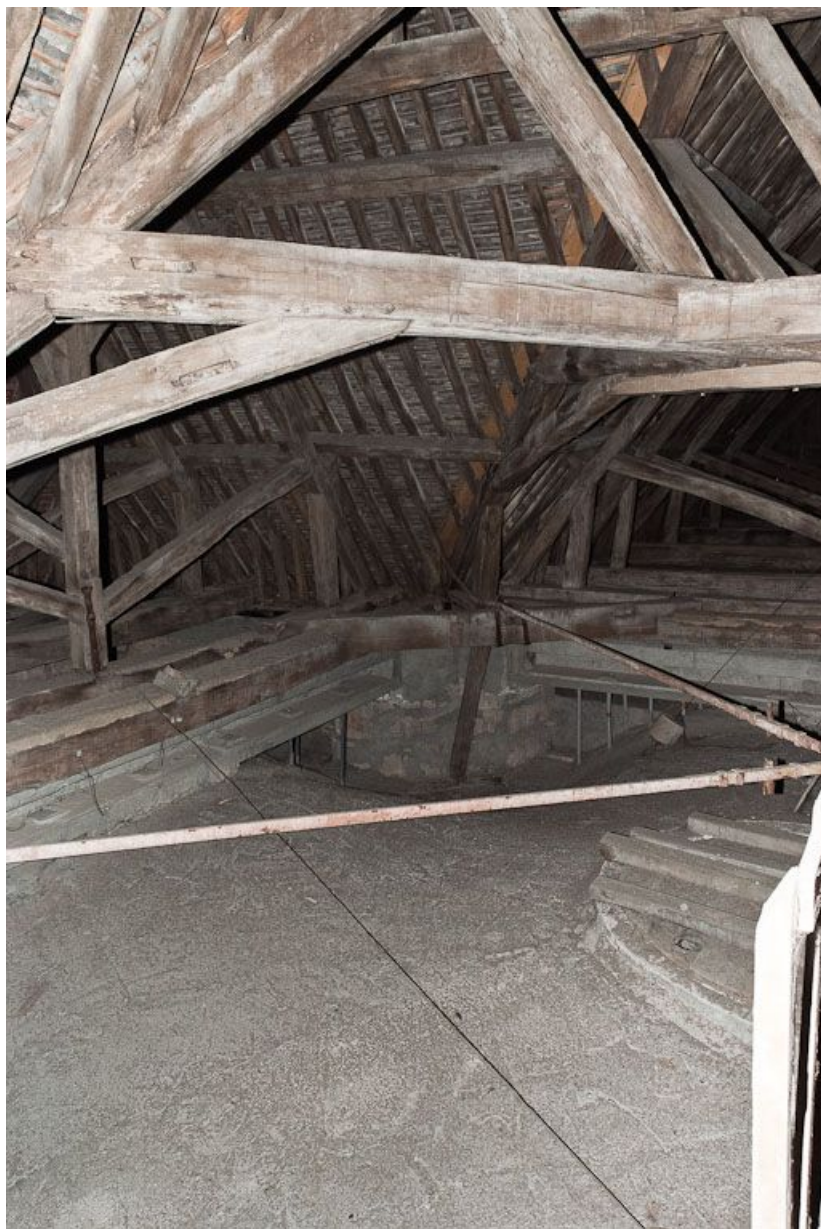
Comble du bras droit du transept.
