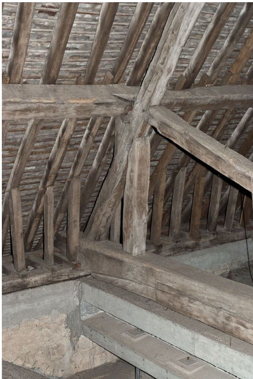
Partie du comble vers la façade : détail d'une ferme et de la sablière. 21, Pommard Métairie
