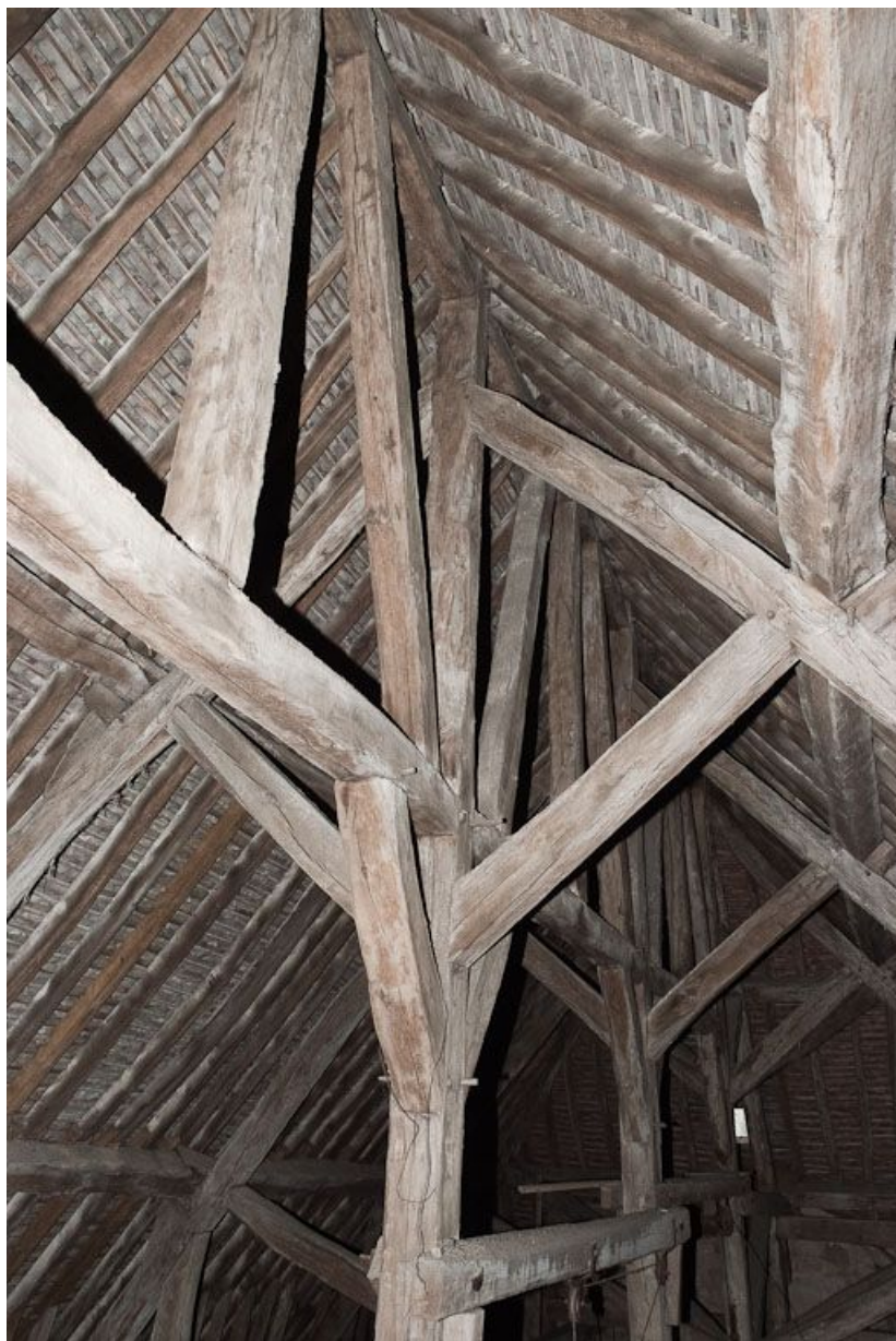
Partie du comble vers la façade : fermes et contreventement. 21, Pommard Métairie
