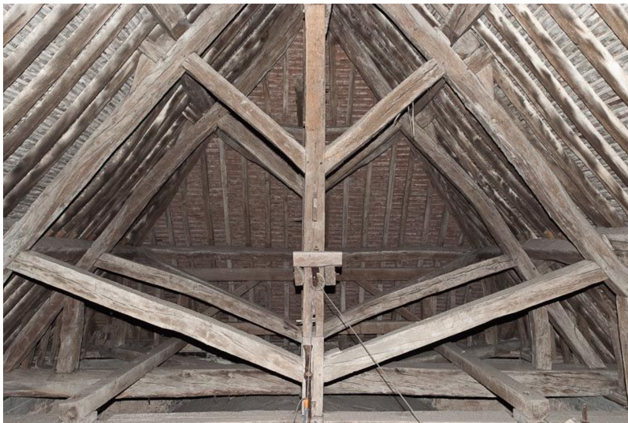
Charpente de la croisée du transept.
