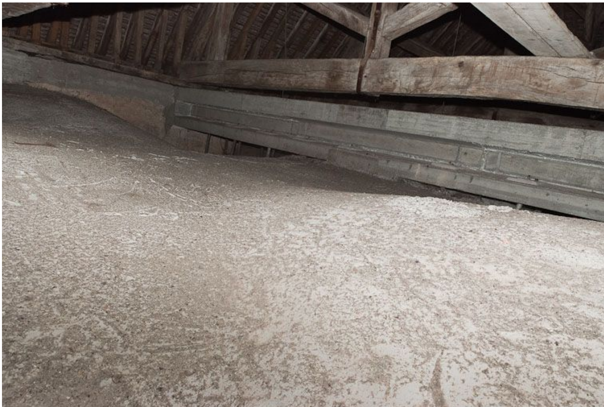
Comble de la nef : voûte et sablière.
