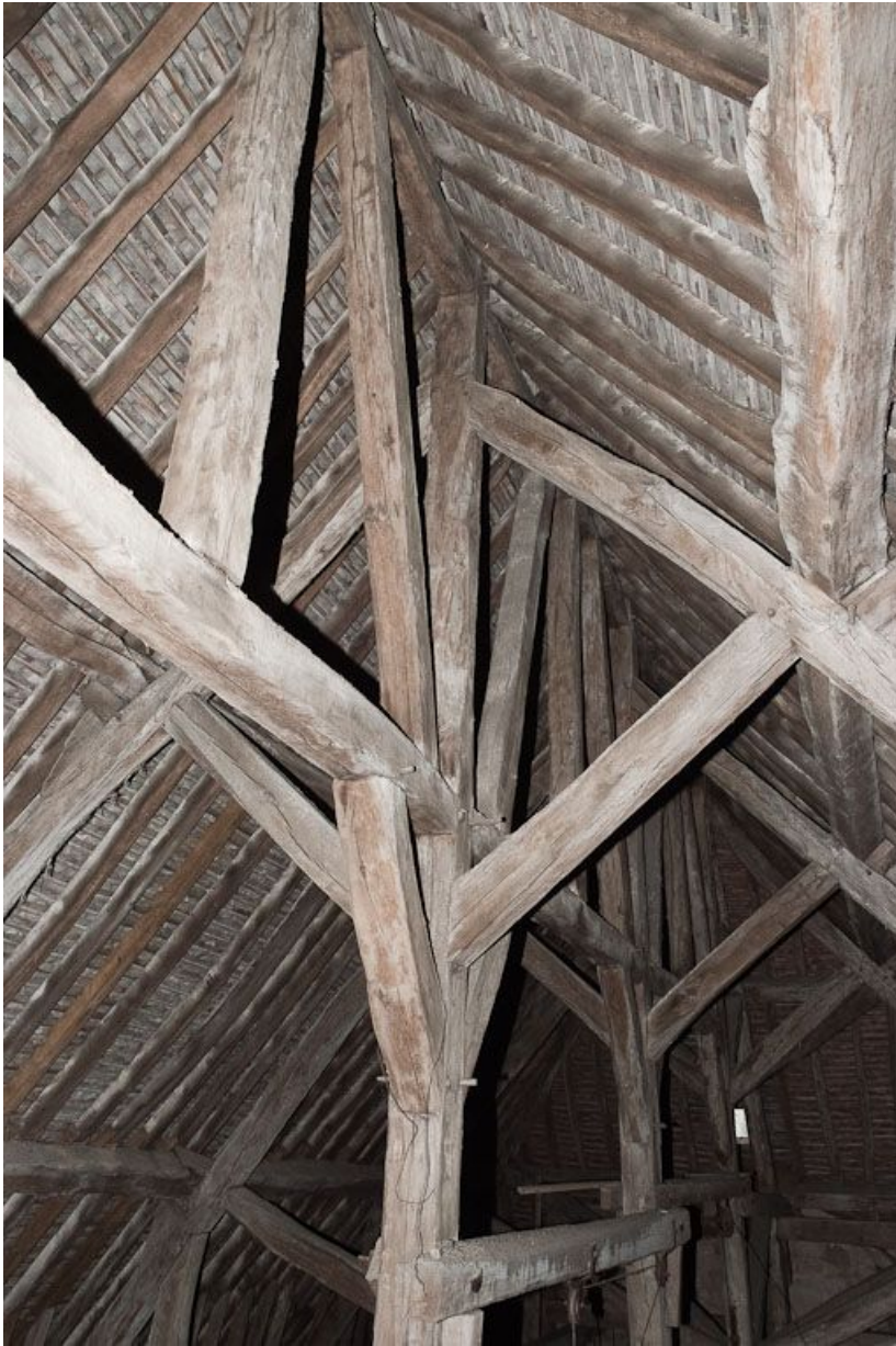
Partie du comble vers la façade : fermes et contreventement.
