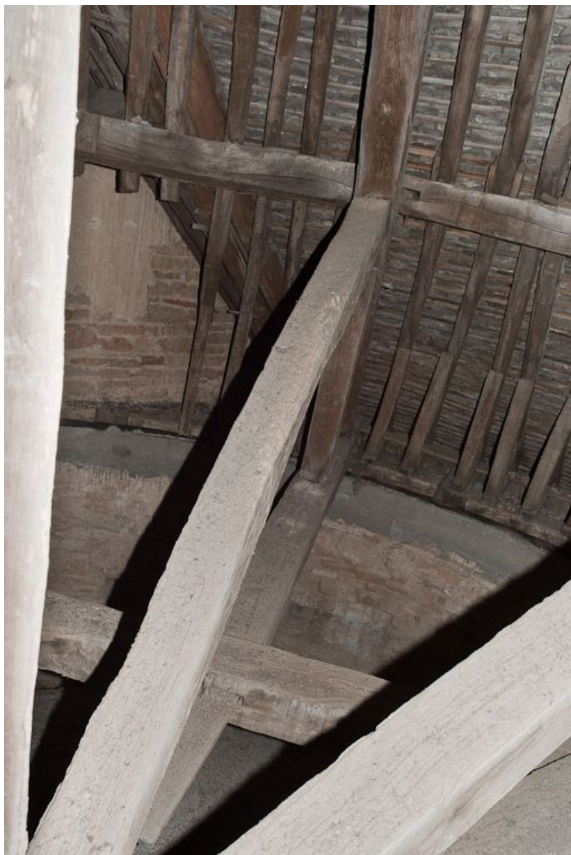
Charpente de l'abside, partie gauche. 21, Pommard Métairie
