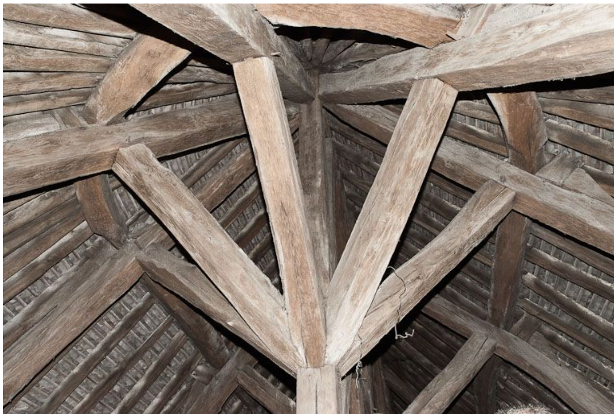
Charpente de croupe de l'abside.
