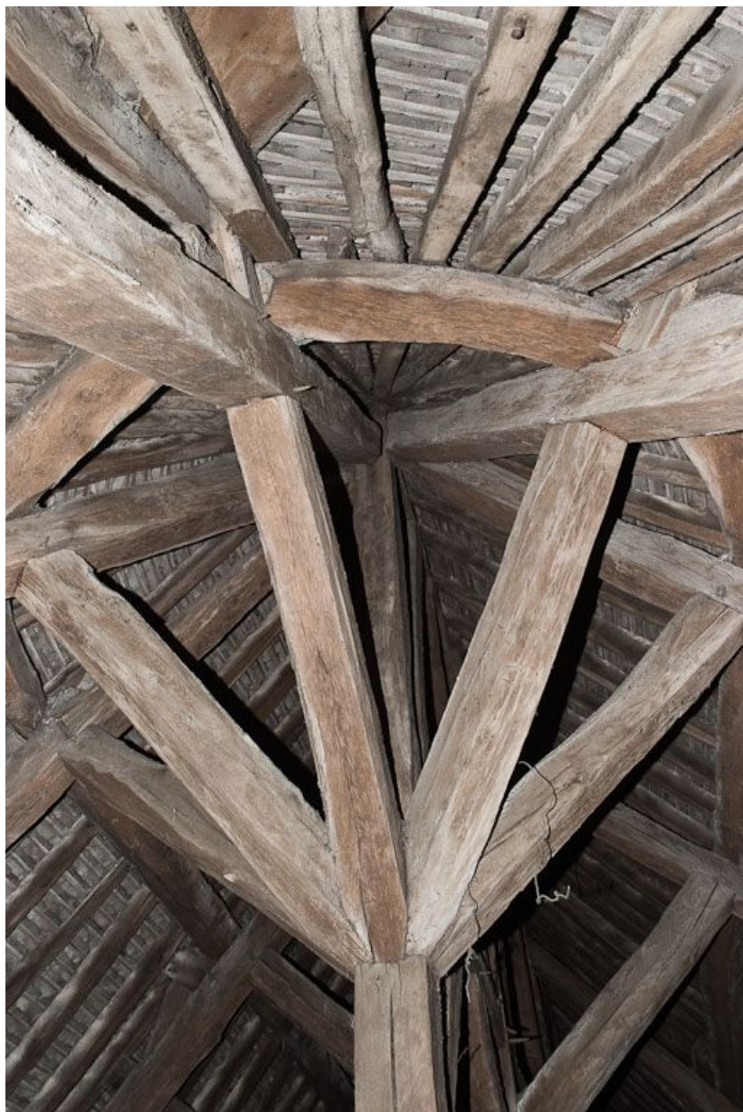
Charpente de croupe de l'abside.
