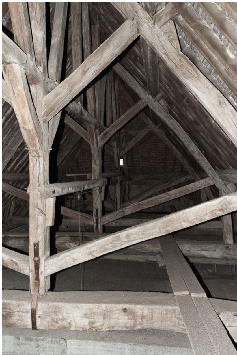
Partie du comble vers la façade.
