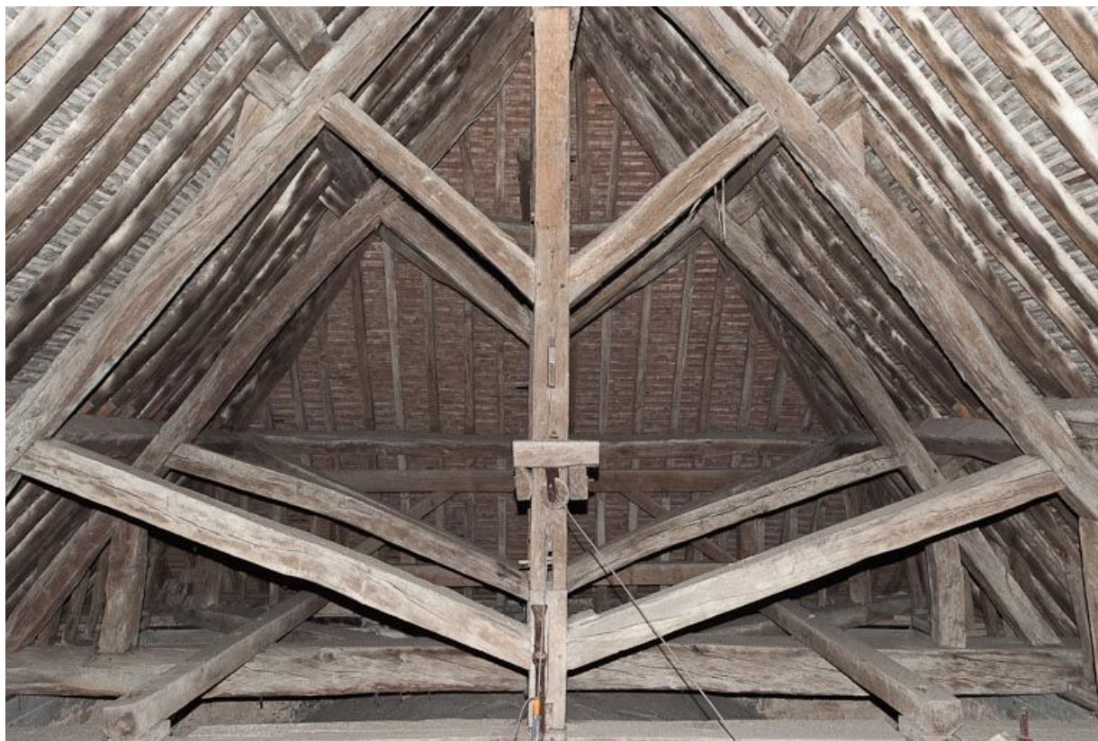
Charpente de la croisée du transept.
