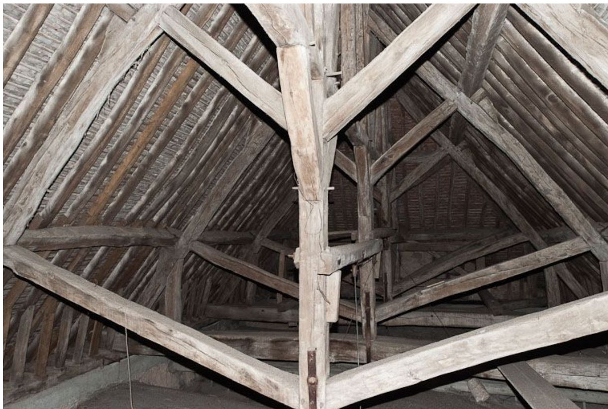
Partie du comble vers la façade.
