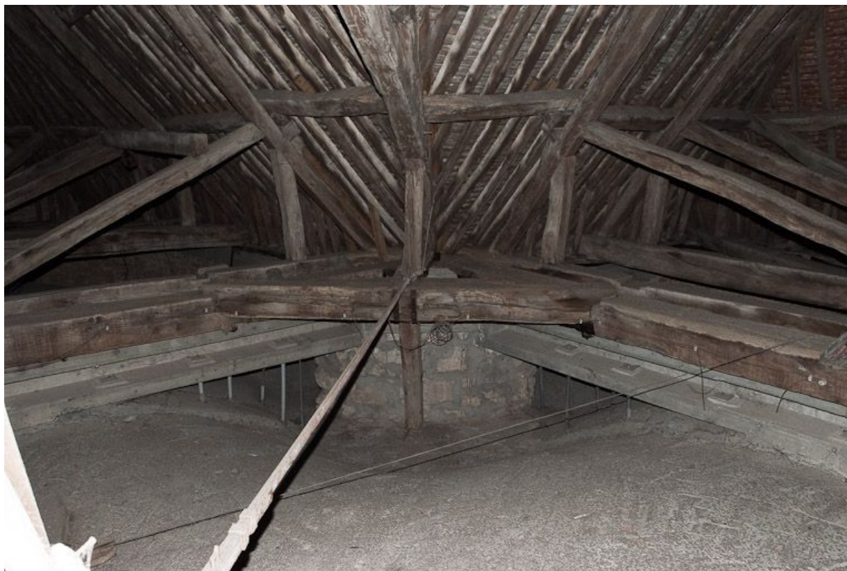
Comble : angle de la croisée du transept. 21, Pommard Métairie
