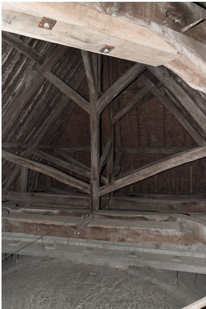
Charpente de la croisée du transept.
