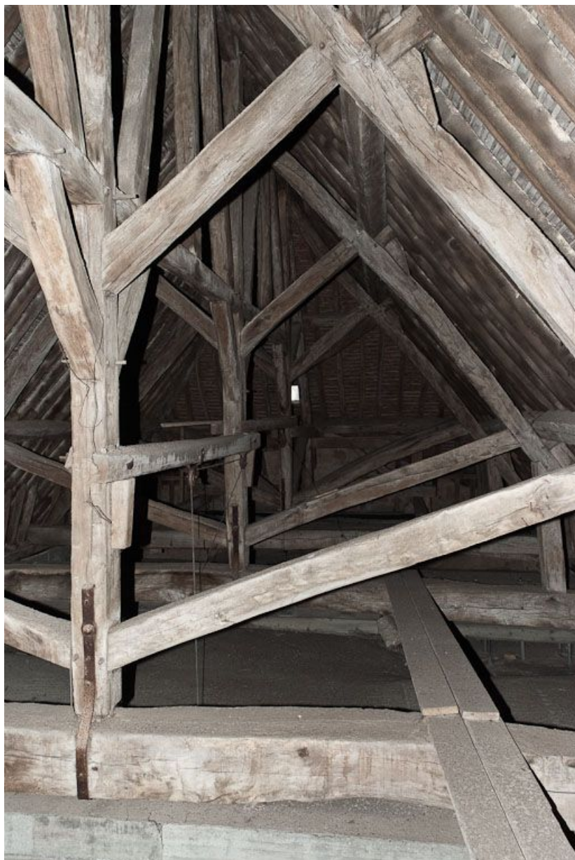
Partie du comble vers la façade.
