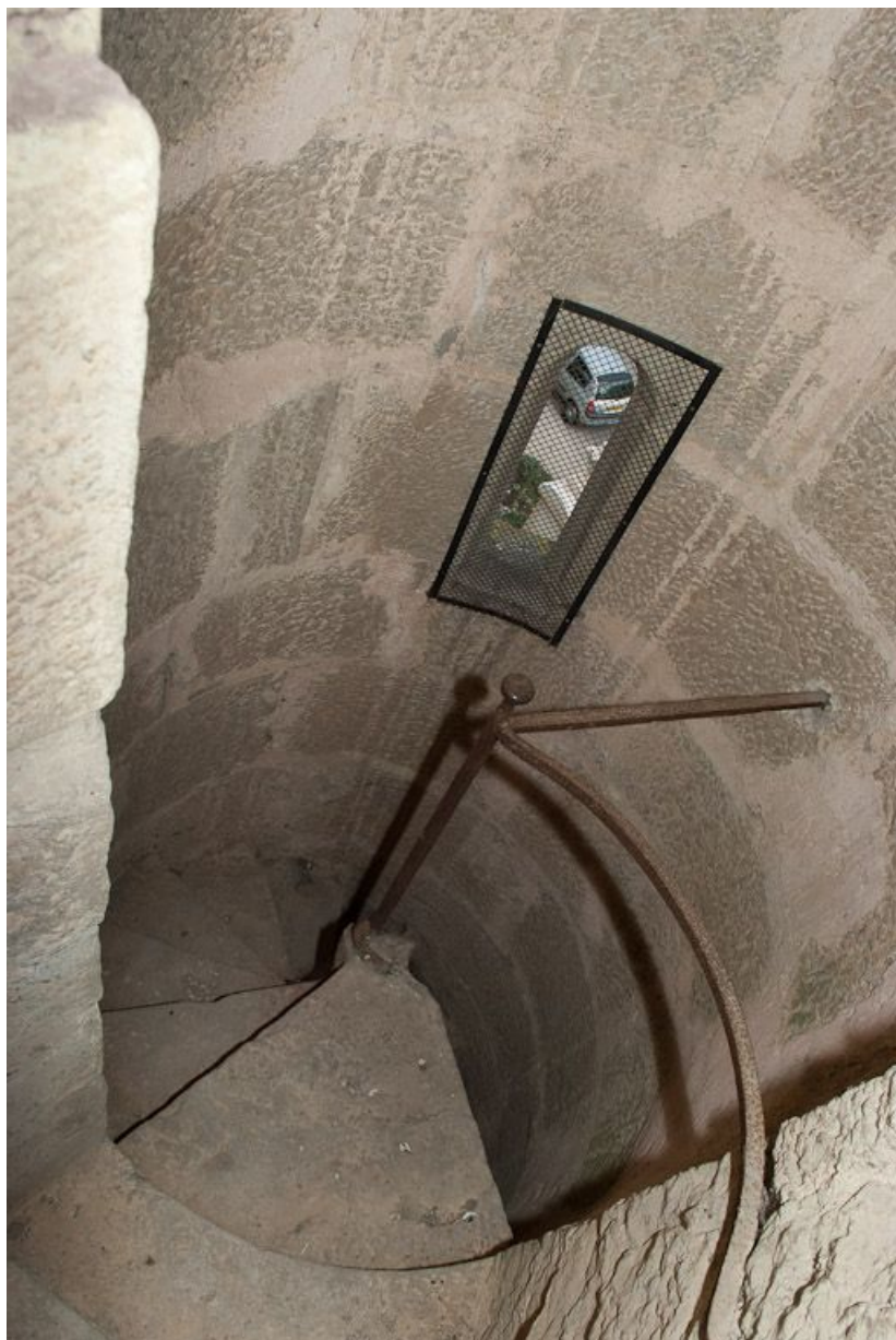
Escalier en vis du comble.
