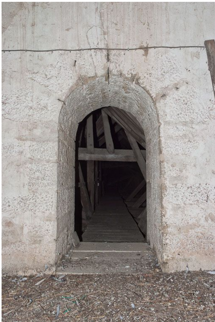
Porte du clocher ouvrant dans le comble de l'église. 21, Pommard Métairie
