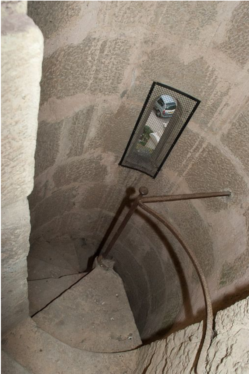
Escalier en vis du comble.
