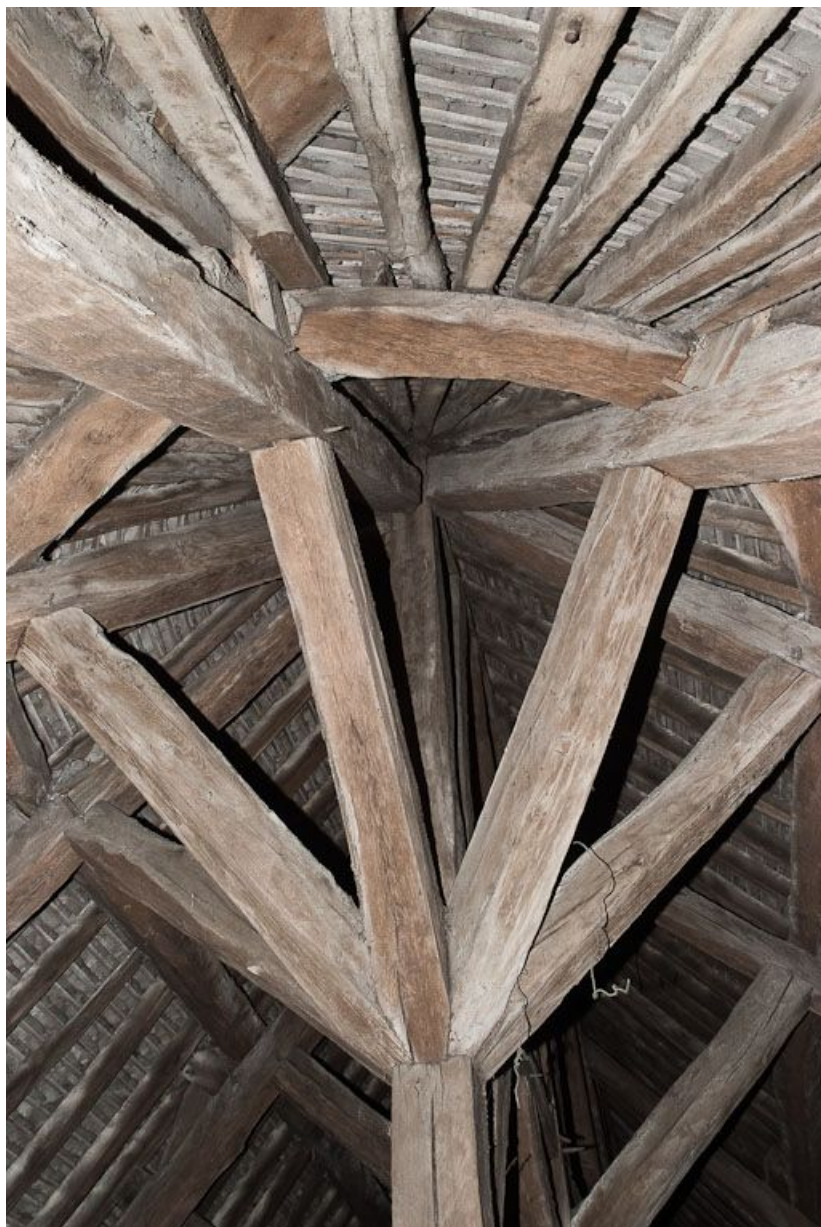
Charpente de croupe de l'abside.
