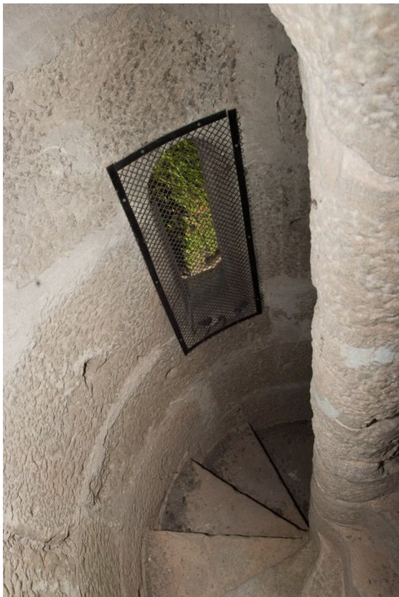
Escalier en vis du comble.
