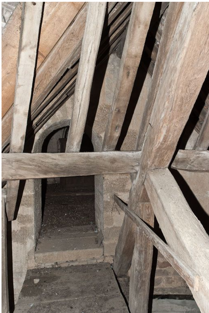
Comble de l'abside, porte donnant sur le clocher. 21, Pommard Métairie
