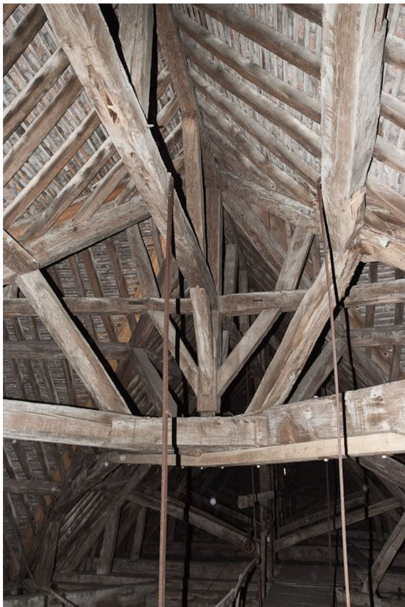
Charpente de la croisée du transept. 21, Pommard Métairie
