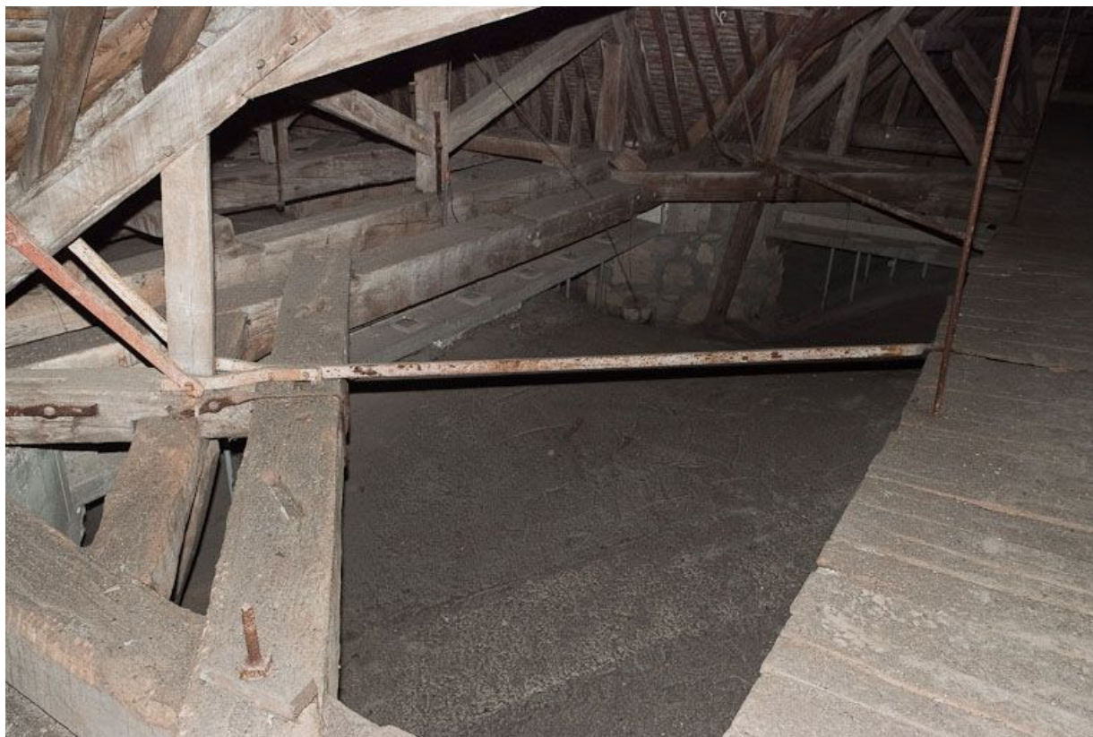
Comble du bras gauche du transept.
