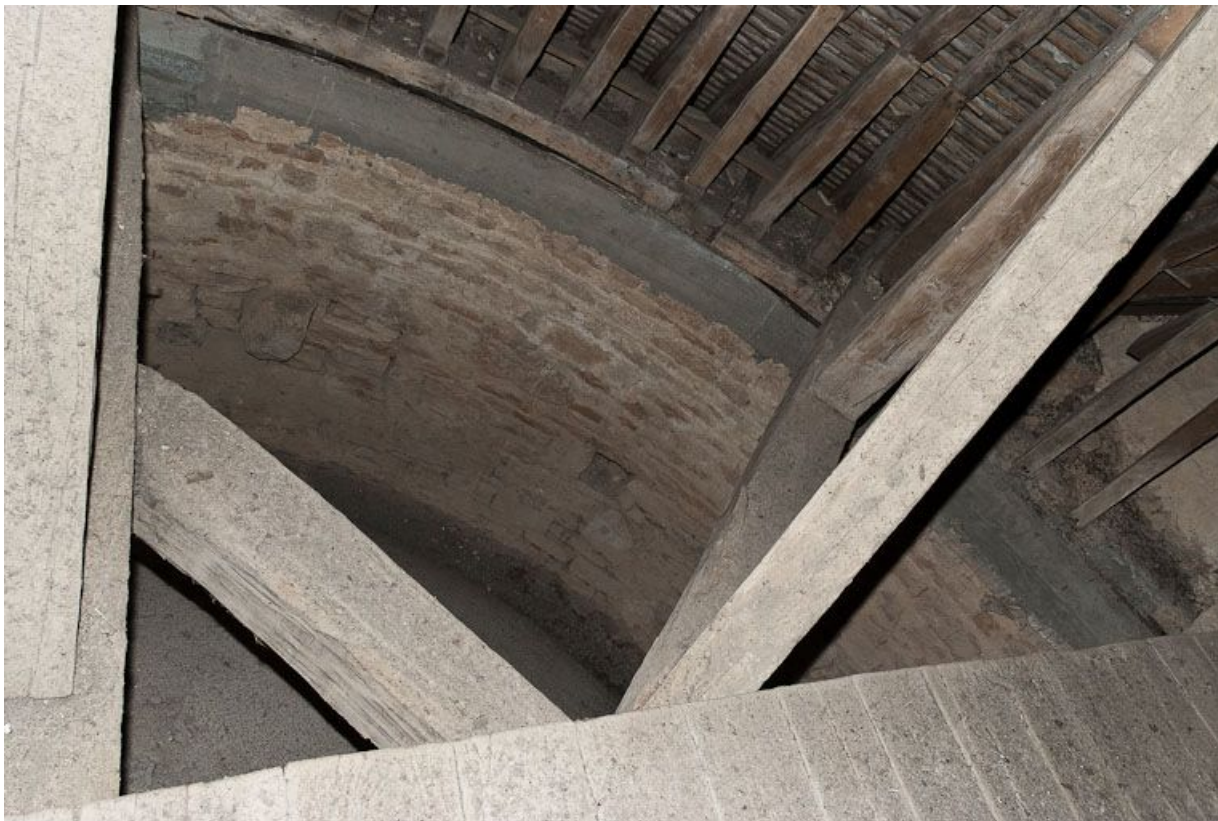
Comble de l'abside, partie gauche.
