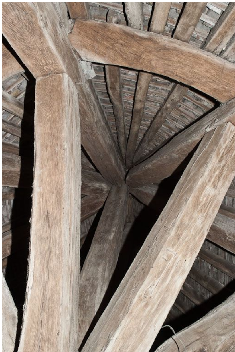
Charpente de croupe de l'abside.
