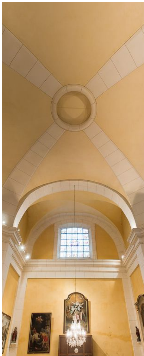
Vue de la voûte de la croisée et du bras gauche du transept. 21, Pommard Métairie
