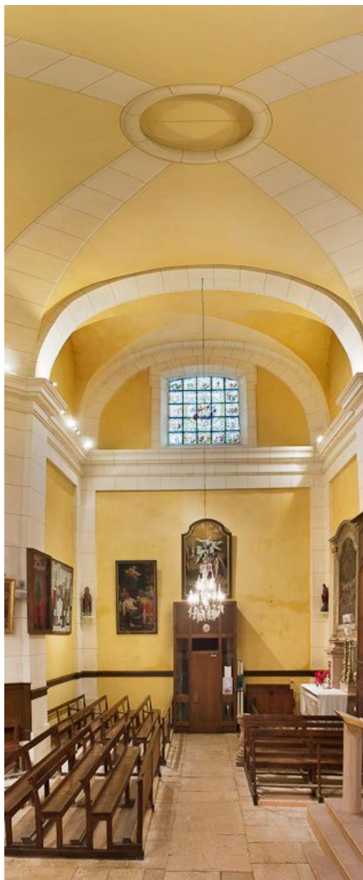
Vue du bras gauche du transept.
