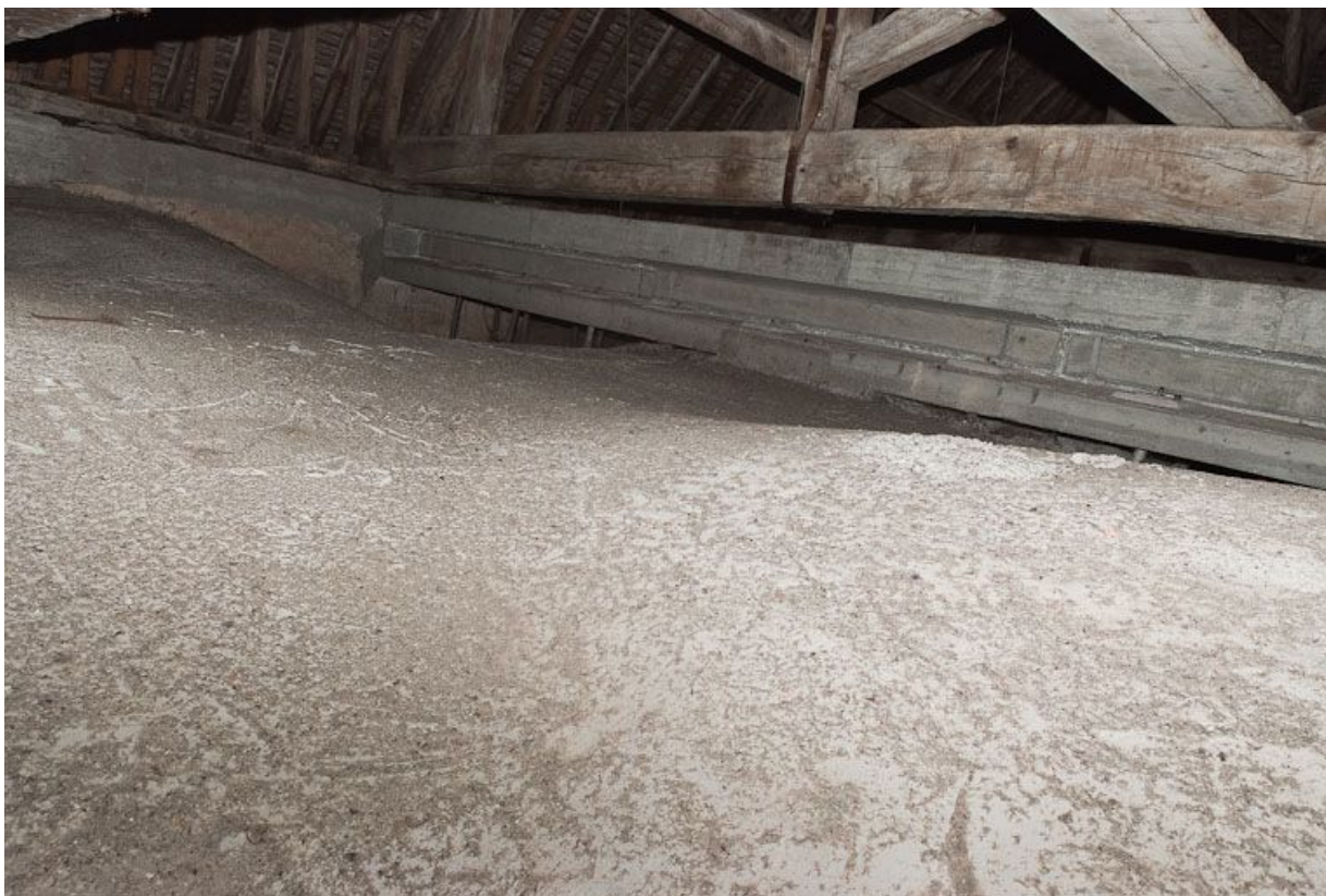
Comble de la nef : voûte et sablière.
